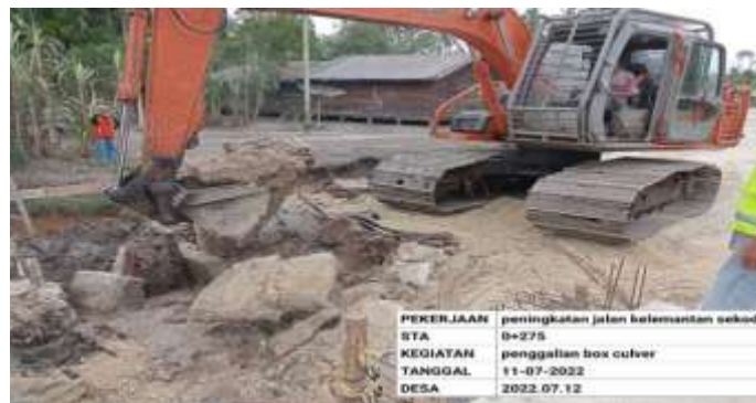
Gambar 1.8.Dokumentasi Exkavator Sumber : Dokumentasi lapangan
