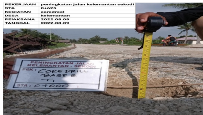
Gambar 3.16 pengukuran core base
