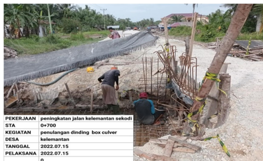
Gambar 3.5 penulangan box culvert Sumber:dokumentasi lapangan 2022
