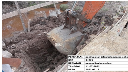
Gambar 3.5 penggalian box culvert Sumber:dokumentasi lapangan 2022
