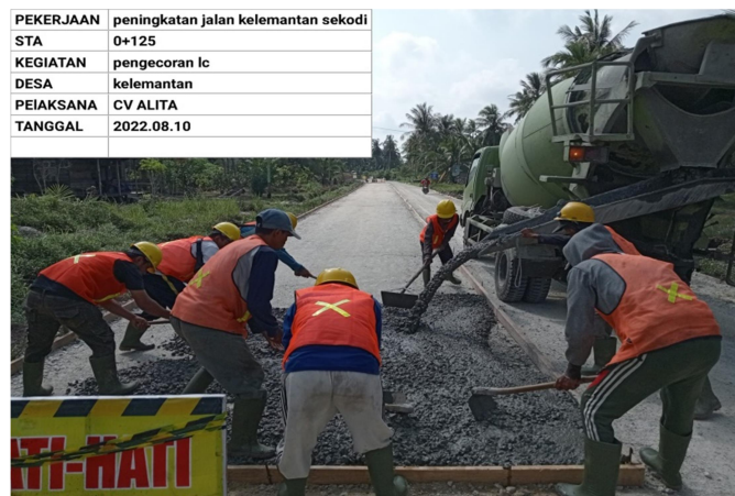
Gambar 3.17 pengecoran LC
