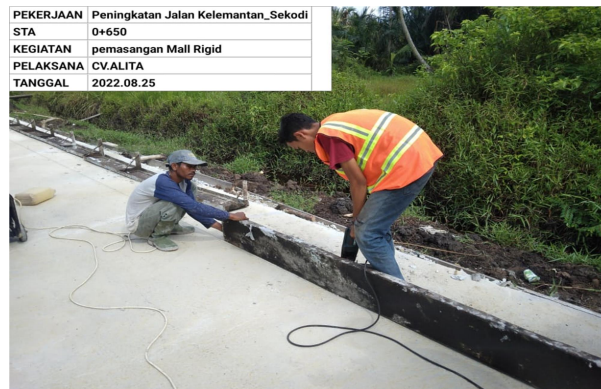
Gambar 3.18 pemasangan bekisting rigid
