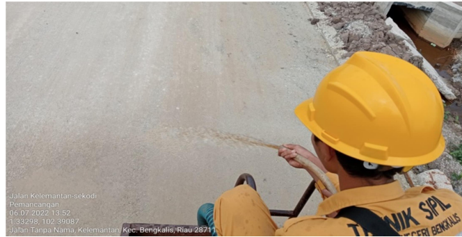
Gambar 3.9 penyiaman base /perawatan base b
