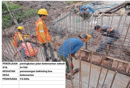
Gambar 3.7 pemasangan bekisting
