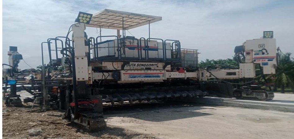
Gambar 3.14. Pekerjaan perkerasan beton menggunakan alat wirtgen(Sumber : Dokumentasi Lapangan,2022)
