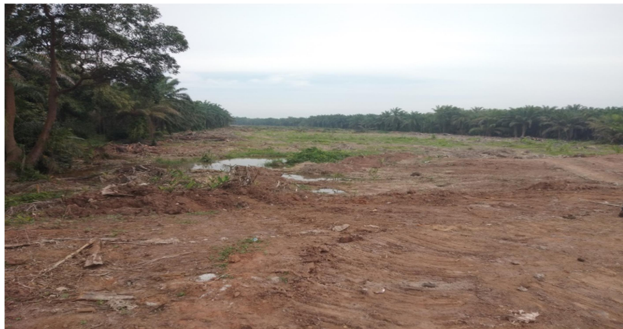
Gambar 3.3. Pembersihan lahan ( clearing ) (Sumber : Dokumentasi Lapangan, 2022)
