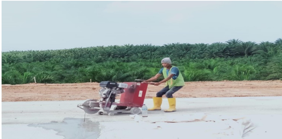
Gambar 3.18. Pemotongan pada segmen beton (Sumber : Dokumentasi Lapangan,2022)
