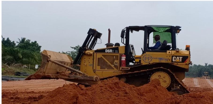
Gambar 3.6. Penghamparan tanah (Sumber : Dokumentasi Lapangan,2022)
