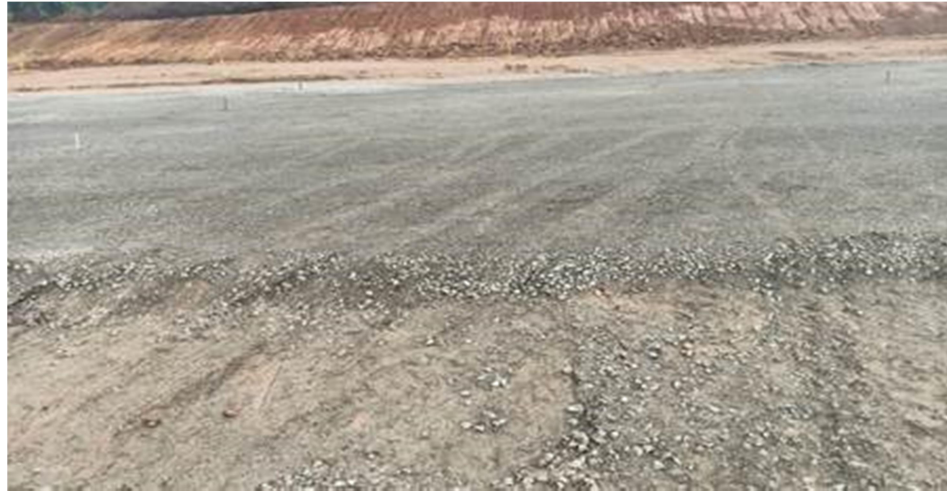
Gambar 3.11. lapis drainase (Sumber : Dokumentasi Lapangan,2022)
