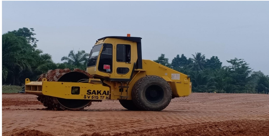
Gambar 3.7. Pemasatan tanah dengan roller sheepfool (Sumber : Dokumentasi Lapangan,2022).
