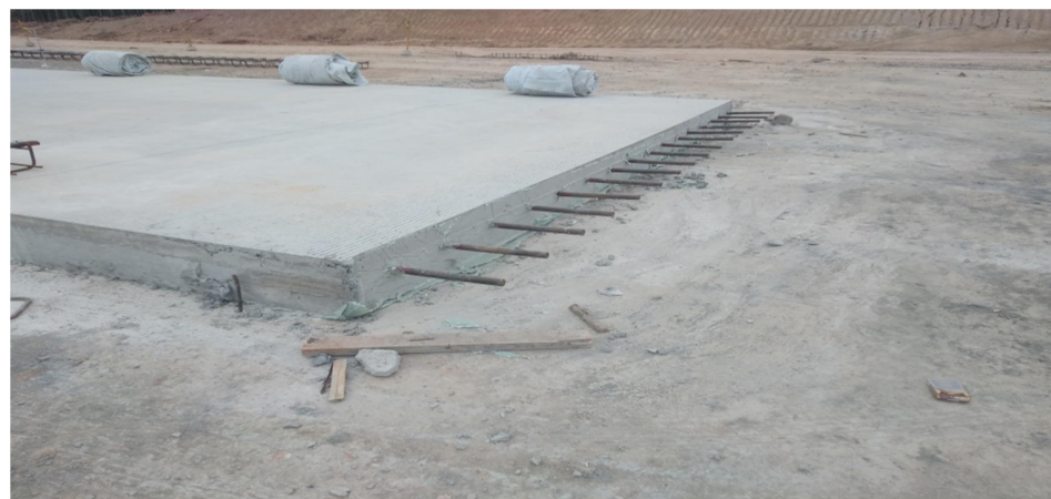
Gambar 3.15. Slab Beton (Sumber : Dokumentasi Lapangan,2022)
