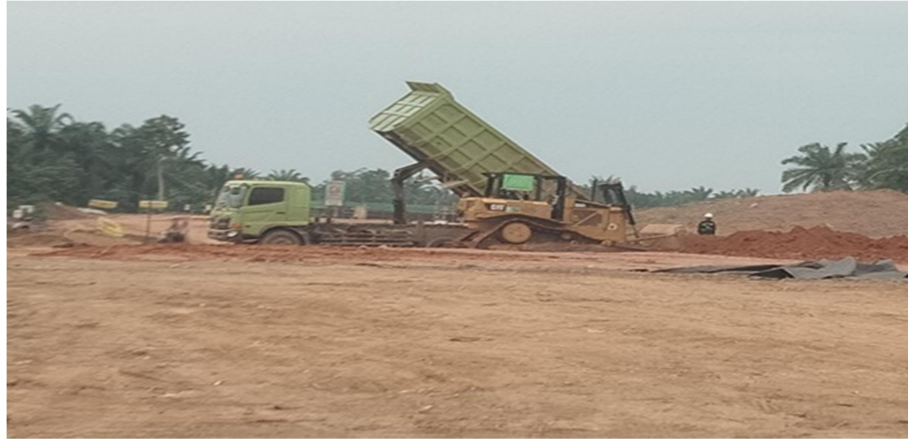
Gambar 3.4. Pembongkaran material dari truck (Sumber : Dokumentasi Lapangan,2022)
