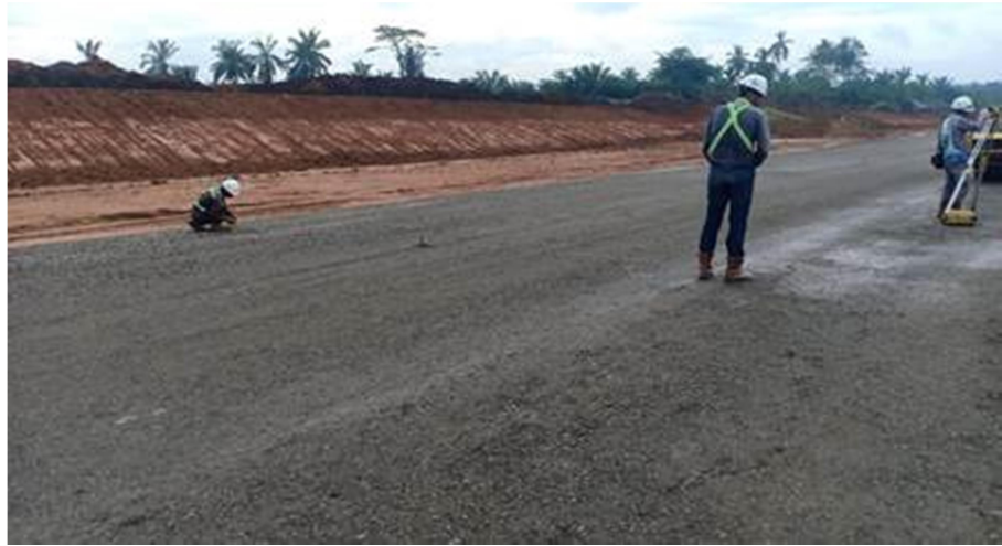
Gambar 3.12. survey elevasi (Sumber : Dokumentasi Lapangan,2022)
