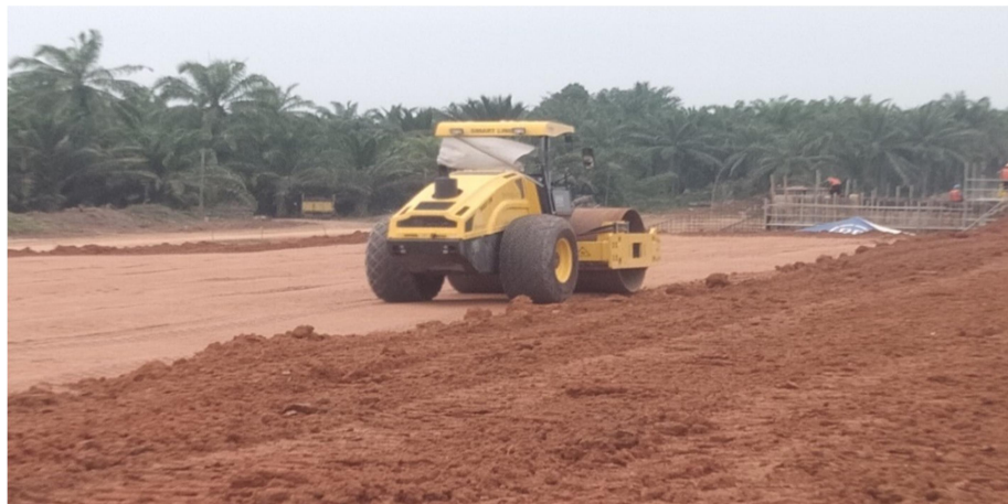
Gambar 3.8. Pemasatan tanah dengan viriation roller (Sumber : Dokumentasi Lapangan,2022)
