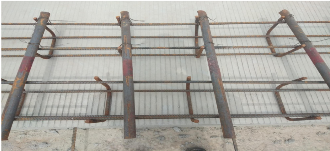
Gambar 3.20. Dowel (Sumber : Dokumentasi Lapangan, 2022)
