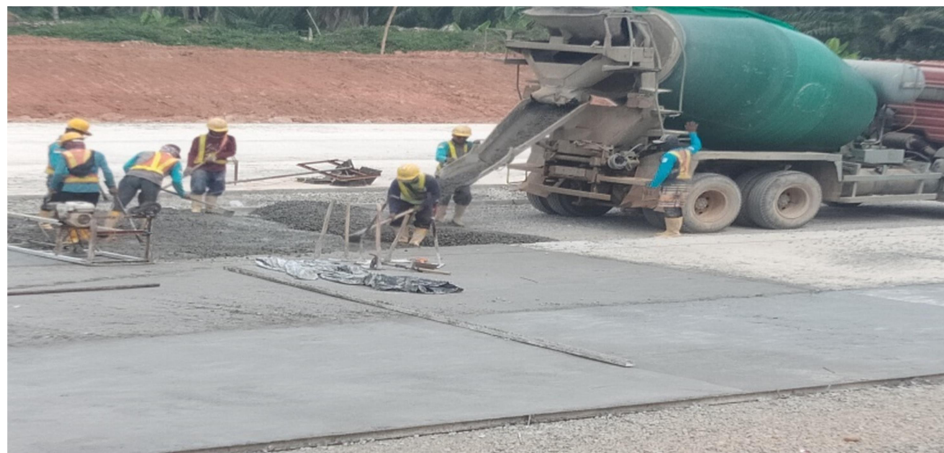
Gambar 3.13. Lean Concrete (Sumber : Dokumentasi Lapangan,2022)
