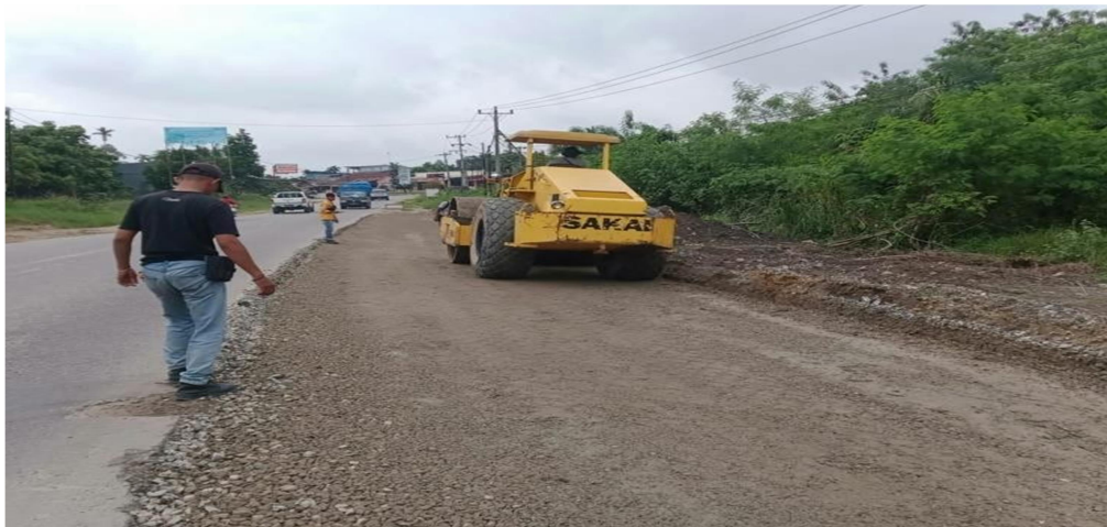
Gambar 3. 15 Proses Pematatan Base B Menggunakan Vibrtaion Roller Sumber : dokumentasi lapangan 2022
