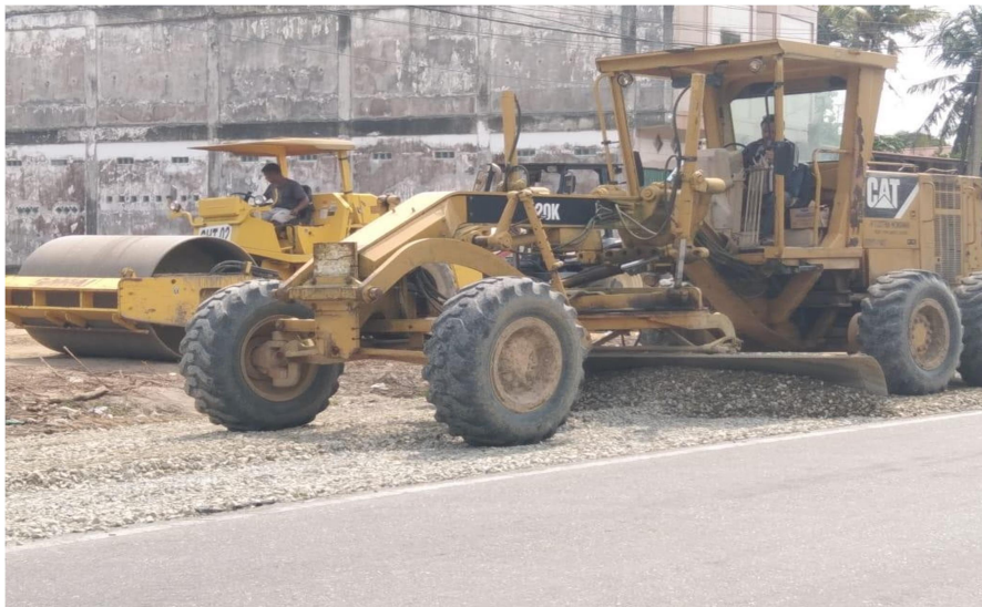
Gambar 3. 18 Penghampanan Base A Menggunakan Motor Greder Sumber : dokumentasi lapangan 2022
