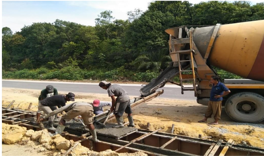
Gambar 3. 23 Proses Pengecoran Drainase Menggunakan Mixer Truck Sumber : dokumentasi lapangan 2022
