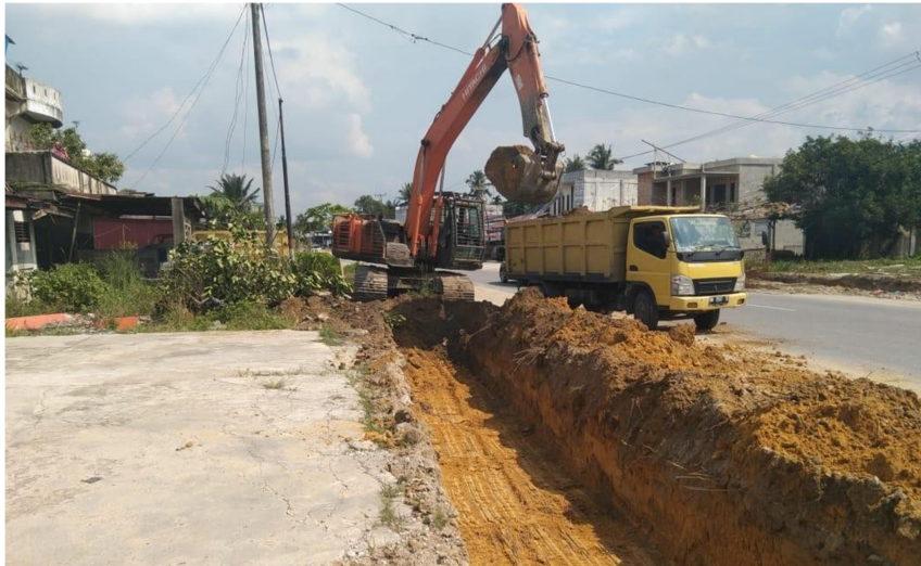
Gambar 3. 21 Perkerjaan Galian Drainase Sumber : dokumentasi lapangan 2022
