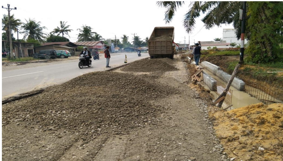
Gambar 3. 13 Penimbunan Material Lapis Pondasi Agregat B Sumber : dokumentasi lapangan 2022
