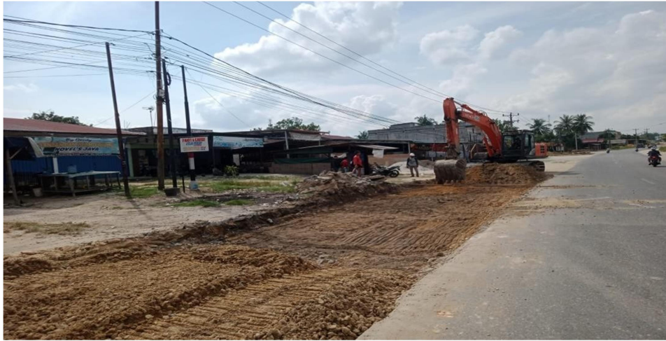
Gambar 3. 12 Perkerjaan Galian Bahu Jalan Sumber : dokumentasi lapangan 2022
