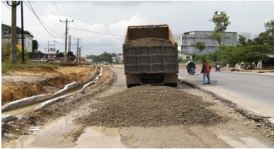
Gambar 3. 17 Penimbunan Material Base A Sumber : dokumentasi lapangan 2022
