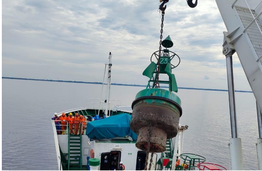
Gambar 3.2.4 Pengangkatan pelampung suar
