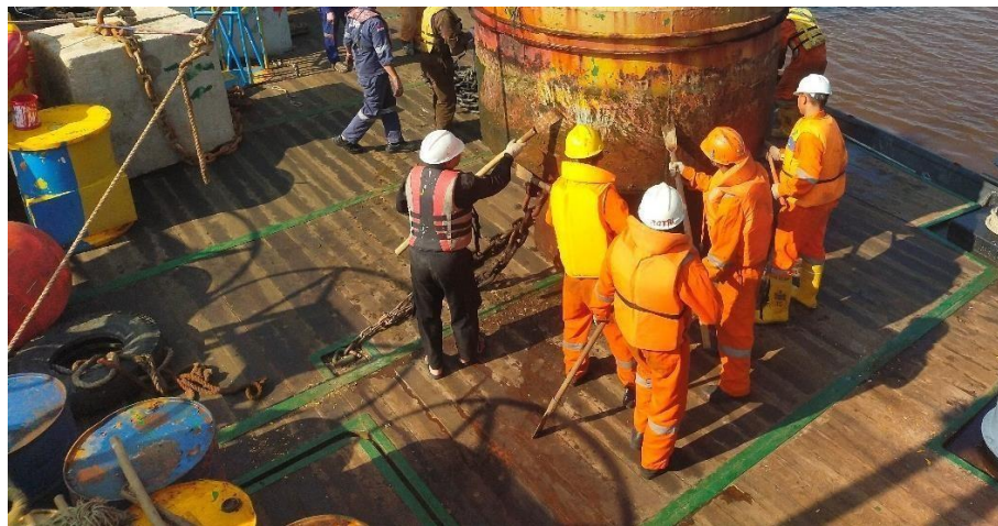
Gambar 3.2.5.1 proses pembersihan pelampung suar
