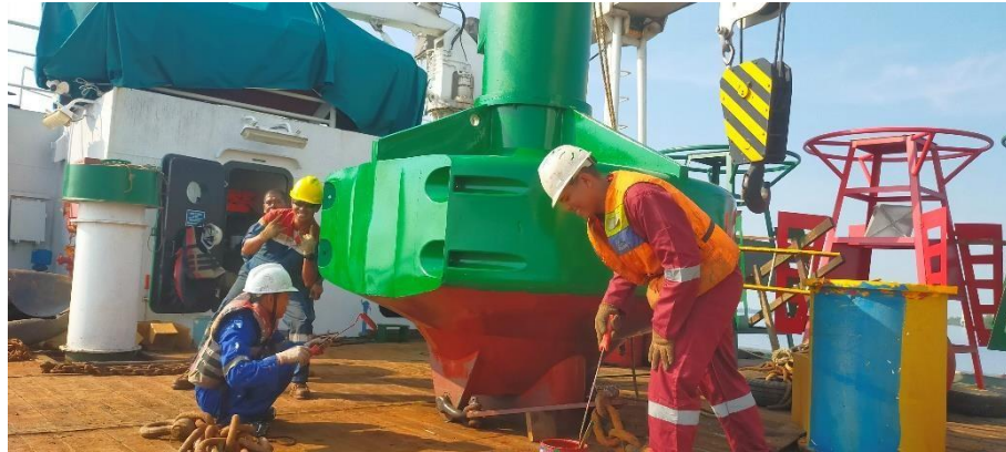
Gambar 3.2.5.3 proses pengecatan pelampung suar
