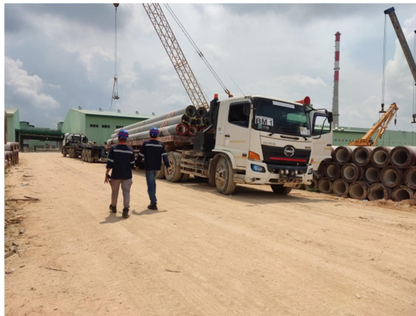
Gambar 3. 9 Proses Pengangkutan Spun Pile Sumber : Doumentasi Lapangan, 2022
