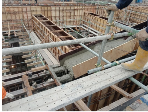
Gambar 3. 18 Pengecoran Beams Machine Track Sumber : Dokumentasi lapangan, 2022
