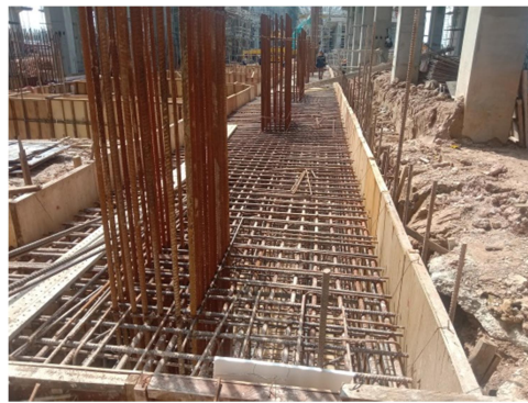
Gambar 3. 19 Tulangan Ground Beams Dan Column Machine Track Sumber : Dokumentasi lapangan, 2022
