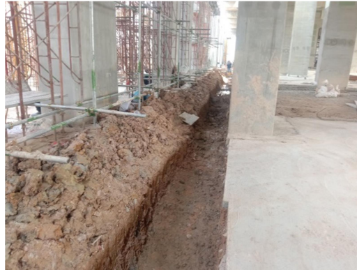
Gambar 3. 22 Penggalian Drainase . Sumber : Dokumentasi lapangan, 2022.
