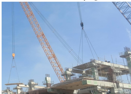
Gambar 3. 15 Erection Slab Sumber : Dokumentasi lapangan, 2022
