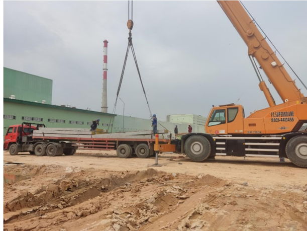
Gambar 3. 10 Proses Unloading Spun Pile Sumber : Doumentasi Lapangan,2022
