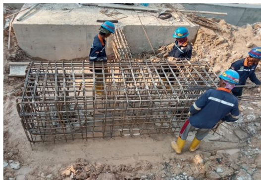
Gambar 3. 13 Ground Beam Sumber : Dokumentasi lapangan, 2022
