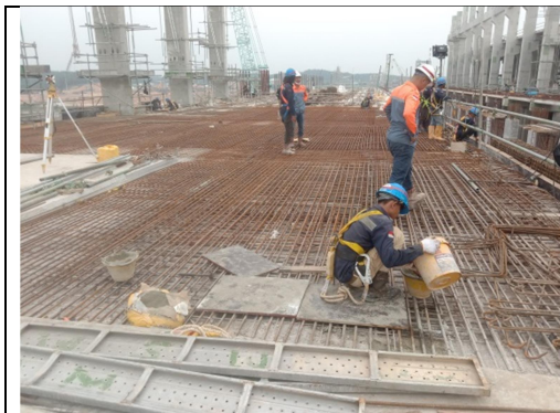
Gambar 3. 20 Pemasagan Wermesh Sumber : Dokumentasi lapangan, 2022
