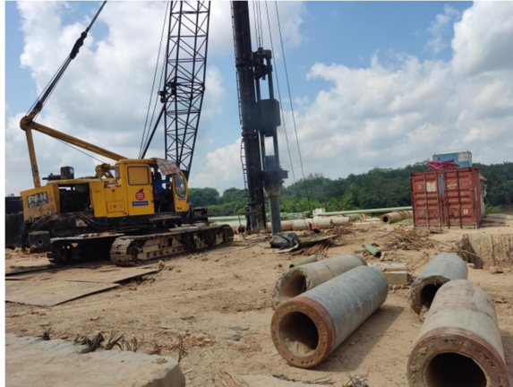
Gambar 3. 11 Proses Pemancangan Spun Pile Sumber : Doumentasi Lapangan,2022
