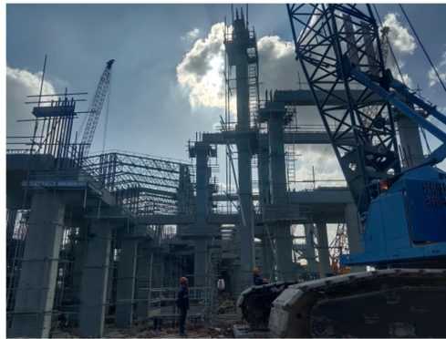
Gambar 3. 14 Erection Column Sumber : Dokumentasi lapangan, 2022
