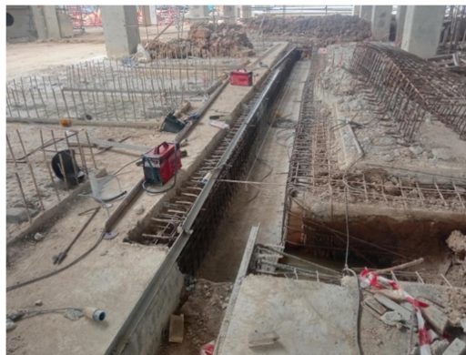
Gambar 3. 23 Pemasangan Tulangan Drainase . Sumber : Dokumentasi lapangan, 2022.
