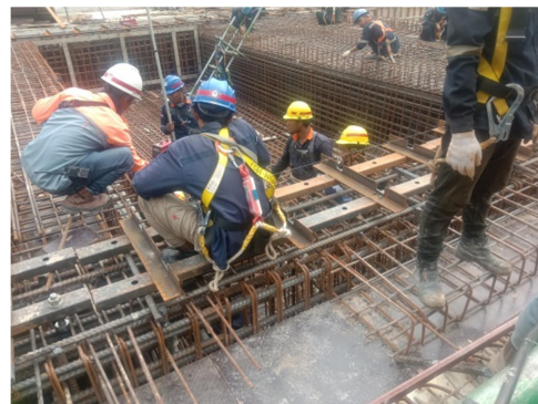
Gambar 3. 17 Pemasangan Embeded Plat Dan Anchor Sumber : Dokumentasi lapangan, 2022
