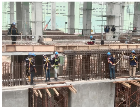
Gambar 3. 16 Pemasangan Tulangan Beams Machine Track Sumber : Dokumentasi lapangan, 2022
