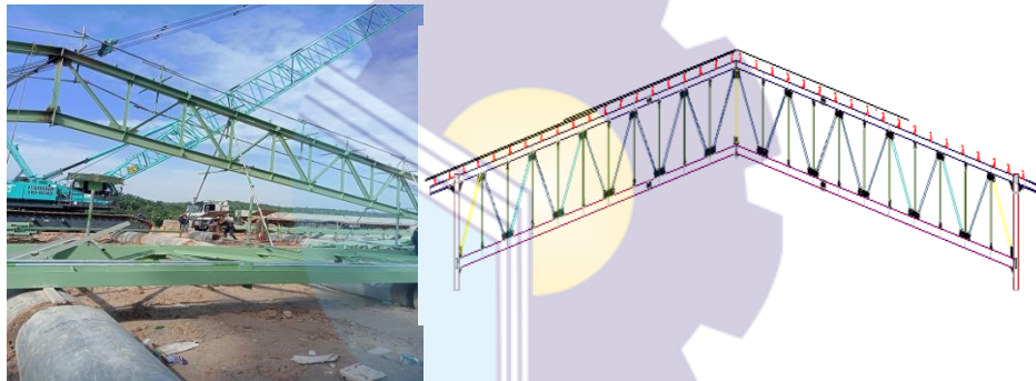
Gambar 3.44 rangka roofing truss Sumber : Dokumentasi,2022
