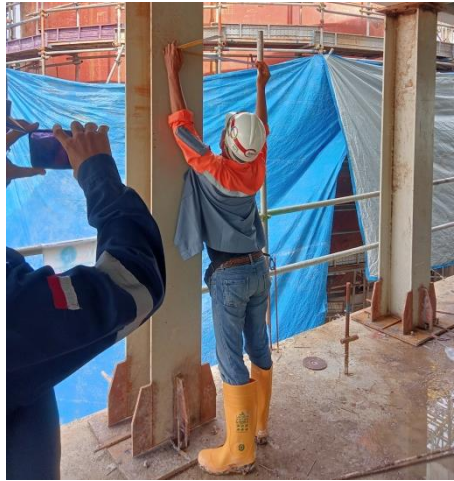
Gambar 3.23 pengecekan steel column
