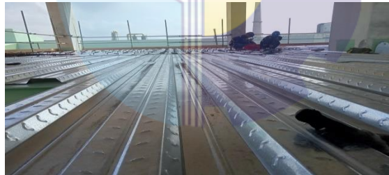
Gambar 3.28 pemasangan plat bondex
