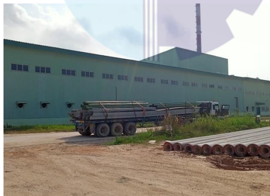
Gambar 3.22 pengangkutan steel mezzanine
