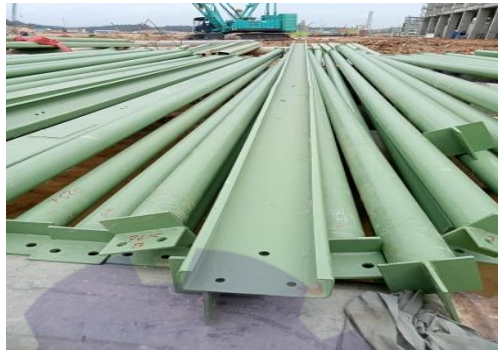
Gambar 3.42 fabrication purlin Sumber : Dokumentasi,2022
