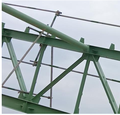
Gambar 3.47 pemasangan pipe truss
