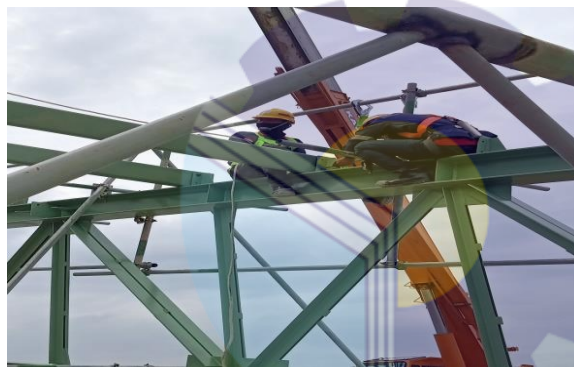
Gambar 3.48 pemasangan purlin
