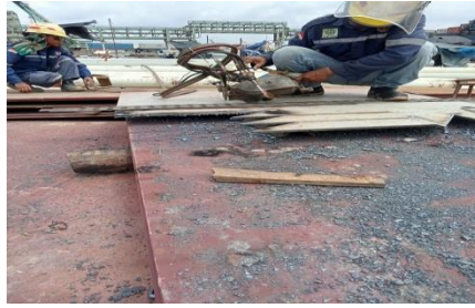
Gambar 3.13 pemotongan base plate Sumber : Dokumentas,2022
