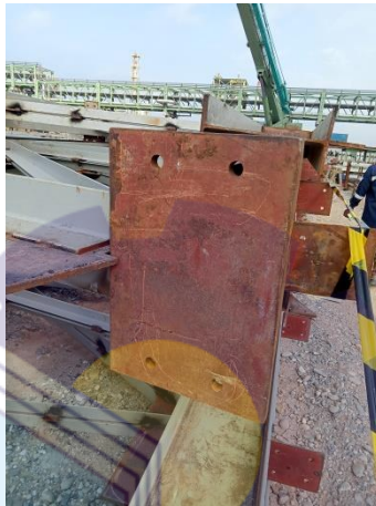
Gambar 3.33 base plate truss Sumber : Dokumentasi,2022
