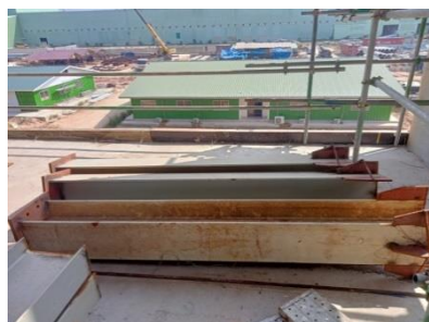
Gambar 3.15 Kolom steel mezzanine Sumber : Dokumentas,2022
