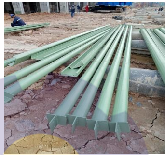
Gambar 3.41 gusset plate pipe Sumber : Dokumentasi,2022
