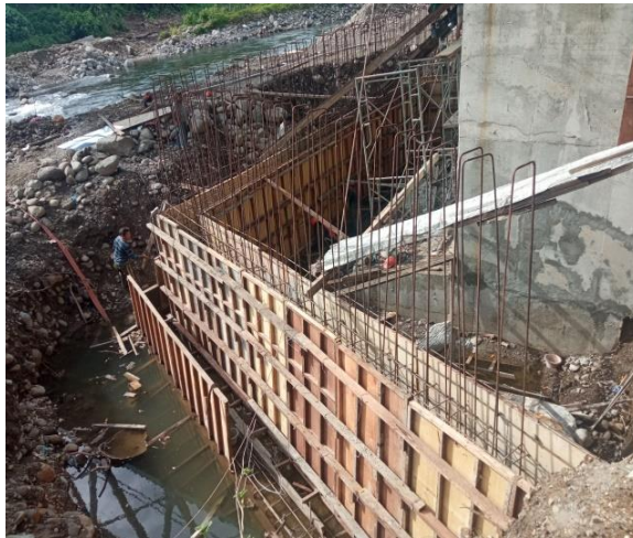
Gambar 3. 29 Pengecoran RWC
