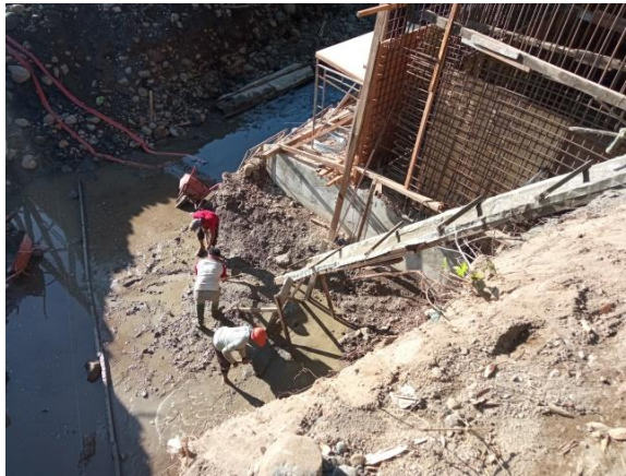
Gambar 3. 26 Pengecoran Lantai Kerja
