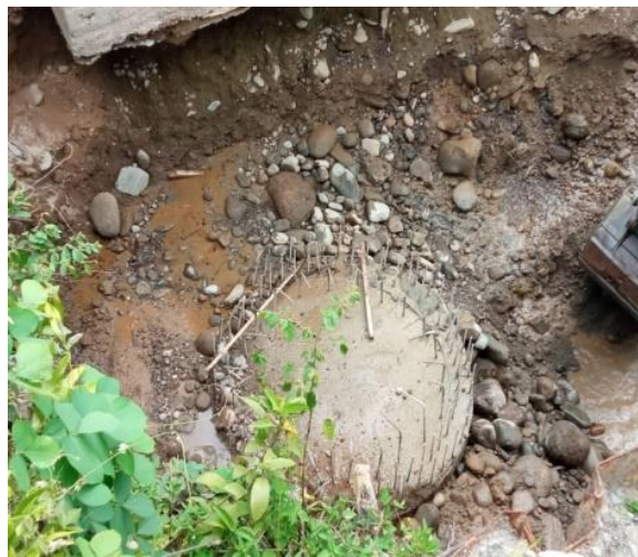
Gambar 3. 13 Kondisi Pondasi Selesai Pengecoran
