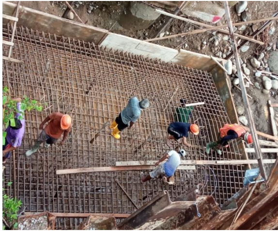
Gambar 3. 16 Pembesian Tapak Abutmen
