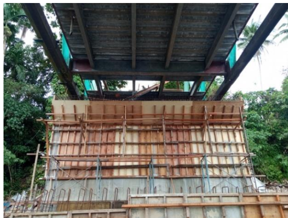
Gambar 3. 24 Pemasangan Bekisting Kepala Abutmen
