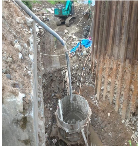
Gambar 3. 12 Proses Pengecoran Pondasi
