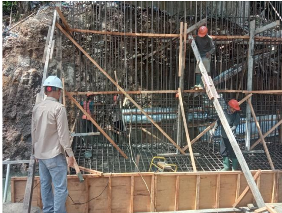
Gambar 3. 18 Pemasangan Bekisting Tapak
