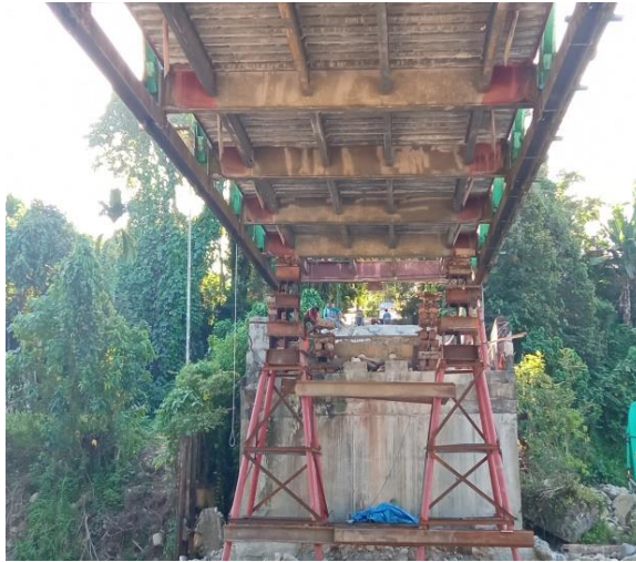
Gambar 3. 4 Kondisi Pengangkatan Setinggi 2m
