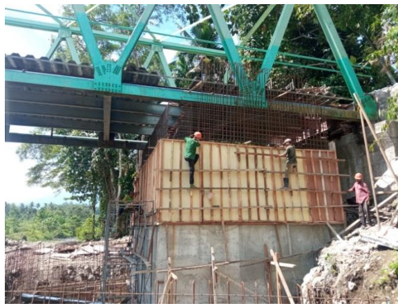
Gambar 3. 22 Pemasangan Bekisting Pada Sayap Abutment Sekaligus Proses Pengecoran
