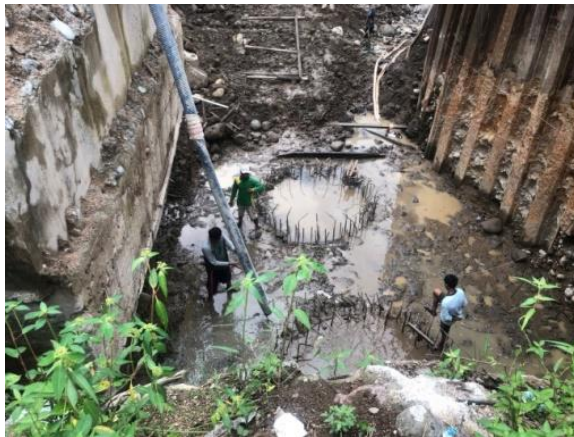
Gambar 3. 14 Pengecoran Lantai Kerja
