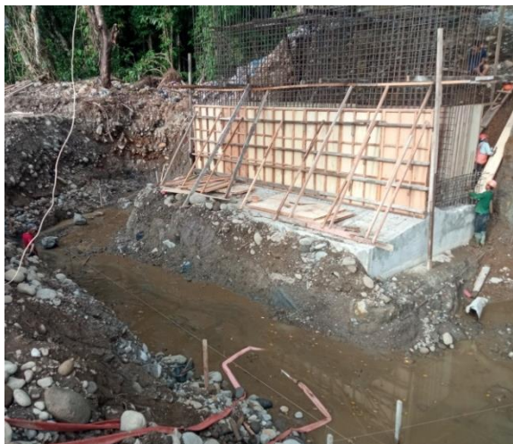
Gambar 3. 21 Pemasangan Bekisting pada Badan Abutment
