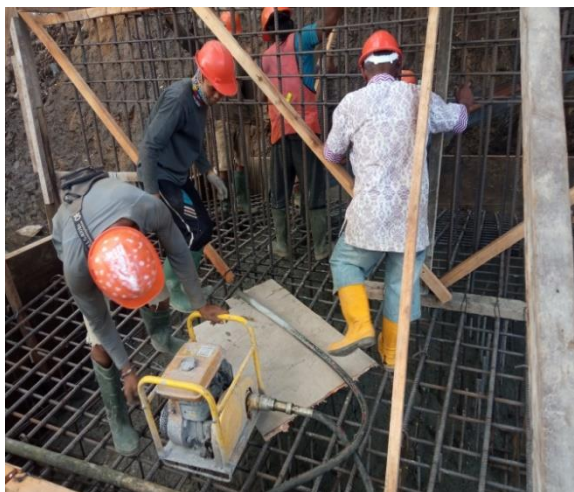
Gambar 3. 19 Pengecoran Tapak
