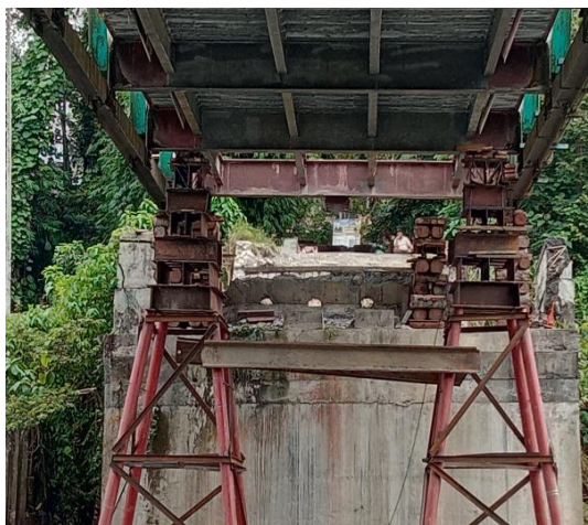
Gambar 3. 3 Kondisi Pengangkatan Setinggi 1,75m
