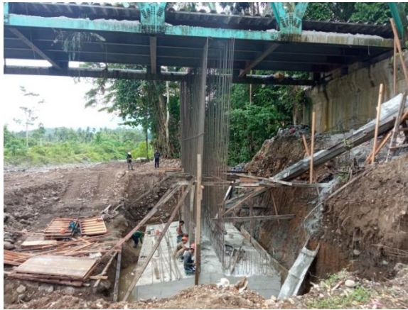
Gambar 3. 20 Pembongkaran Bekisting
