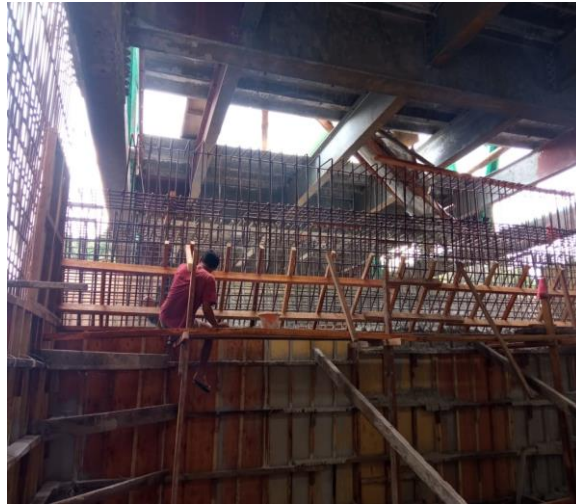
Gambar 3. 23 Pemasangan Kepala Abutmen
