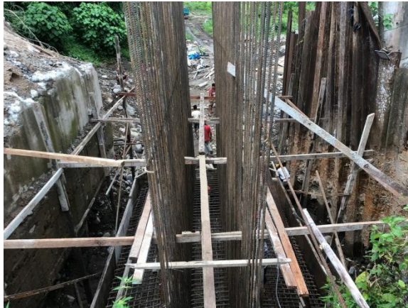
Gambar 3. 17 Pembesian Tapak Abutmen
