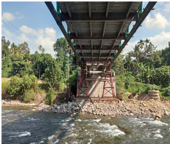
Gambar 3. 7 Kondisi Jembatan Mencapai Elevasi Awal 2,75m
