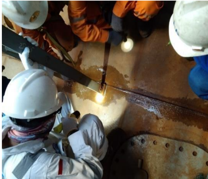
Gambar 2.30 Uji Test Kebocoran
