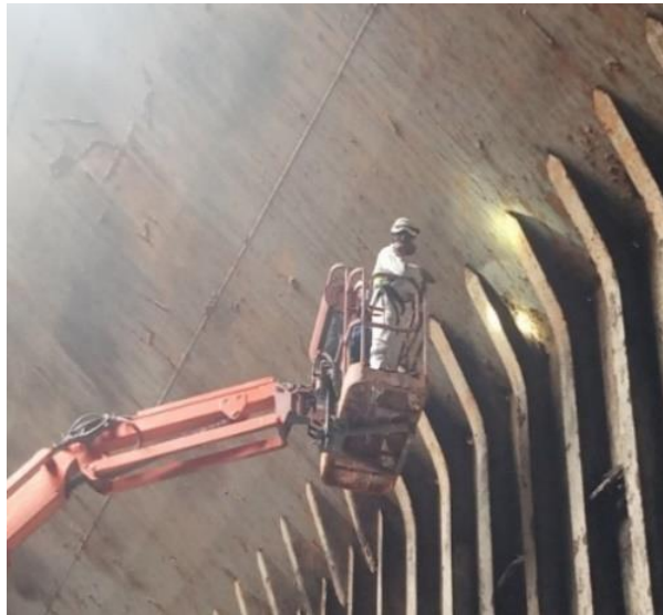
Gambar 2.41 Pengecekan Kontruksi Cargo
