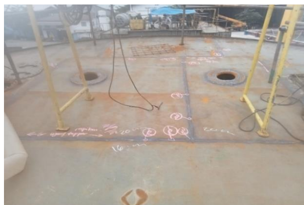
Gambar 2.11 Cacat Pada Lasan
