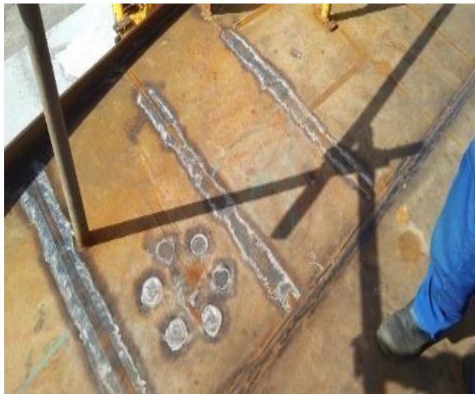
Gambar 2.31 Hasil Perbaikan Plat
