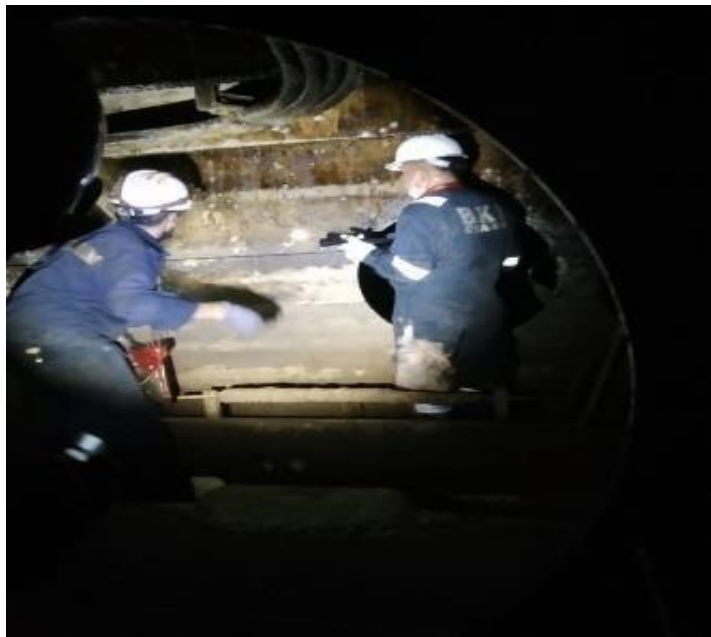
Gambar 2.35 Pengecekan Ketebalan Plat
