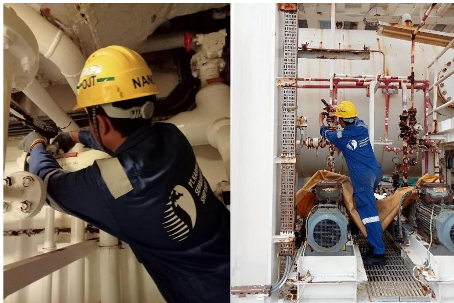
Gambar 2.42 Pemasangan tag number pada pipa di main deck dan engine room
