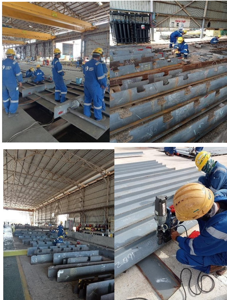
Gambar 2.44 Proses fabrikasi di area kerja yang telah ditentukan
