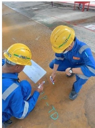
Gambar 2.33 Proses marking pada area north PT.KSS
