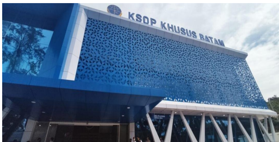
Gambar : 3.2.1 Kantor KSOP Khusus Batam Sumber : PT. Pelayaran Nan Jaya
