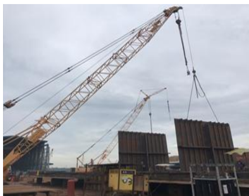
Gambar 2. 9 pemasangan Trans Bulkhead
