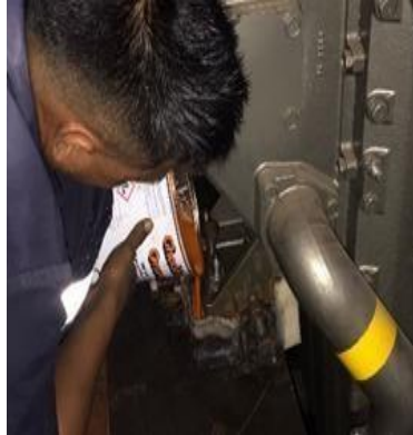
Gambar 3. 10 Proses Penuangan Chockfast pada Dudukan Mesin
