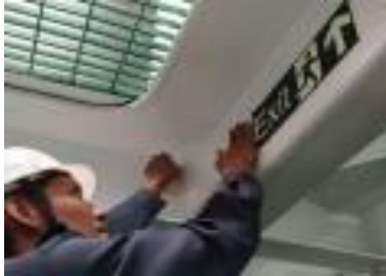
Gambar 2. 39 Pemasangan stiker safety plan
