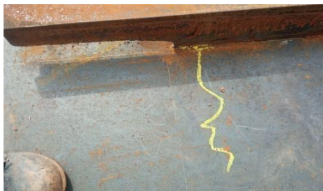
Gambar 2. 121 Visual Welding pada plat bottom
