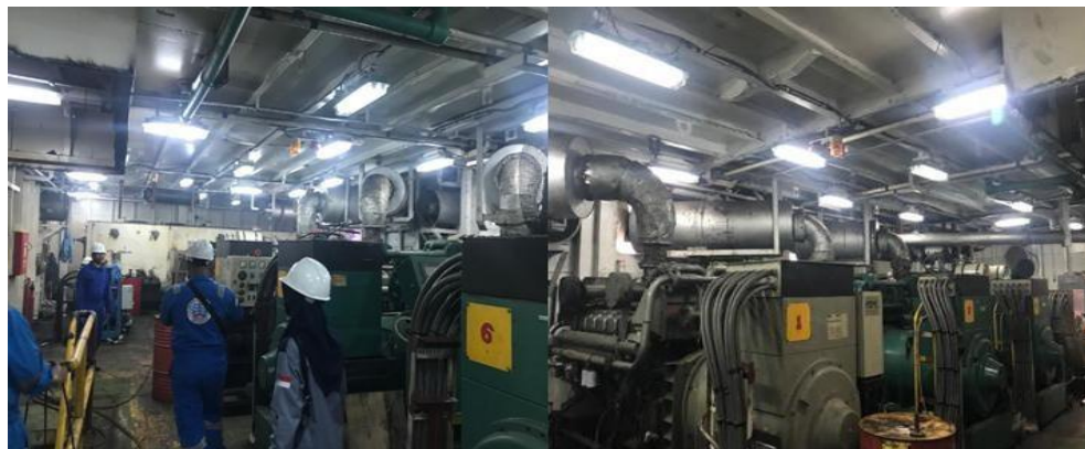
Gambar 2. 5 pengecekan instalasi listrik kapal SPCB CALINE
