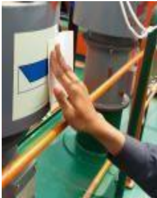
Gambar 2. 68 pemasangan stiker safety plan
