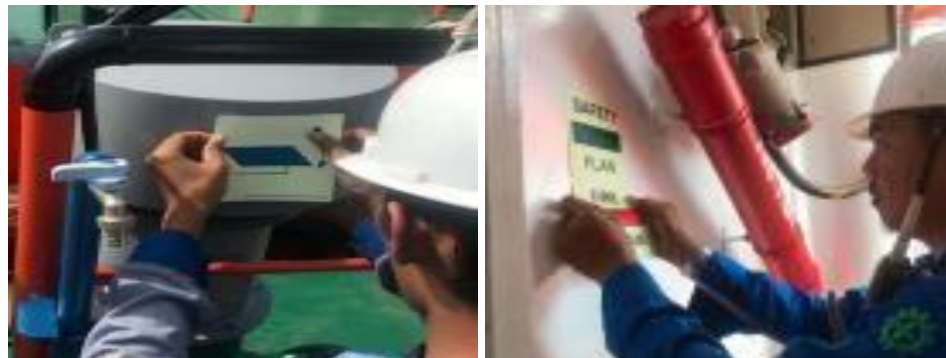
Gambar 2. 93 Pemasangan stiker safety plan
