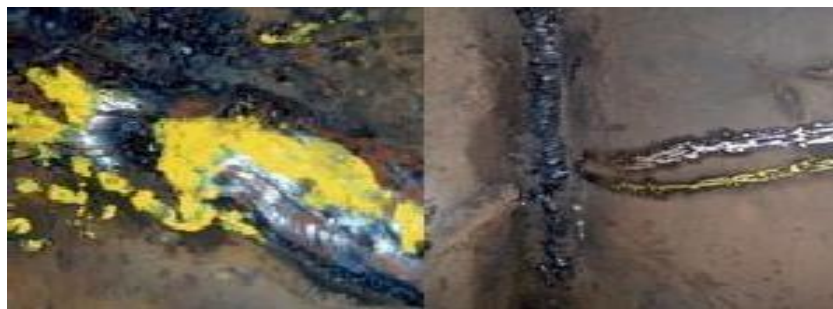
Gambar 2. 48 Proses Visual Welding pada Void tanki H-581
