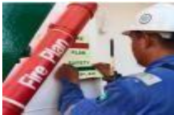
Gambar 2. 76 Pemasangan stiker Safety Plan
