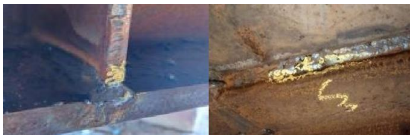
Gambar 2. 47 Visual Welding pada Ramdoor
