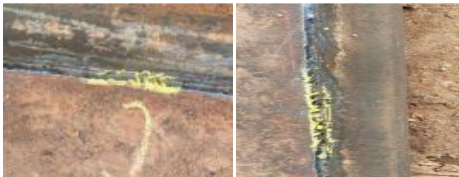
Gambar 2. 95 Visual welding inspect pada chain H-589
