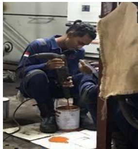
Gambar 3. 2 Proses Mixing Hardener dengan Chockfast Orange
