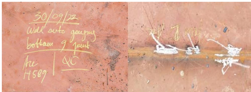
Gambar 2. 44 Proses gouging pada plate bottom
