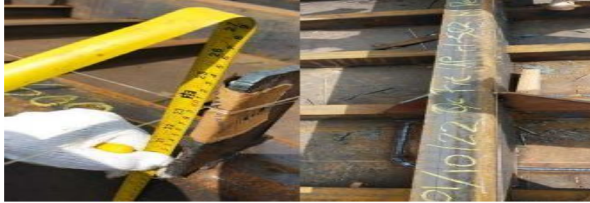
Gambar 2. 45 Proses fit up leveling welding pada deck H-582
