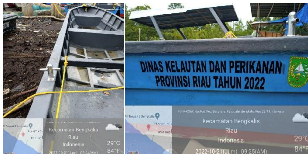
Gambar 2.11 Pemasangan tali tambat, bolard, dan nama kapal
