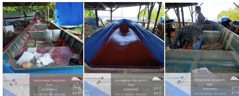
Gambar 2.3 Laminasi ke 7, pemasangan gading ke 2, dan fender
