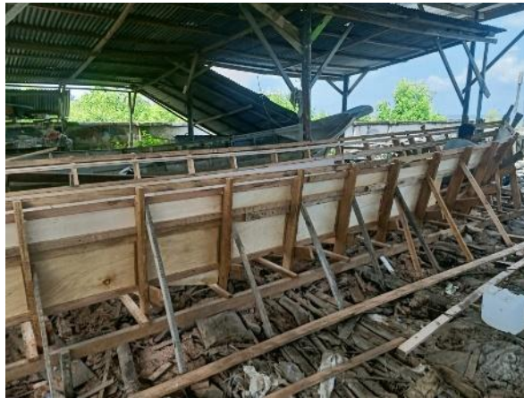
Gambar 3. 2 Proses pembuatan cetakan
