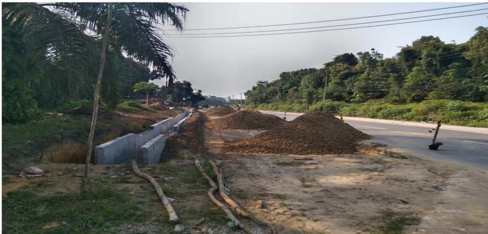
Gambar 3. 2 Survey Lapangan Sumber : dokumentasi lapangan 2022
