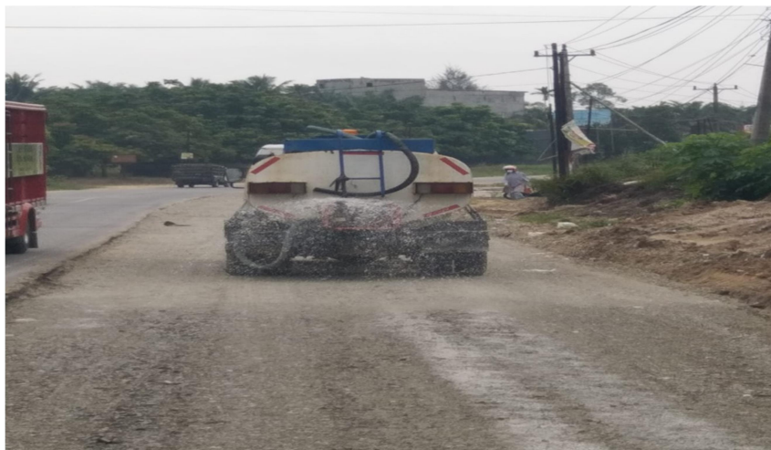
Gambar 3. 20 Penyiraman Base Menggunakan Water Tank Truck Sumber : dokumentasi lapangan 2022
