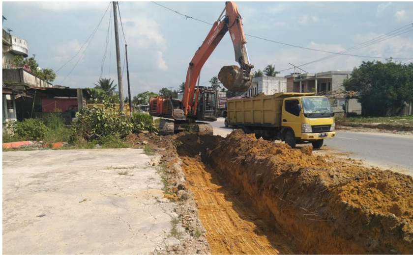
Gambar 3. 21 Perkerjaan Galian Drainase Sumber : dokumentasi lapangan 2022
