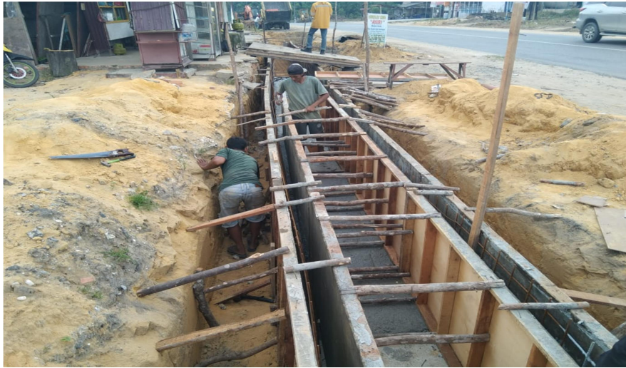
Gambar 3. 22 Perkerjaan Pemasangan Mal Dan Wiremesh 8 Sumber : dokumentasi lapangan 2022
