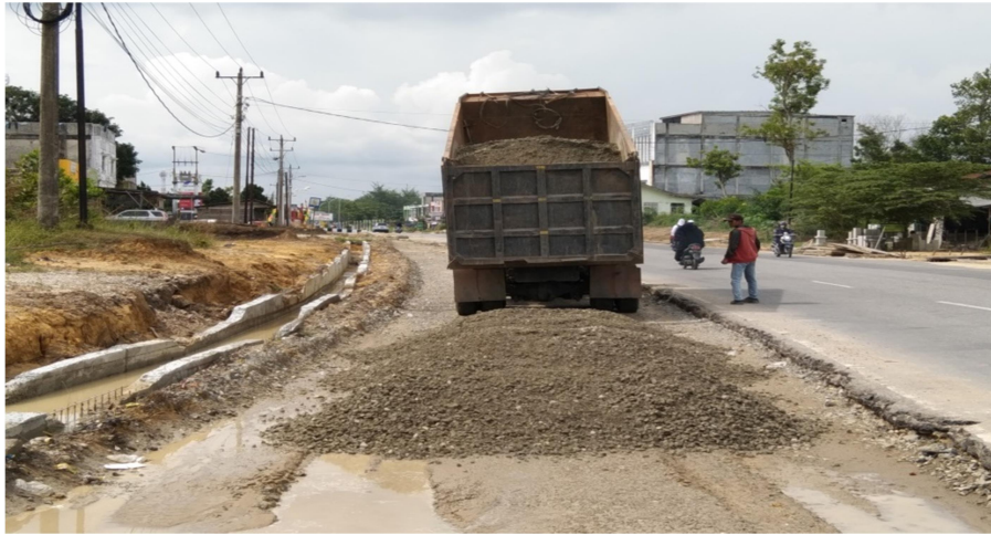
Gambar 3. 17 Penimbunan Material Base A Sumber : dokumentasi lapangan 2022
