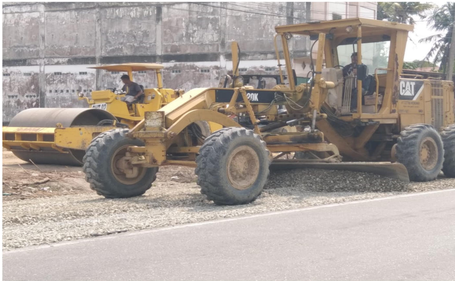
Gambar 3. 18 Penghamparan Base A Menggunakan Motor Greder Sumber : dokumentasi lapangan 2022
