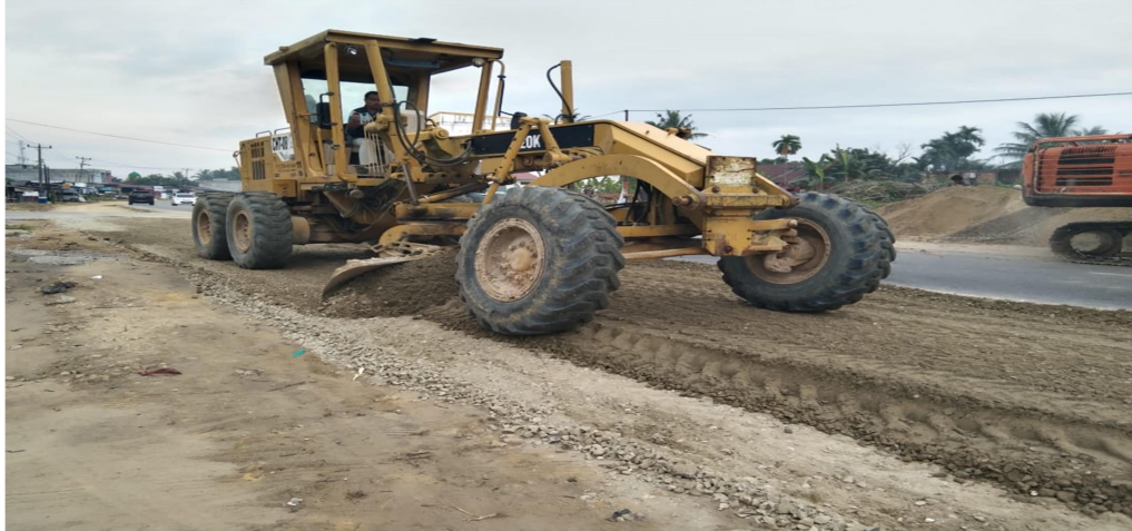
Gambar 3. 14 Penghamparan Base B Menggunakan Motor Greder Sumber : dokumentasi lapangan 2022
