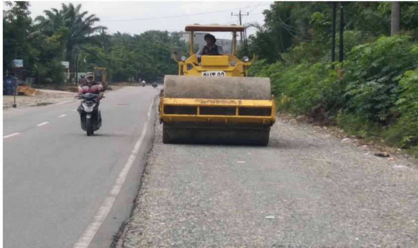
Gambar 3. 19 Pematatan Tanah Menggunakan Vibration Roller Sumber : dokumentasi lapangan 2022
