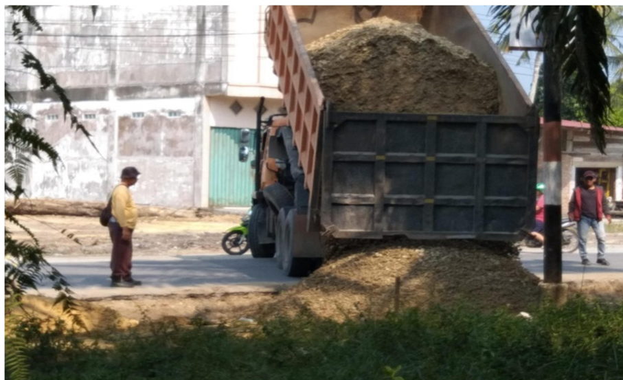
Gambar 3. 13 Penimbunan Material Lapis Pondasi Agregat B Sumber : dokumentasi lapangan 2022
