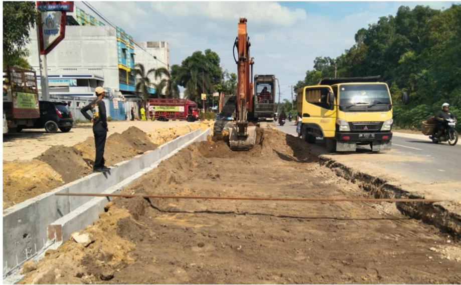
Gambar 3. 12 Perkerjaan Galian Bahu Jalan Sumber : dokumentasi lapangan 2022
