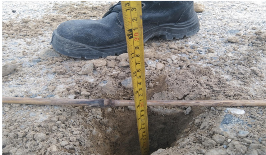
Gambar 3. 16 Test Pit Base B Sumber : dokumentasi lapangan 2022
