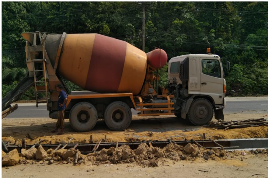
Gambar 3. 10 Concrete Mixer Truck Sumber : dokumentasi lapangan 2022
