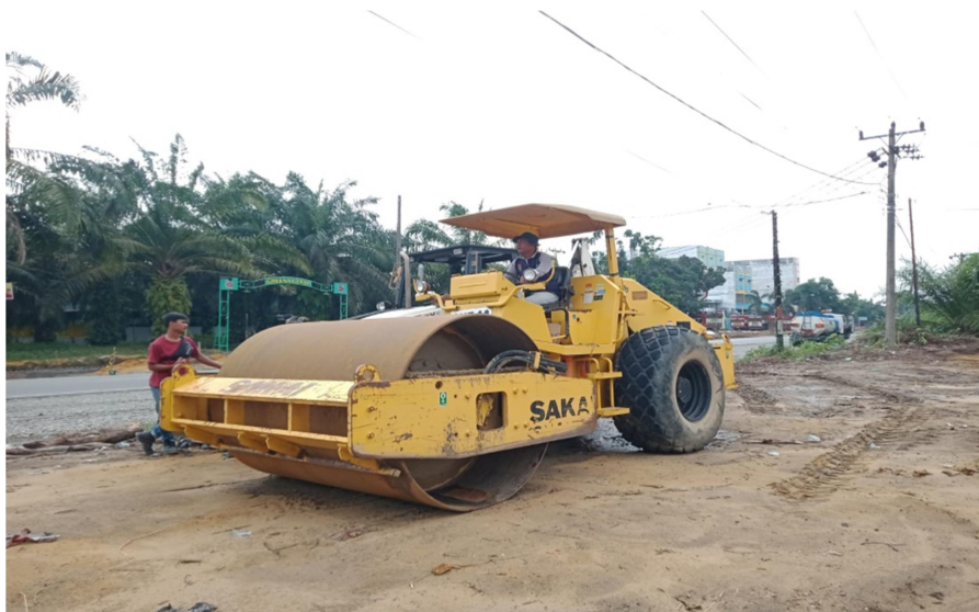
Gambar 3. 6 Vibration Roller Sumber : dokumentasi lapangan 2022
