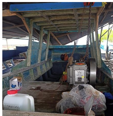
Gambar 3. 4 Pemasangan mesin 24 HP
