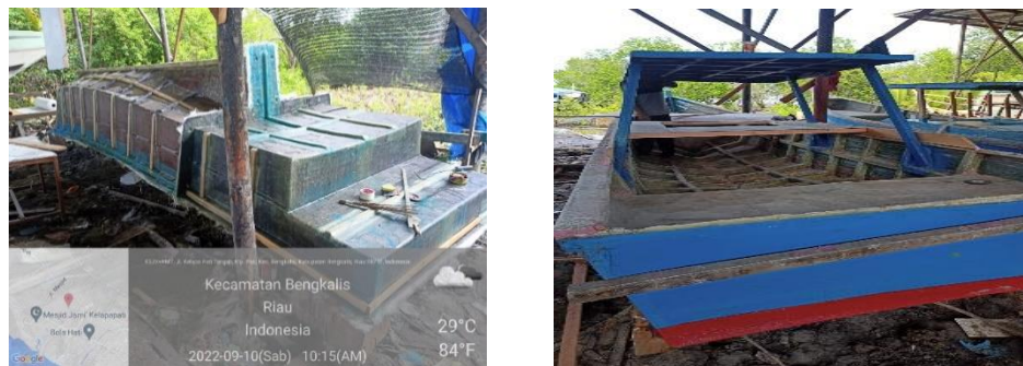
Gambar 2.6 Proses pembukaan cetakan kapal 2 GT dan finishing kapal 1 GT
