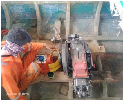
Gambar 3. 6 Pemasangan pompa siput
