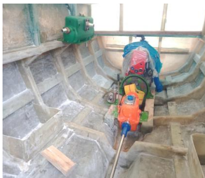
Gambar 3. 5 Pemasangan Cooler Pendingin Mesin
