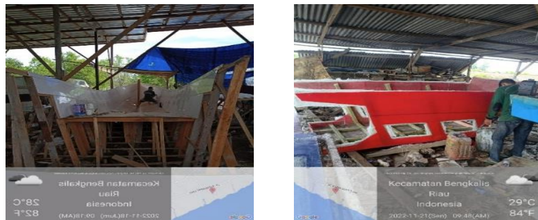
Gambar 2.16 Pembuatan bangunan atas 2 GT ke 4 dan cetakan 3 GT
