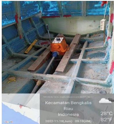
Gambar 3. 3 Pemasangan gear box
