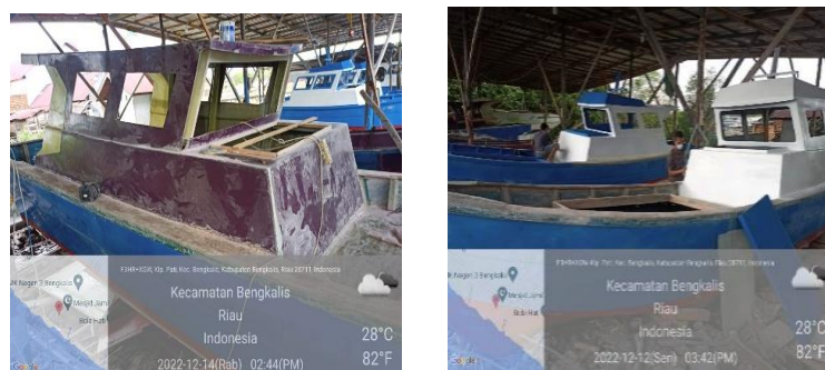
Gambar 2.19 Finishing 2 GT dan pemasangan bangunan atas 3 GT
