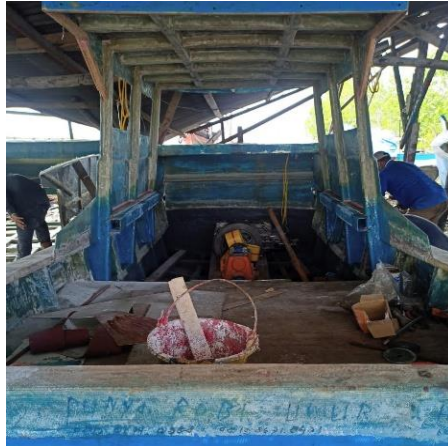
Gambar 3. 7 Pemasangan selang dan pipa pada motor penggerak diesel 24 HP
