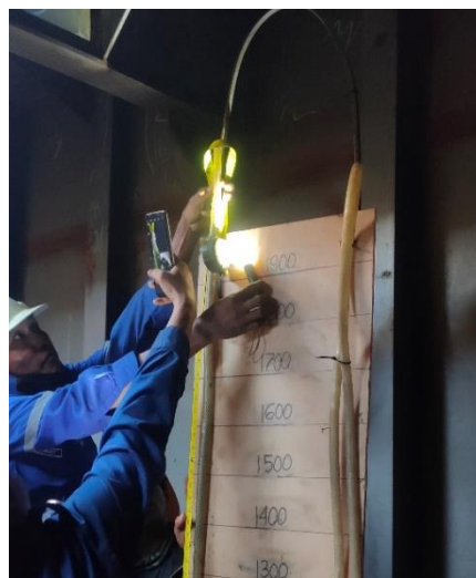
Gambar 3. 5 uji tekanan tangki
