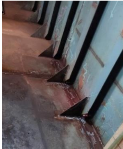
Gambar 2. 16 Pemeriksaan pada fresh water tank
