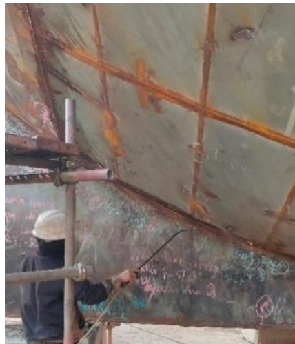
Gambar 2. 17 Pemeriksaan lasan pada fresh water tank
