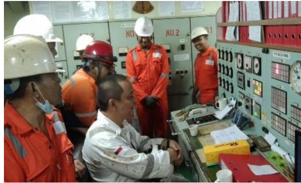
Gambar 2. 41 Pemeriksaan panel alarm
