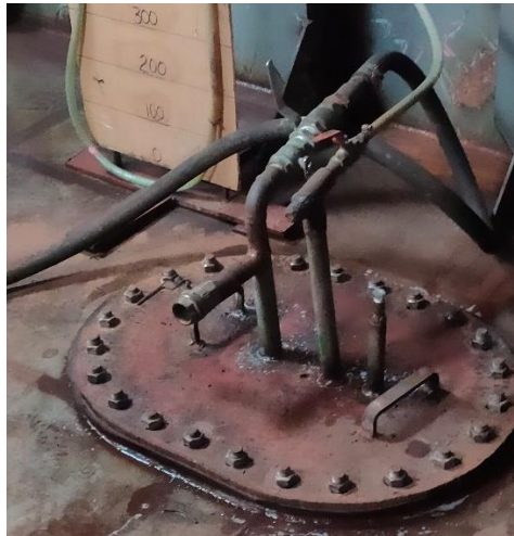
Gambar 3. 3 koneksi sambungan selang
