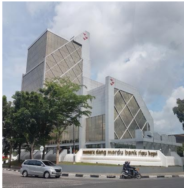
Figure 2.1 Menara Dang Merdu PT. Bank Riau Kepri Syariah
