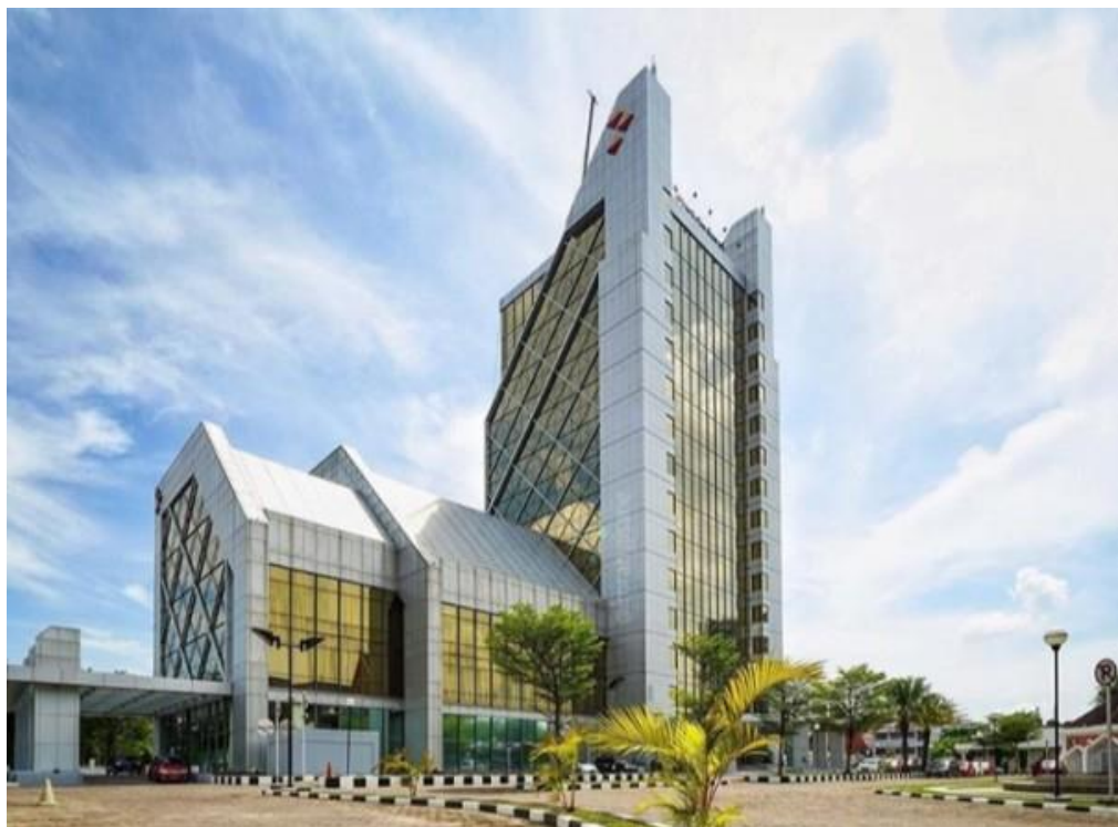
Gambar 2. 1 Menara Dang Merdu Bank Riau Kepri Sumber : Google
