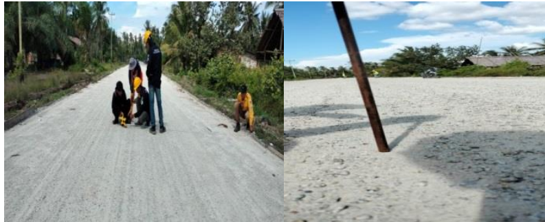
Gambar 3. 15 pemasangan patok
