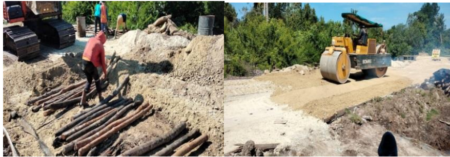
Gambar 3. 5 Pemasangan pecing
