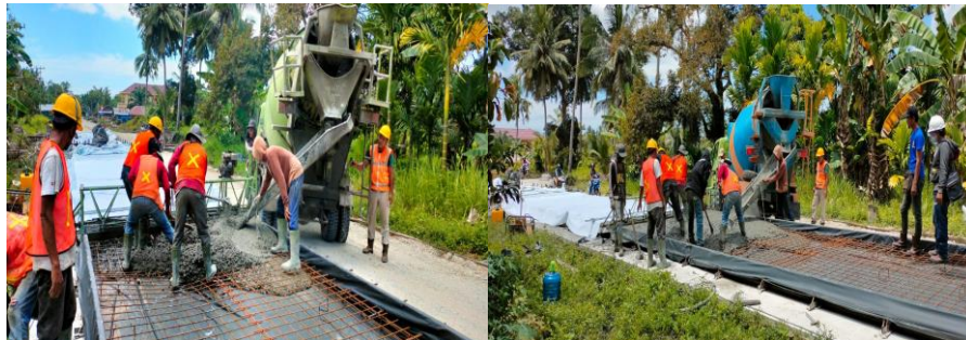
Gambar 3. 27 pengecoran rigid
