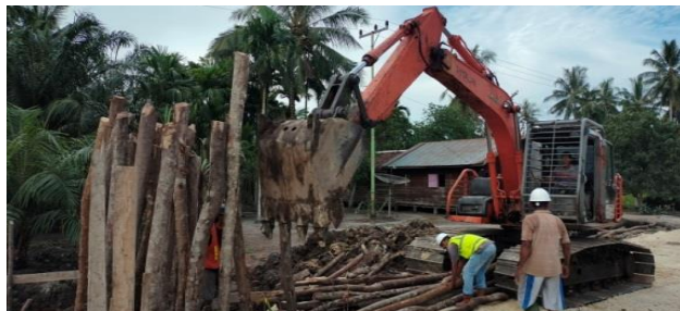
Gambar 3. 6 pemasangan kayu cerucuk
