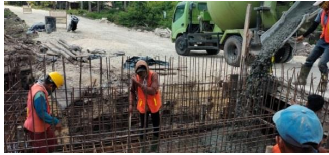
Gambar 3. 11 pengecoran lantai
