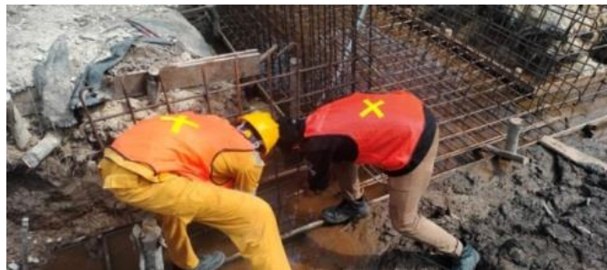
Gambar 3. 10 pemasangan tulangan box culvert
