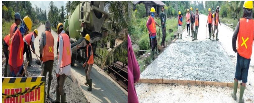
Gambar 3. 22 pengecoran Lc
