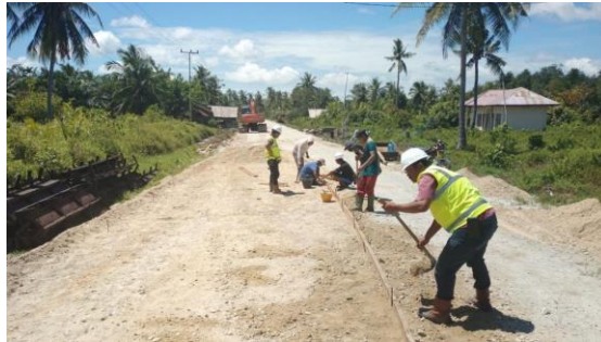
Gambar 3. 17 pemasangan mal lc
