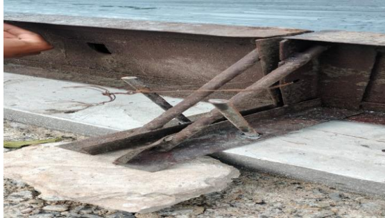
Gambar 3. 25 pemasangan bekisting
