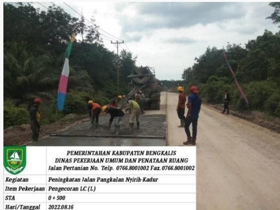
Gambar 3.10 Pekerjaan Pengecoran *Lean Concrete*
