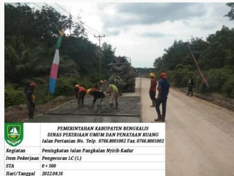
Gambar 4.9 Penuangan Beton ditempat yang akan di cor
