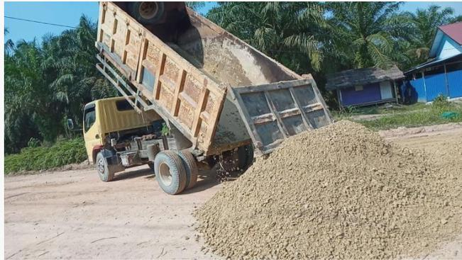
Gambar 3.2 Penuangan Base B
