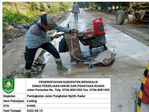
Gambar 3.26 Mesin *Cutting*
