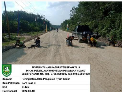
Gambar 3.5 Penge-Core-an Base B
