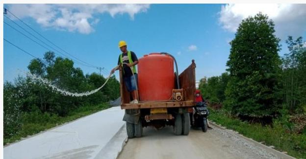
Gambar 3.18 Penyiraman Air Pada *Rigid*
