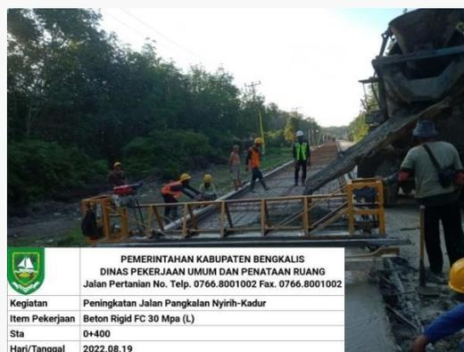
Gambar 3.13 Pengecoran *rigid*
