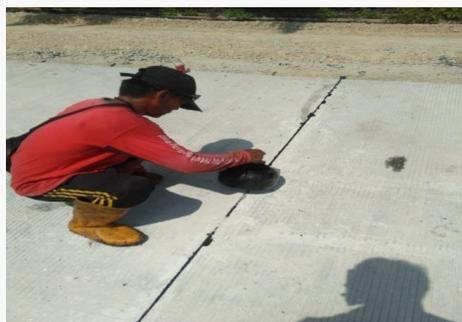
Gambar 3.20 Penuangan *Joint Sealant*
