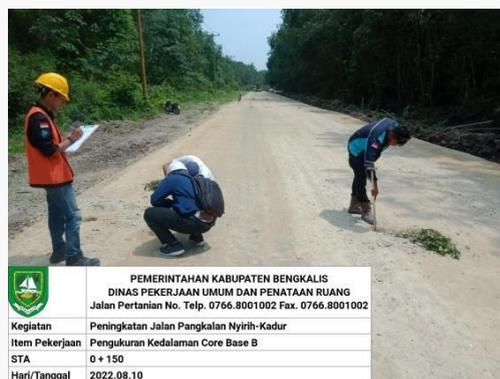
Gambar 3.6 Pengukuran Kedalaman Base B
