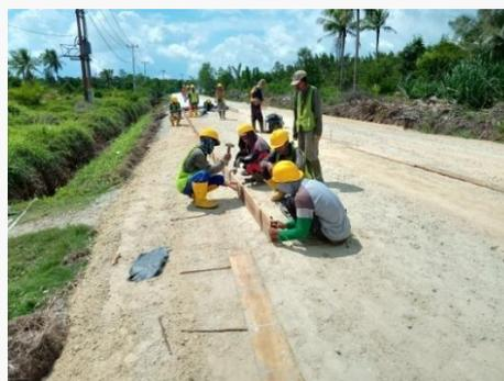
Gambar 3.8 Pemasangan Bekisting *Lean Concrete*
