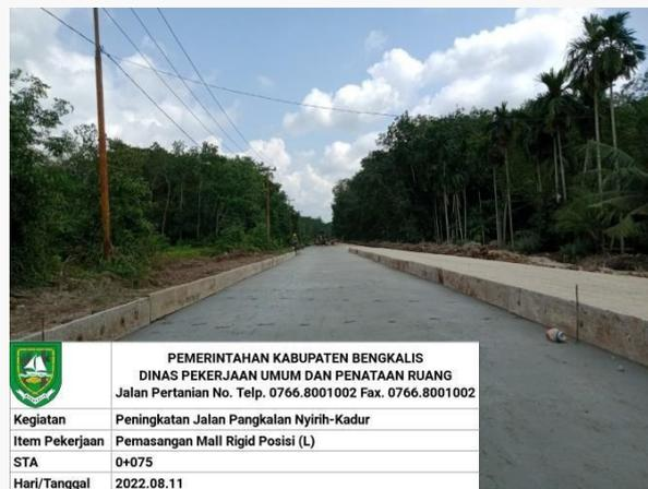
Gambar 3.9 Pemasangan Bekisting *Rigid*
