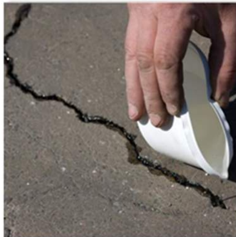
Gambar 4. 19 Perbaikan Retakan dengan Menggunakan Resin Epoxy
