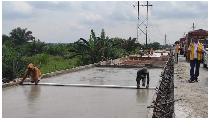
Gambar 4. 17 perataan bagian top layer menggunakan pipa
