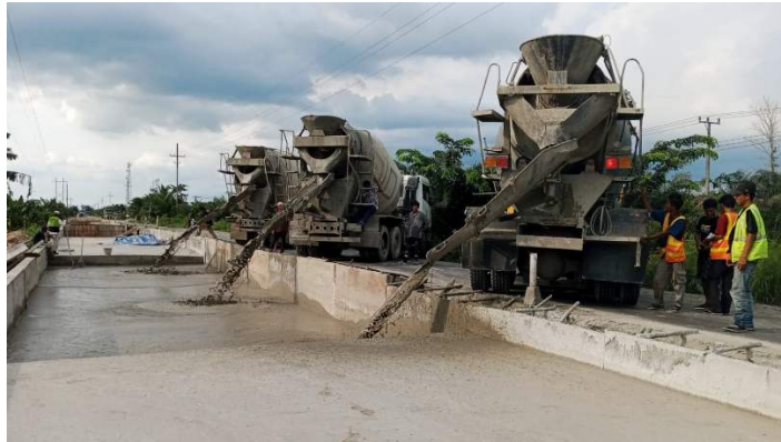
Gambar 4. 16 Penghamparan Mortar Busa UCS 2000 Kpa sebagai top layer
