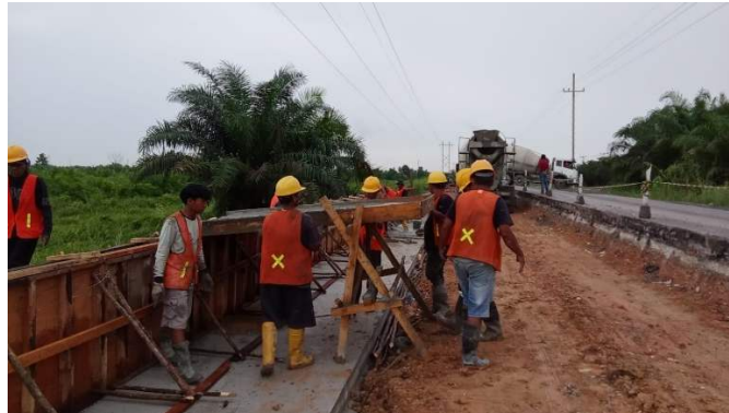
Gambar 3. 16 Pekerjaan pengecoran DPT
