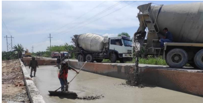
Gambar 3. 20 Pengerjaan Timbunan Ringan Mortar Busa
