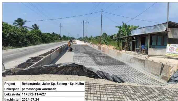
Gambar 3. 19 Pemasangan Wiremesh
