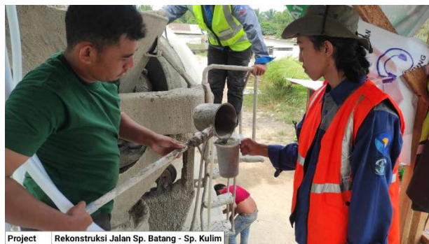
Gambar 4. 10 Pengambilan sampel uji density dan flow
