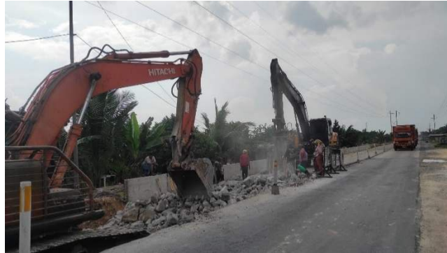
Gambar 3. 14 Proses Galian perkerasan beton dengan bracker dan excavator
