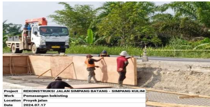
Gambar 3. 18 Pemasangan Bekisting
