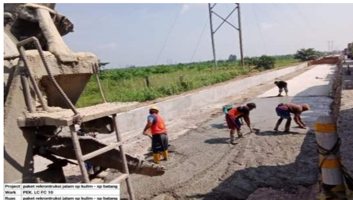
Gambar 3. 17 Pengecoran Lantai Kerja f_c' 10 Mpa
