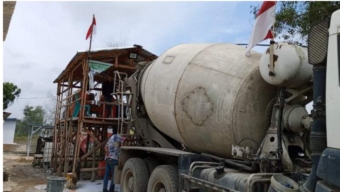
Gambar 3. 8 Truck Mixer masuk ke tempat pengisian Foam
