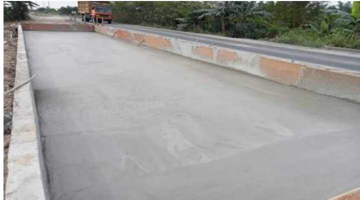
Gambar 4. 14 Mortar Busa UCS 800 Kpa yang sudah mengeras
