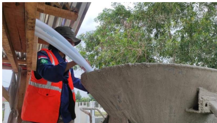
Gambar 3. 7 Memasukan selang aliran campuran foam dan air ke truck mixer
