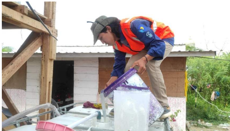
Gambar 3. 4 Pencampuran Foam dan air ke dalam tangki
