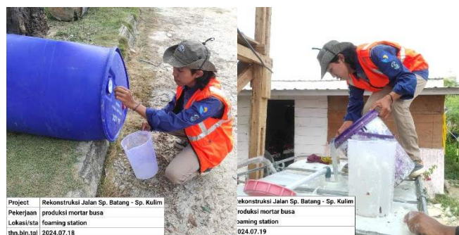
Gambar 4. 5 Penuangan foam agent ke tangki air
