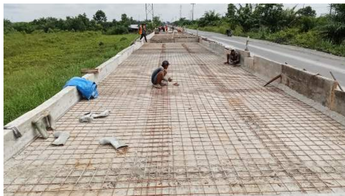
Gambar 4. 15 Pemasangan wiremesh untuk lapis top layer
