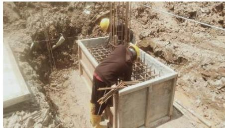
Gambar 3.12 Pemasangan Bekisting Pondasi
