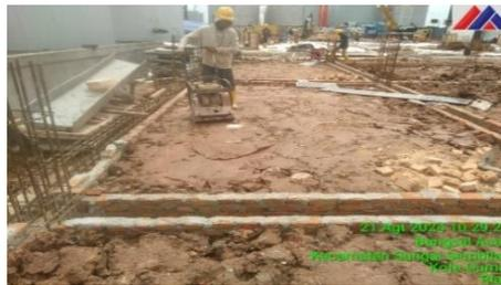
Gambar 3.23 Pemadatan Tanah *Slab* Beton
