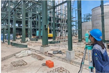
Gambar 3.6 *Vertikality*
