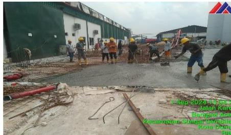
Gambar 3.21 Pengecoran *Ground Beam*
