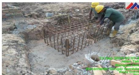
Gambar 3.39 Pemasangan Rebar Pembesian Dudukan Equipment
