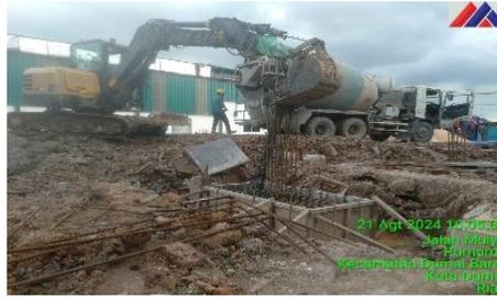
Gambar 3.13 Pengecoran Pondasi
