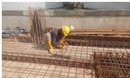
Gambar 3.28 Pemasangan Besi Suport Bar Lantai
