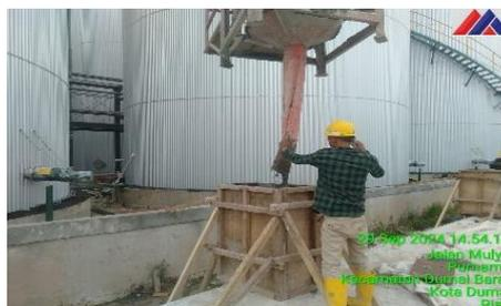
Gambar 3.44 Pengecoran Pedestal
