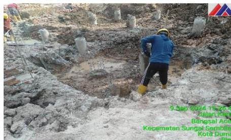
Gambar 3.8 Pemotongan Tiang Pancang Pondasi
