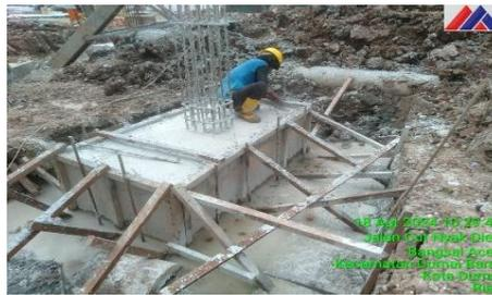
Gambar 3.14 Pembongkaran Bekisting Pondasi
