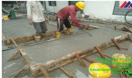
Gambar 3.40 Pengecoran Dudukan *Equipment*
