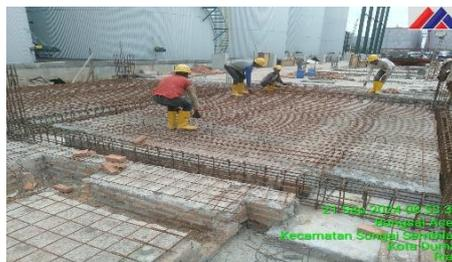
Gambar 3.26 Pemasangan *Ware Mesh* 2 Layer Lantai
