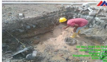
Gambar 3.9 Pemasangan Urugan Pasir Pondasi
