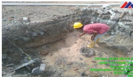
Gambar 3.36 Pemasangan Urugan Pasir untuk Dudukan Equipment
