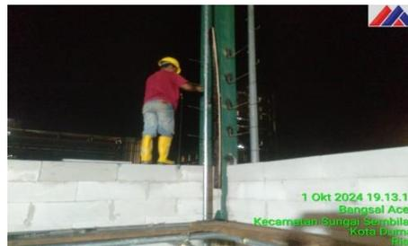
Gambar 3.49 Instal Stick Bar untuk Pasangan Bata Ringan
