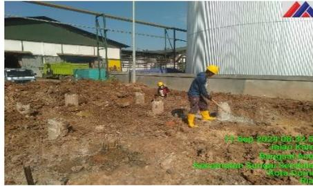
Gambar 3.35 Pemotongan Tiang Pancang untuk Dudukan Equipment
