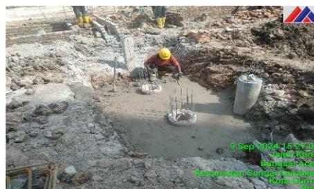
Gambar 3.10 Pemasangan *Lean Concrete* Pondasi
