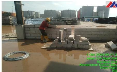
Gambar 3.47 Pemasangan Bata Ringan ( Hebel )
