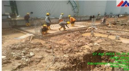
Gambar 3.20 Pemasangan Rebar *Ground Beam*
