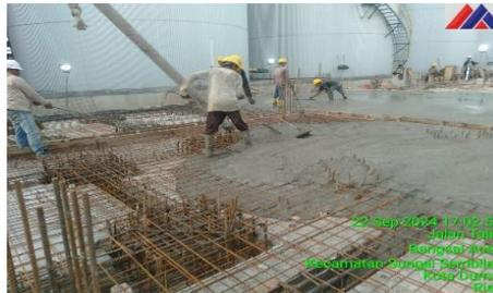
Gambar 3.30 Pengecoran Lantai K300
