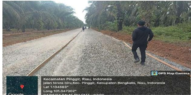
Gambar 3 12. Pemasangan Bekisting lantai kerja
