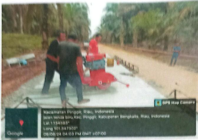
Pekerjaan cutting per segmen oleh mesin cutting dengan bantuan air.
