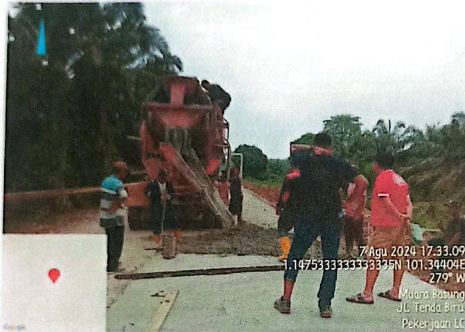
Pengocoran LC, sebagai lantai kerja untuk pekerjaan Rigid pavement. Menggunakan alat truck mixer dan peralatan pengecoran lc, pada sisi kanan jalan dengan tebal 10 cm
