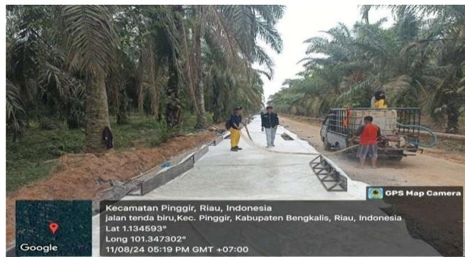
Gambar 3 30. Pekerjaan Penyiraman Rigid
