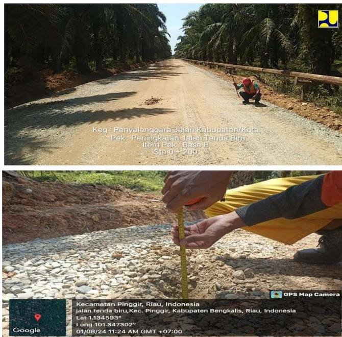
Gambar 4 5. Pengujian Test Pit dan Hasil nya
