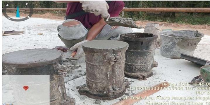
Gambar 3 25. Pengambilan sampel silinder
