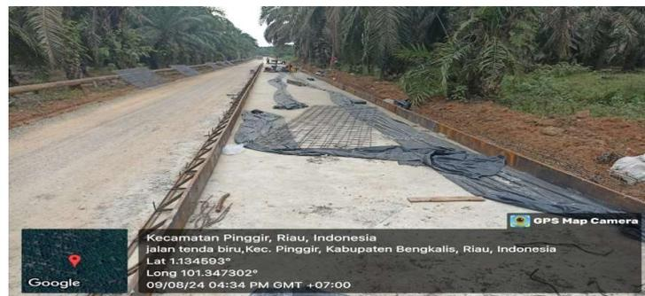
Gambar 3 16. Pengukuran dan pemasangan bekisting
