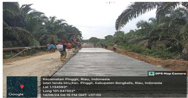
Gambar 3 28.penyemprotan Curing Compound
