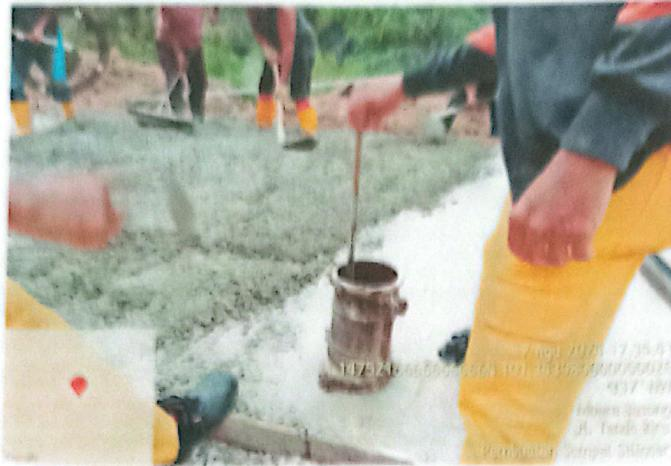
Pembuatan sampel beton untuk lc, sampel yang digunakan yaitu silinder
