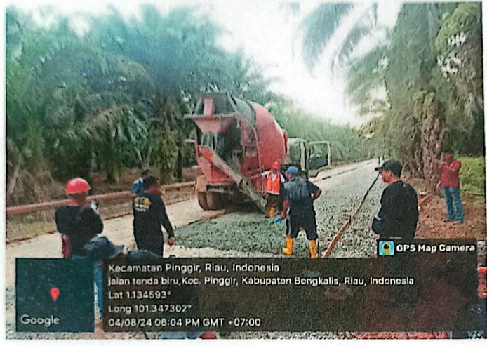
Pengocoran LC, sebagai lantai kerja untuk perkerjaan Rigid pavement. Menggunakan alat truck mixer dan peralatan pengecoran lc ini dari mulai STA 0 +338 - STA 0+291 pada sisi kanan jalan dengan tebal 10 cm
