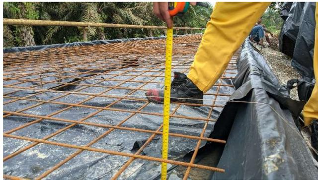
Gambar 3 23. opname Mal/Bekisting Rigid
