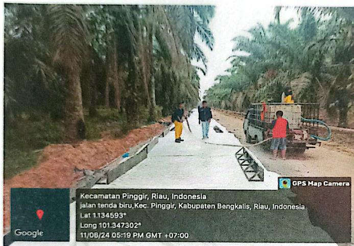
Penyiraman rigid dilakukan untuk mencegah keretakan beton dan juga merawat mutu beton
