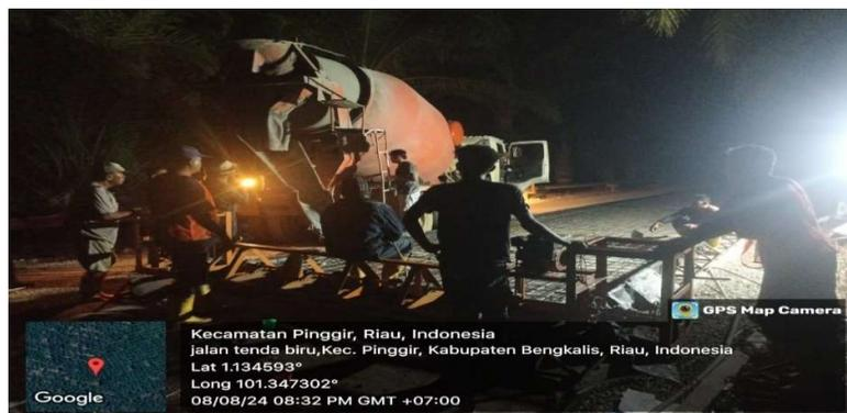
Gambar 3 26. pekerjaan Penghamparan dan Perataan Beton Rigid
