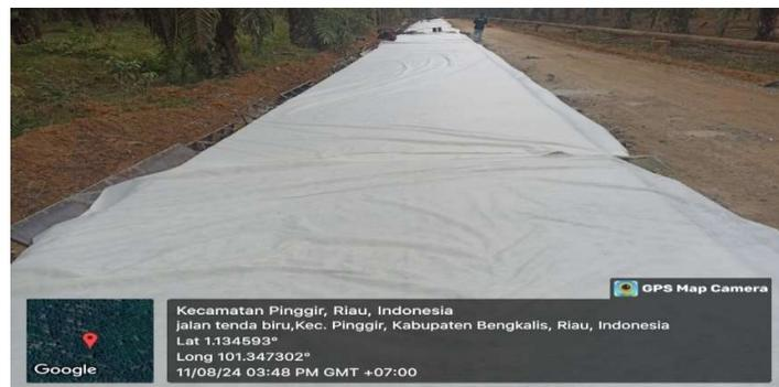
Gambar 3 29. Pekerjaan Pemasangan Geotextile
