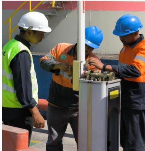
Gambar 3. 3 Pemasangan dan perbaikan Portal (barrier gate)
