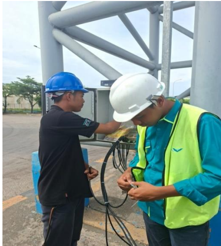
Gambar 3. 6 Perbaikan kabel jaringan
