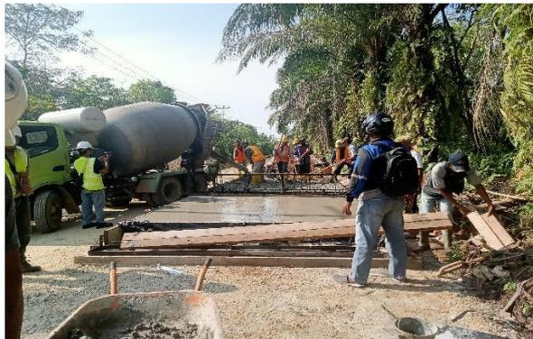
Gambar 3. 18 pengecoran Rigid
