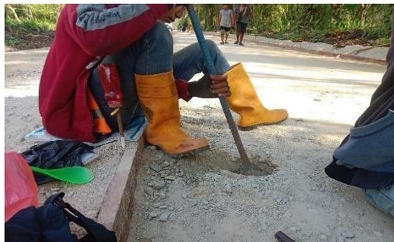
Gambar 3. 6 Penge-core-an Base B
