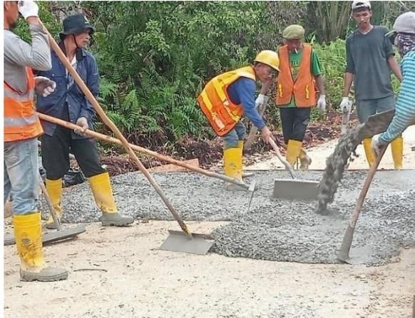
Gambar 3. 10 Pengecoran LC
