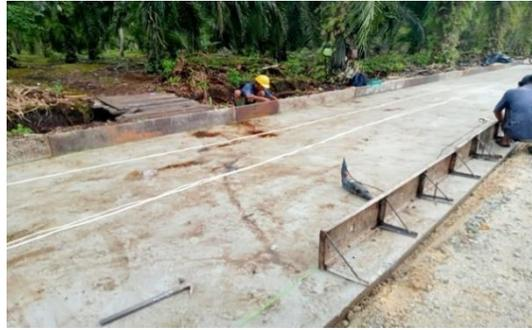
Gambar 3. 11 Pengeboran lc Untuk Pemasangan Besi Penahan Bekisting Rigid
