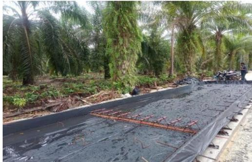
Gambar 3. 14 Pemasangan Tulangan Dowel & Dudukan Wiremesh
