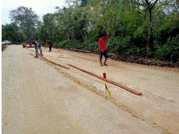
Gambar 3. 9 Pemasangan Bekisting LC
