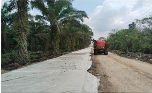
Gambar 3. 23 Pekerjaan Perawatan Beton Curring
