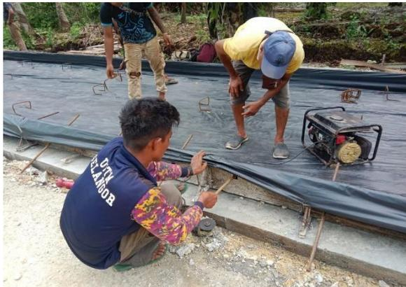
Gambar 3. 16 Pemasangan Tie Bar
