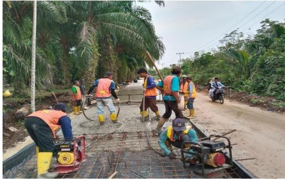
Gambar 3. 19 Pemadatan Beton Menggunakan vibrator
