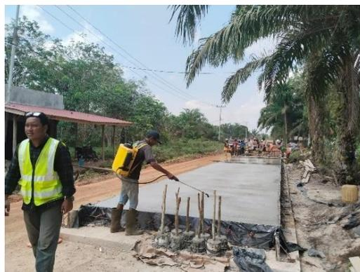
Gambar 3. 22 Pekerjaan Curing Compound
