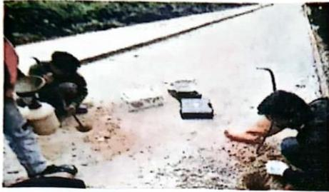
Selanjutnya kami mengikuti pekerjaan core base b dilapangan. Core ini bertujuan untuk mengetahui ketebalan base B yang telah dipadatkan.
