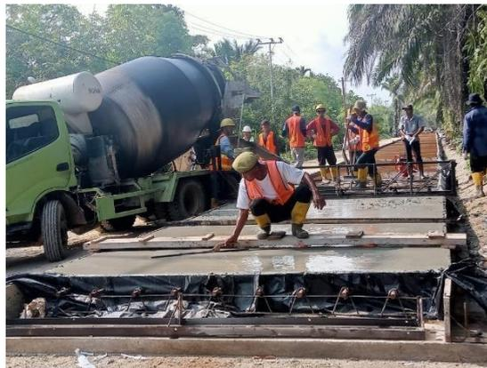
Gambar 3. 20 Meratakan Permukaan Beton
