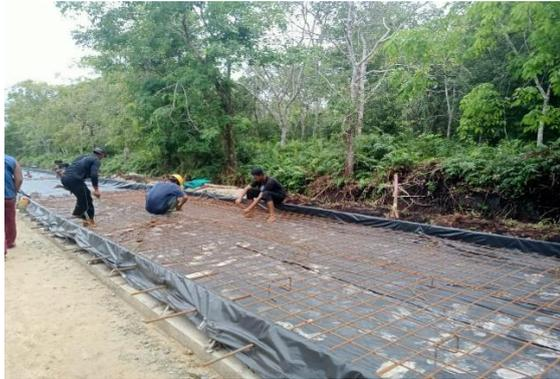
Gambar 3. 15 Pekerjaan Pembesian Bekisting Rigid
