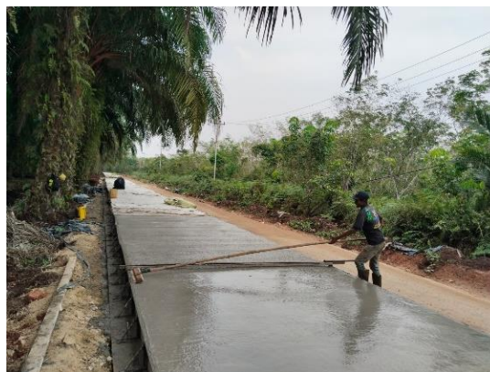
Gambar 3. 21 Pekerjaan Grooving
