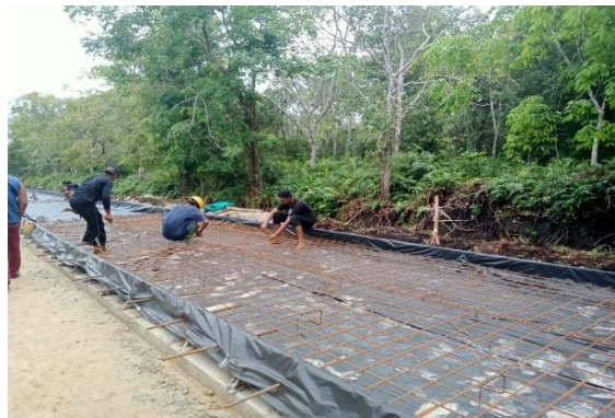
Gambar 3. 15 Pekerjaan Pembesian Bekisting Rigid
