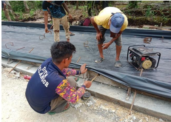
Gambar 3. 16 Pemasangan Tie Bar
