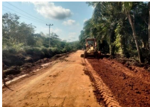
Gambar 3. 1 Perataan Tanah Urugan Sumber : Dokumentasi Lapangan, Kerja Praktek 2024
