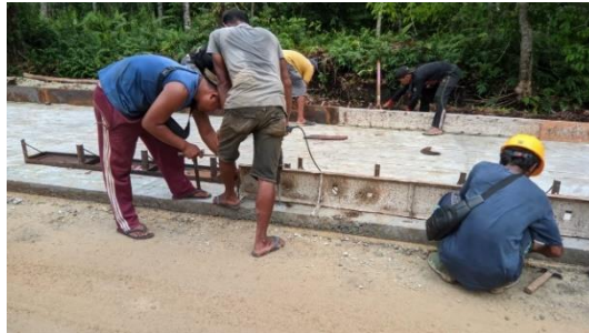
Gambar 3. 12 Pemasangan besi penahan mal rigid
