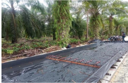
Gambar 3. 14 Pemasangan Tulangan Dowel & Dudukan Wiremesh
