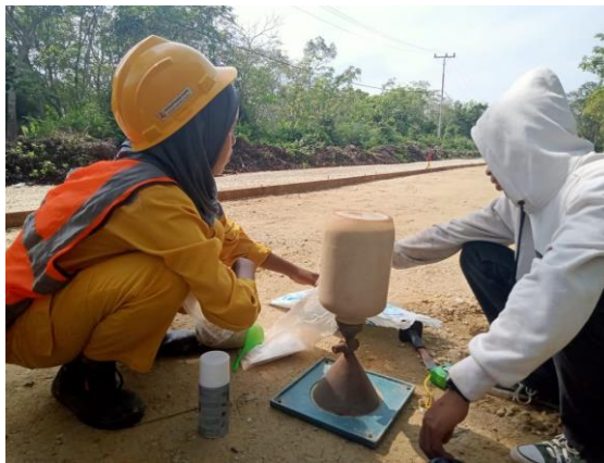
Gambar 3. 8 Pengujian Sand Cone Sumber : Dokumentasi Lapangan, Kerja Praktek 2024
