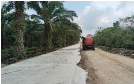
Gambar 3. 23 Pekerjaan Perawatan Beton Curing
