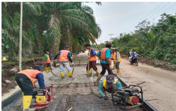
Gambar 3. 19 Pemadatan Beton Menggunakan vibrator
