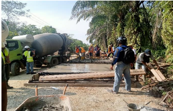
Gambar 3. 18 pengecoran Rigid
