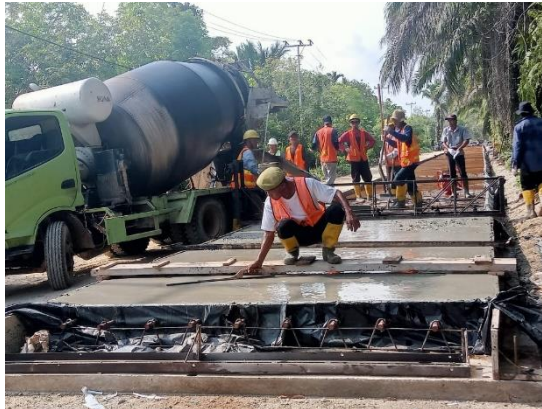
Gambar 3. 20 Meratakan Permukaan Beton
