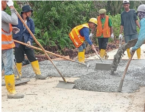
Gambar 3. 10 Pengecoran LC
