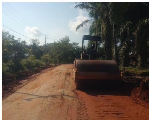
Gambar 3. 2 Pemadatan Tanah Urugan Sumber : Dokumentasi Lapangan, Kerja Praktek 2024
