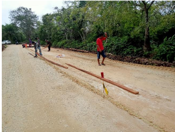
Gambar 3. 9 Pemasangan Bekisting LC
