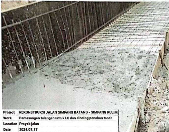
Project REKONSTRUKSI JALAN SEMPANG BATANG - SEMPANG KULIM Work Pemasangan tulangan untuk LC dan dinding penahan tanah Location Proyek jalan Date 2024.07.17
