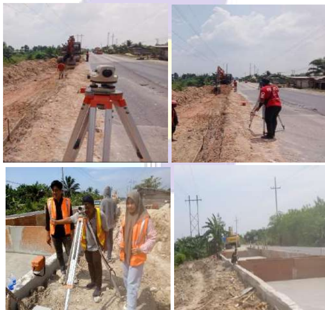
Gambar 3. 5 Pengukuran waterpass
