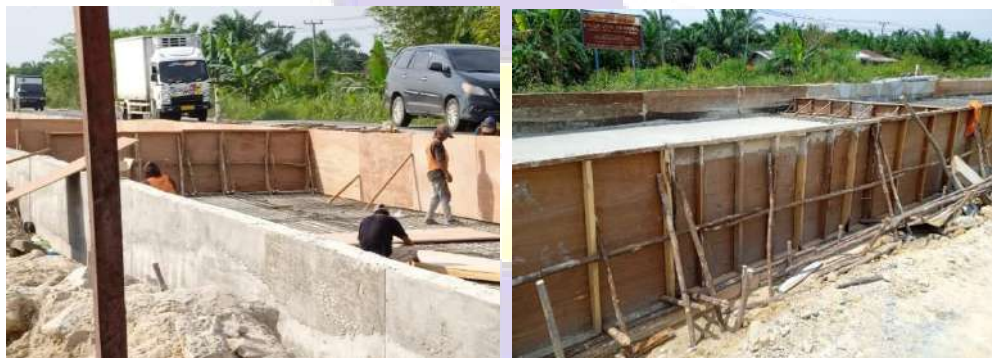
Gambar 4.2 Pemasangan Bekisting
