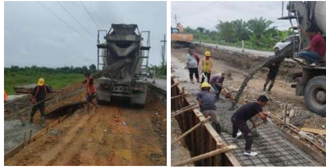
Gambar 3. 8 Pekerjaan LC
