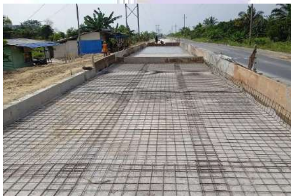
Gambar 4.3 Pemasangan Wiremash
