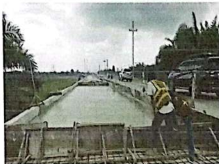
Project : Palat - Rekonstruksi Jalan Simp Kulin - Simp Batang Work : Pe Mortar Busa 2000 Location : STA 11+975 - 12+000
