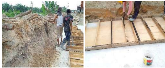
Gambar 3. 6 Pekerjaan bekisting DPT
