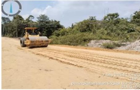
**Gambar 3. 15** Pekerjaan Pemasatan Tanah Timbunan
