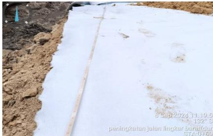
**Gambar 4. 10** Pengukuran Geotextile
