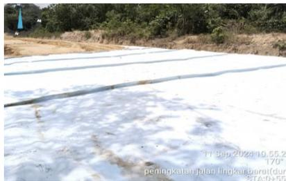
**Gambar 3. 9** Pemasangn Geotextile
