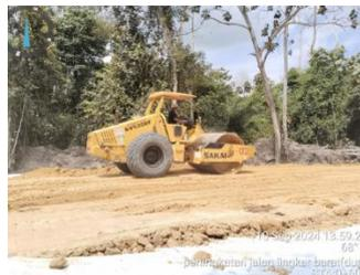
**Gambar 4. 14** Pemasatan Tanah
