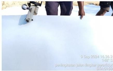
**Gambar 3. 8** Menjahit Geotextile
