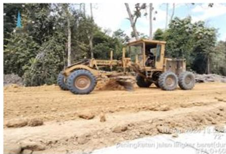
**Gambar 3. 14** Tanah Timbunan Disebar dan Diratakan
