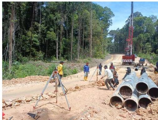
**Gambar 3.14** Pekerjaan Surveying Untuk Penentuan Titik Pancang
