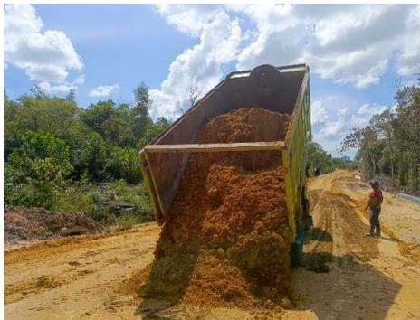
**Gambar 3.10** Pekerjaan Penghamparan Tanah Timbunan
