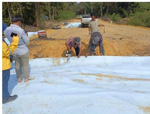
**Gambar 3.8** Penyambungan Geotextile dengan teknik menjahit
