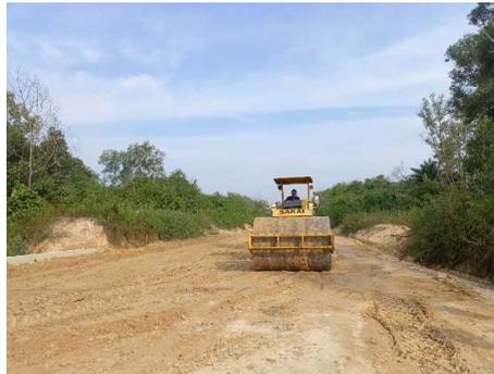
**Gambar 3.12** Pekerjaan Pemadatan Tanah Timbunan
