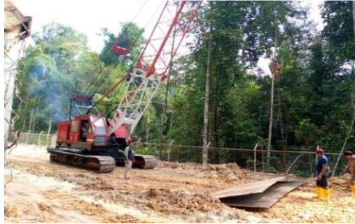
**Gambar 3.13** Pekerjaan Persiapan Alat Pancang
