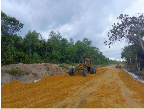
**Gambar 3.11** Tanah Timbunan Disebar dan Diratakan
