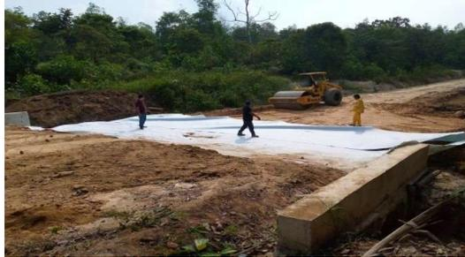
**Gambar 3.7** Pekerjaan Pemasangan Geotextile
