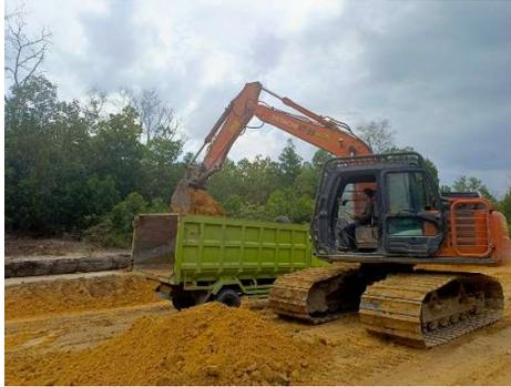
**Gambar 4.4** Proses Loading Dump Truck Menggunakan Excavator
