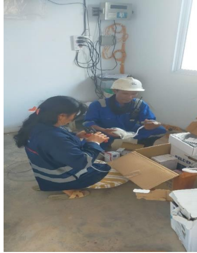
Gambar 3. 2 Mengerjakan membuat kabel Lan
