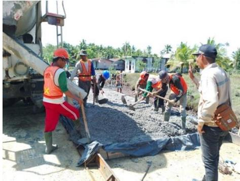
**Gambar 3. 8** Pekerjaan Pengecoran
