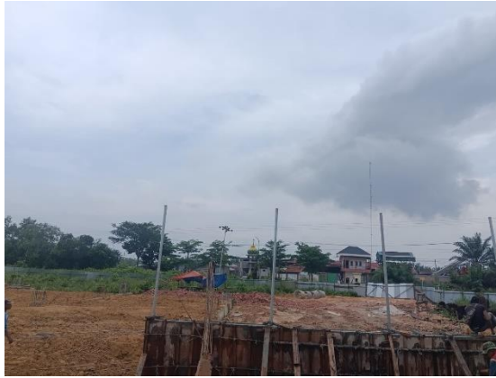
Gambar 3.39 Pekerjaan Pemasangan Pipa Galvanis (Sumber: Dokumentasi Lapangan, 2024)
