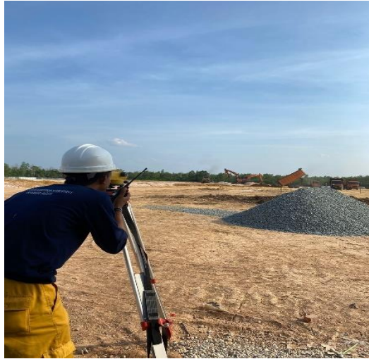
Gambar 3.26 Pengukuran Elevasi Tapak Pondasi (Sumber: Dokumentasi Lapangan, 2024)
