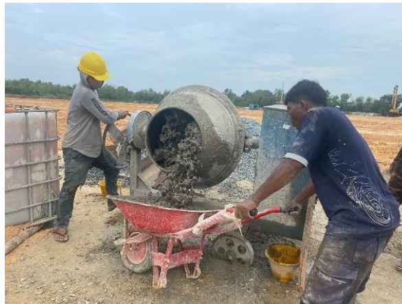
Gambar 3.22 Pengadukan Beton Site Mix (Sumber: Dokumentasi Lapangan, 2024)
