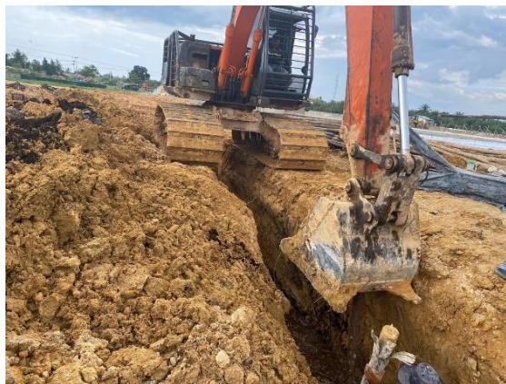
Gambar 3.75 Pekerjaan Pemancangan Cerucuk (Sumber: Dokumentasi Lapangan, 2024)
