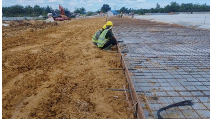
Gambar 3.91 Pembesian wiremesh M8 (Sumber: Dokumentasi Lapangan, 2024)
