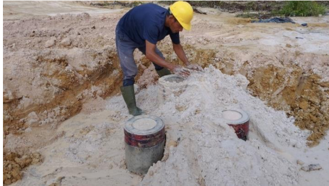
Gambar 3.51 Pengisian Tiang Pancang (Sumber: Dokumentasi Lapangan, 2024 )
