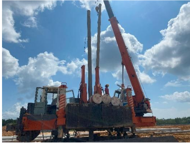
Gambar 3.46 Pemancangan Spun Pile (Sumber: Dokumentasi Lapangan, 2024 )
