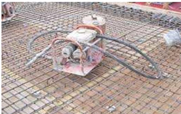
Gambar 2.20 Concrete Vibrator (Sumber :Dokumentasi Lapangan,2024)
