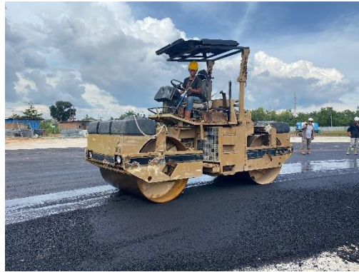
Gambar 3.96 Pemadatan aspal AC-WC (Sumber: Dokumentasi Lapangan, 2024)
