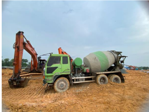
Gambar 2.6 Beton Ready Mix (Sumber :Dokumentasi Lapangan,2024)
