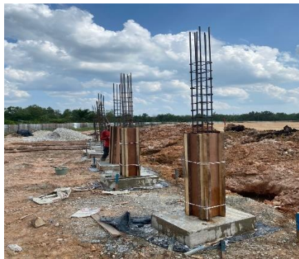
Gambar 3.21 Bekisting Terpasang (Sumber: Dokumentasi Lapangan, 2024)
