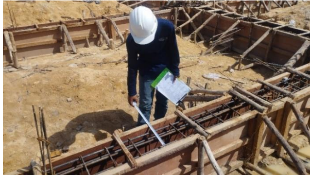
Gambar 3.67 Pengecekan Tulangan Sloof ( Sumber: Dokumentasi Lapangan, 2024)
