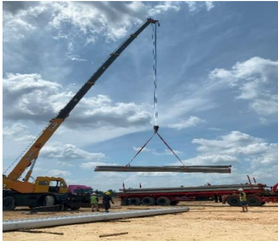
Gambar 2.15 Truck Crane (Sumber :Dokumentasi Lapangan,2024)
