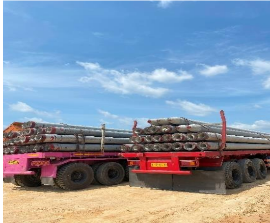
Gambar 3.44 Pengadaan Spun Pile (Sumber: Dokumentasi Lapangan, 2024)
