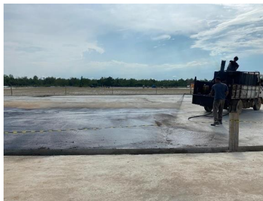
Gambar 3.93 Penyemprotan Prime Coat (Sumber: Dokumentasi Lapangan, 2024)
