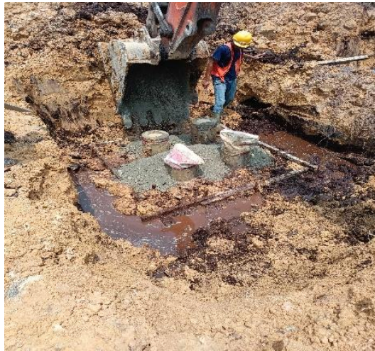
Gambar 3.53 Pengecoran Lantai Kerja (Sumber: Dokumentasi Lapangan, 2024)
