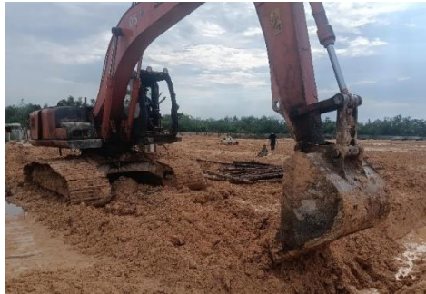
Gambar 3.8 Pekerjaan Galian (Sumber: Dokumentasi Lapangan, 2024)
