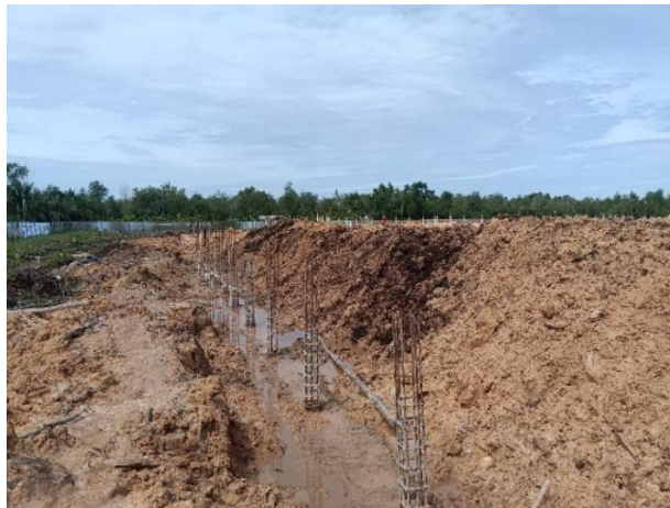
Gambar 3.29 Lantai Kerja Sloof (Sumber: Dokumentasi Lapangan, 2024)
