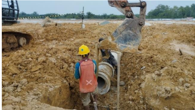
Gambar 3.85 Pemasangan Pipa RCP Dia.40 cm (Sumber: Dokumentasi Lapangan, 2024)
