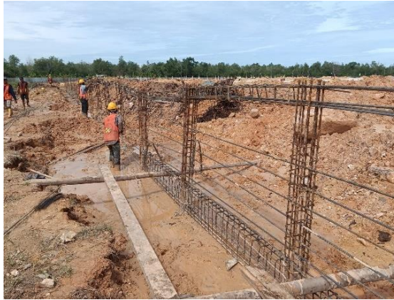
Gambar 3.30 Pembesian Sloof (Sumber: Dokumentasi Lapangan, 2024)
