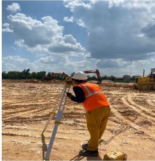
Gambar 3 47 Pengukuran Elevasi Tiang Pancang (Sumber: Dokumentasi Lapangan, 2024)
