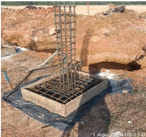
Gambar 3.12 Perakitan Bekisting Tapak Pagar BRC (Sumber: Dokumentasi Lapangan, 2024)
