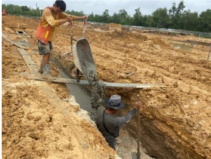
Gambar 3.77 Pekerjaan Lantai kerja (Sumber: Dokumentasi Lapangan, 2024)
