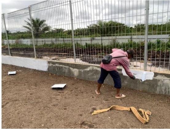
Gambar 3.42 Pengecatan Dinding Pagar BRC (Sumber: Dokumentasi Lapangan, 2024)
