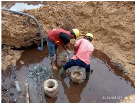
Gambar 3.54 Pemecahan Kepala Spun Pile (Sumber: Dokumentasi Lapangan, 2024)
