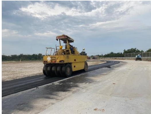
Gambar 3.95 Penggilasan lapisan aspal AC-WC (Sumber: Dokumentasi Lapangan, 2024)
