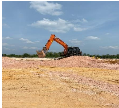
Gambar 3.3 Penimbunan Tanah (Sumber: Dokumentasi Lapangan, 2024)
