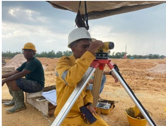
Gambar 3.76 Pengukuran Elevasi Lantai Kerja (Sumber: Dokumentasi Lapangan, 2024)
