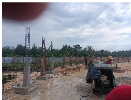
Gambar 3.17 Tapak Pondasi Pagar BRC Setelah Dibongkar Bekisting (Sumber: Dokumentasi Lapangan, 2024)
