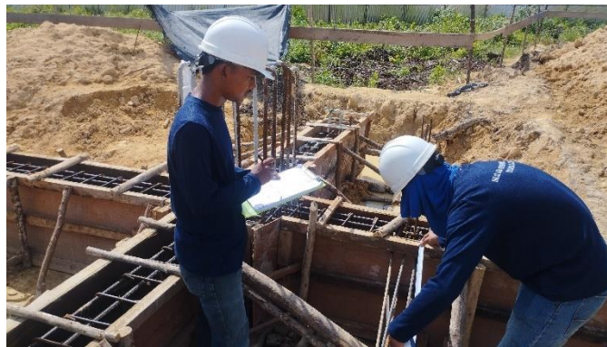
Gambar 3.68 Pengecekan Bekisting Sloof ( Sumber: Dokumentasi Lapangan, 2024)
