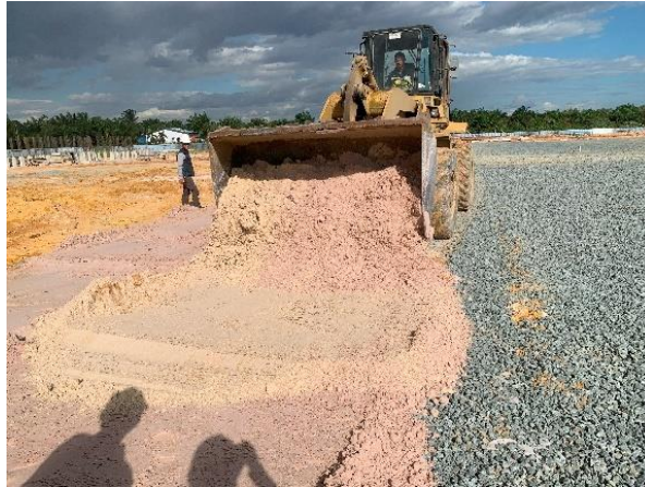
Gambar 3.70 Pengurugan Pasir ( Sumber: Dokumentasi Lapangan, 2024)
