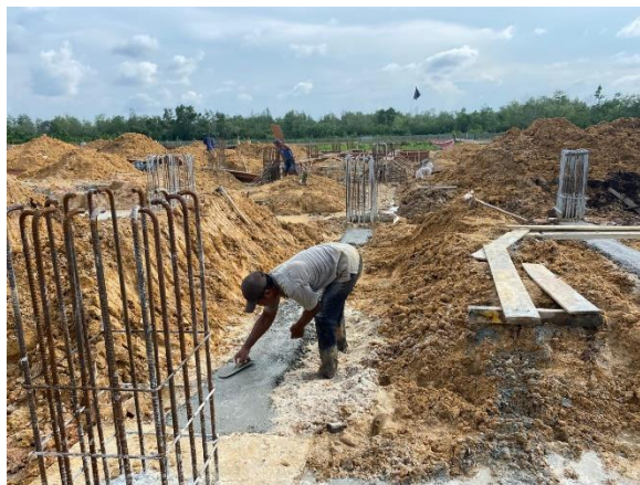
Gambar 3.63 pengecoran Lantai Kerja (Sumber: Dokumentasi Lapangan, 2024)
