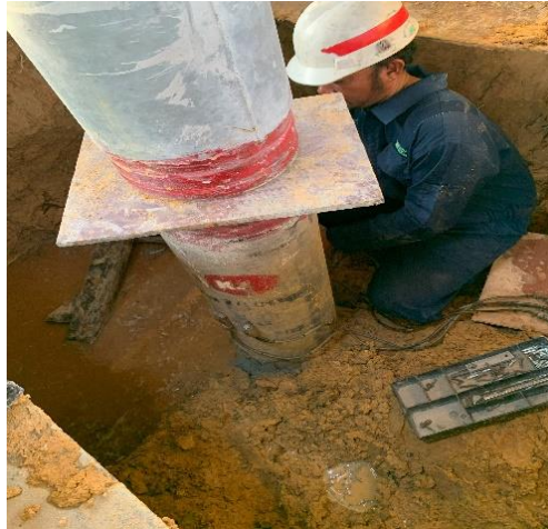
Gambar 3.49 PDA test (Sumber: Dokumentasi Lapangan, 2024)
