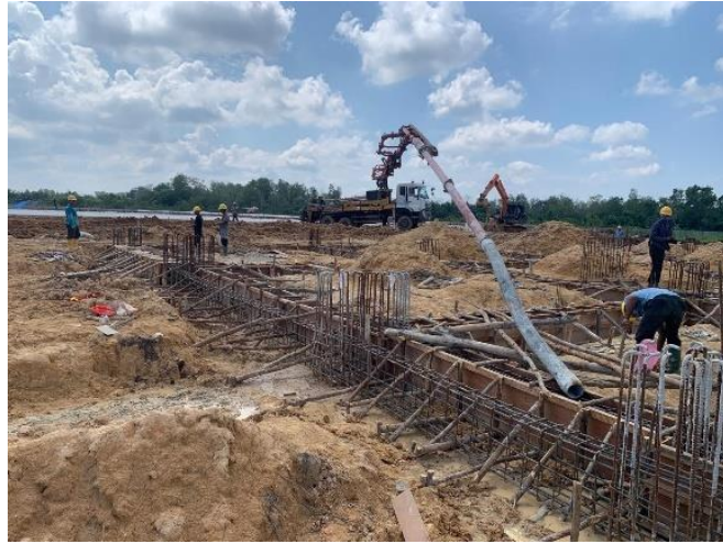
Gambar 3.70 Pengecoran Sloof ( Sumber: Dokumentasi Lapangan, 2024)
