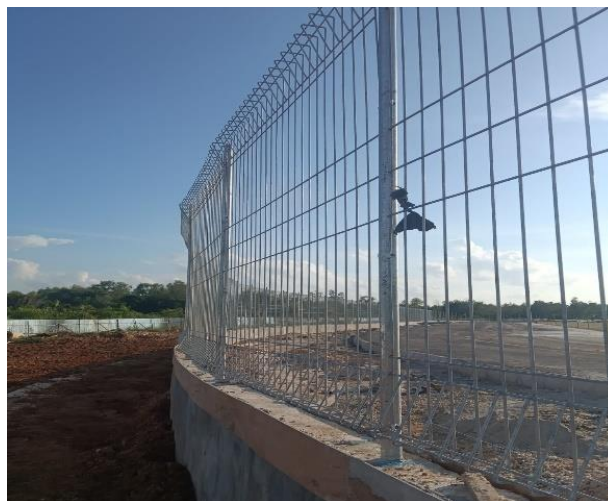
Gambar 3.40 Pasang Pagar BRC (Sumber: Dokumentasi Lapangan, 2024)
