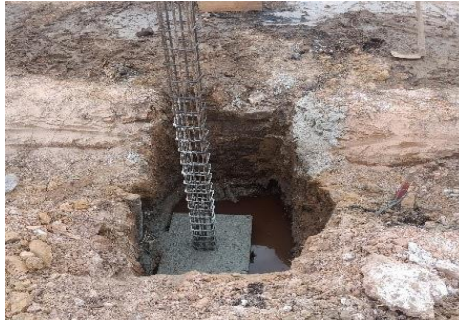
Gambar 3.15 Tapak Pondasi yang sudah Tercor (Sumber: Dokumentasi Lapangan, 2024)
