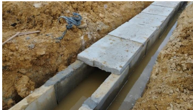
Gambar 3.79 Pemasangan Tutup U-Ditch (Sumber: Dokumentasi Lapangan, 2024)
