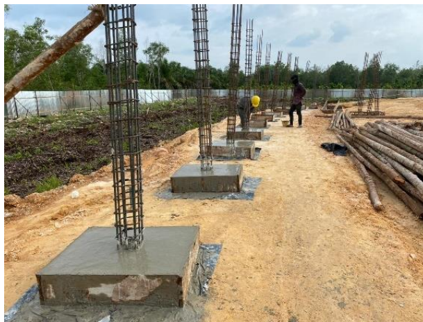
Gambar 3.19 Tulangan Kolom Setelah Dirakit (Sumber: Dokumentasi Lapangan, 2024)
