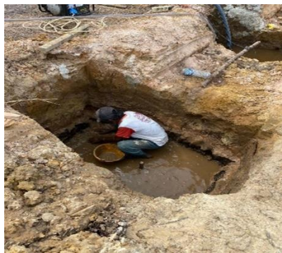
Gambar 3.11 Pekerjaan Lantai Kerja (Sumber: Dokumentasi Lapangan, 2024)
