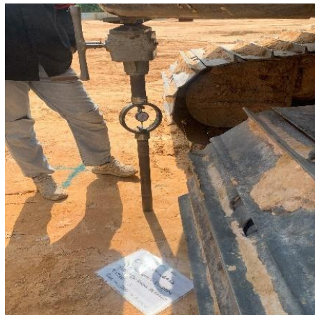
Gambar 3.6 Uji CBR Lapangan (Sumber: Dokumentasi Lapangan, 2024)
