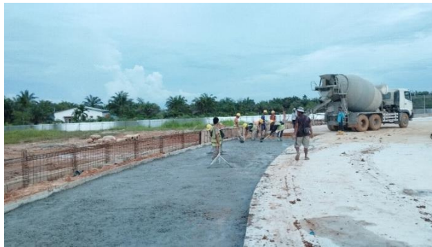
Gambar 3.90 Pengecoran Lantai Kerja K-100 (Sumber: Dokumentasi Lapangan, 2024)
