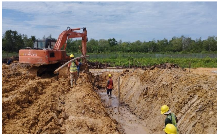
Gambar 3.73 Pekerjaan Galian Tanah (Sumber: Dokumentasi Lapangan, 2024)
