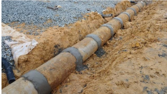
Gambar 3.86 Pemasangan Pipa beton Dia. 30 cm (Sumber: Dokumentasi Lapangan, 2024)
