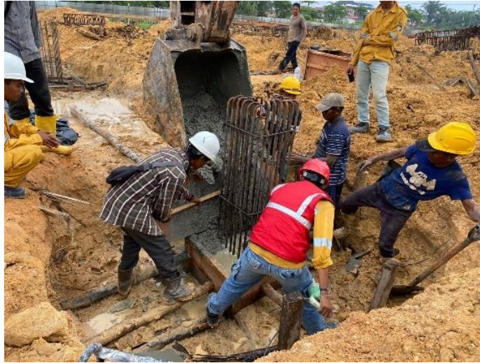
Gambar 3.60 Pengecoran Tapak Pondasi (Sumber: Dokumentasi Lapangan, 2024)
