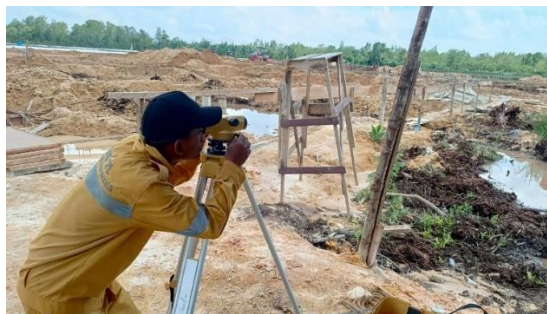
Gambar 3.65 Pengukuran Elevasi Bekisting Sloof (Sumber: Dokumentasi Lapangan, 2024)
