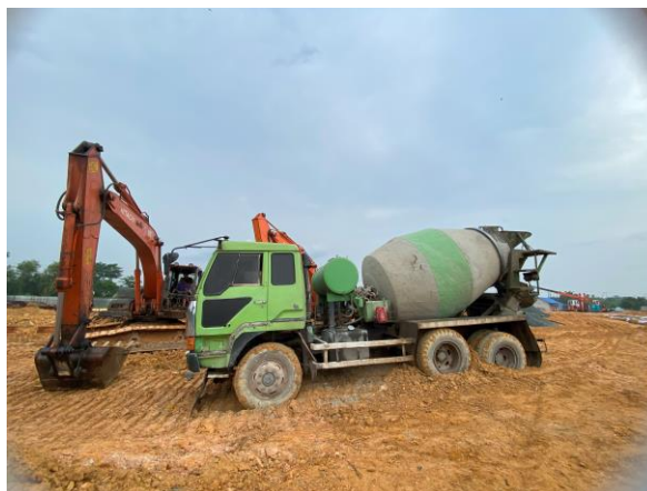
Gambar 3.58 Beton Ready Mix (Sumber: Dokumentasi Lapangan, 2024)
