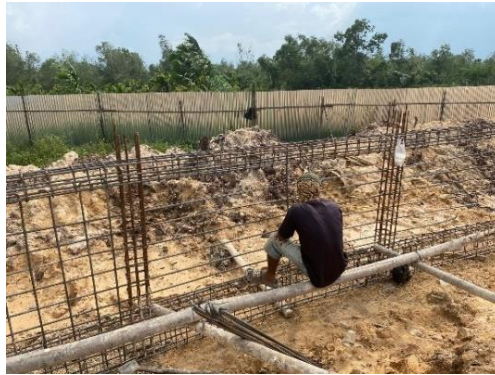
Gambar 3.33 Pembesian Balok dan Dinding Beton Bertulang (Sumber: Dokumentasi Lapangan, 2024)
