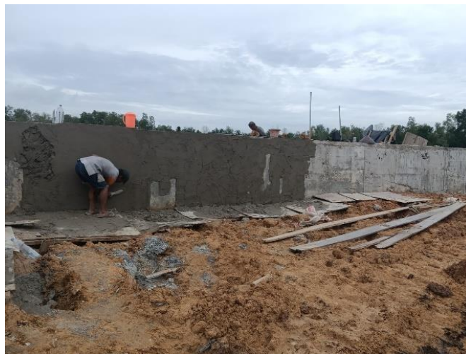
Gambar 3.41 Afwerking Beton (Sumber: Dokumentasi Lapangan, 2024)
