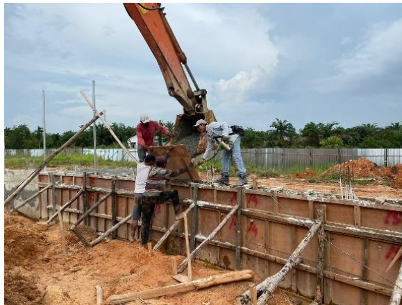
Gambar 3.37 Pengecoran Dinding (Sumber: Dokumentasi Lapangan, 2024)
