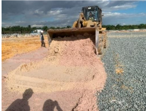
Gambar 3.4 Penghamparan Tanah (Sumber: Dokumentasi Lapangan, 2024)
