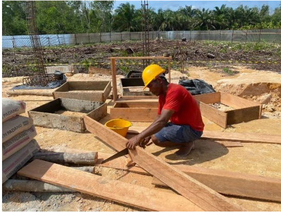
Gambar 3.57 Pemasangan bekisting (Sumber: Dokumentasi Lapangan, 2024)
