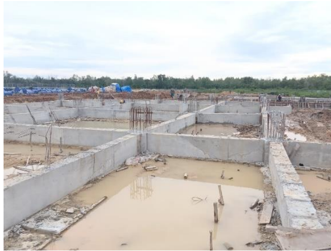
Gambar 3.72 Sloof Setelah Dibongkar Bekisting (Sumber: Dokumentasi Lapangan, 2024)
