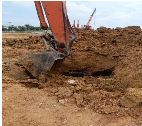
Gambar 3.50 Galian Tanah Spun Pile (Sumber: Dokumentasi Lapangan, 2024)
