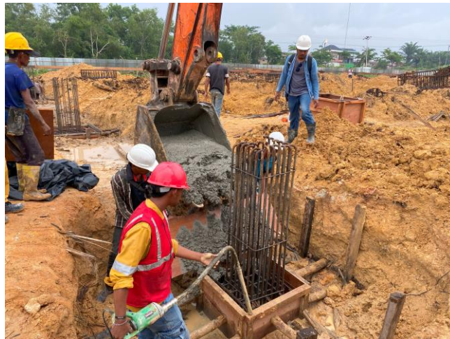
Gambar 3.61 Penggetaran Beton Menggunakan Vibrator (Sumber: Dokumentasi Lapangan, 2024)
