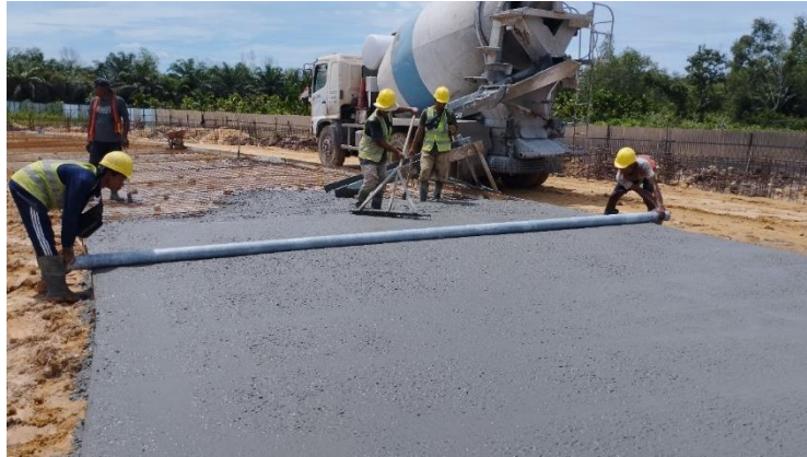
Gambar 3.92 Cor Beton K-225 (Sumber: Dokumentasi Lapangan, 2024)
