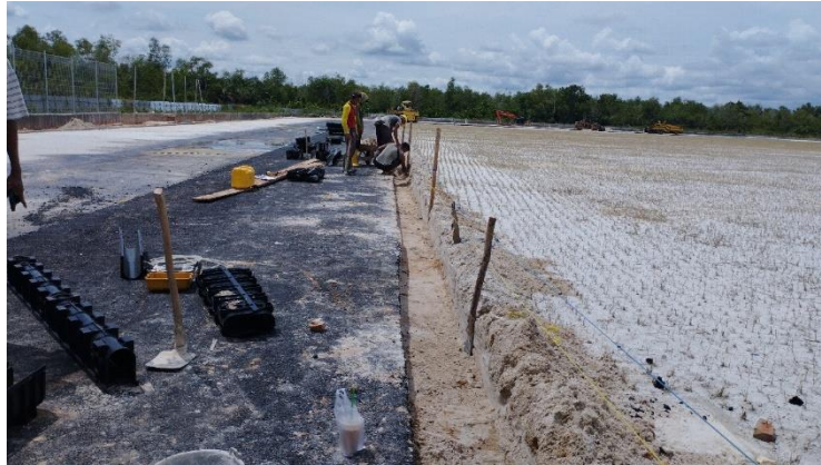
Gambar 3.87 Pemasangan ex. Aquatech sport (Sumber: Dokumentasi Lapangan, 2024)
