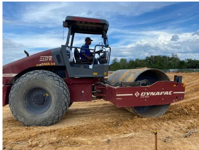
Gambar 3.5 Pemadatan Timbunan (Sumber: Dokumentasi Lapangan, 2024)
