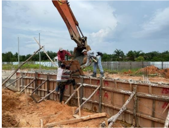
Gambar 3.38 Penggetaran Beton Menggunakan Vibrator (Sumber: Dokumentasi Lapangan, 2024)
