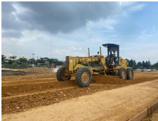
Gambar 3.74 Perataan Tanah Dengan Alat Motor grader (Sumber: Dokumentasi Lapangan, 2024)
