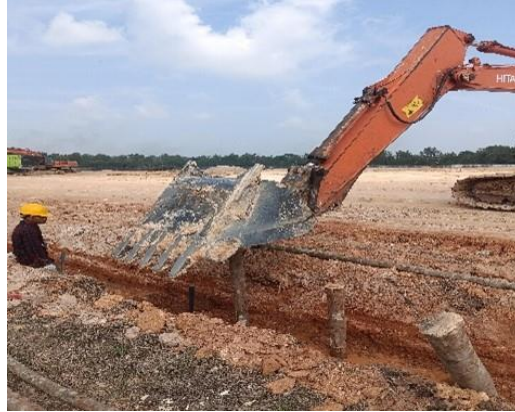
Gambar 3.10 Pekerjaan Pemancangan Cerucuk Kayu (Sumber: Dokumentasi Lapangan, 2024)
