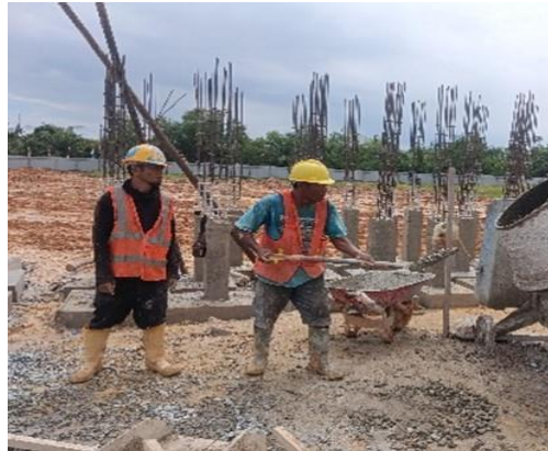
Gambar 3.13 Pengadukan Beton Di Lapangan Dengan Metode Site Mix (Sumber: Dokumentasi Lapangan, 2024)
