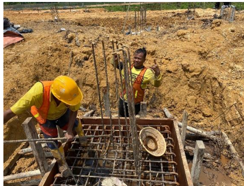
Gambar 3.56 Pembesian Tapak Pondasi (Sumber: Dokumentasi Lapangan, 2024)
