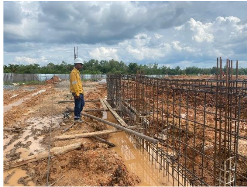
Gambar 3.35 Pengecekan balok dan pekerjaan dinding pagar BRC (Sumber: Dokumentasi Lapangan, 2024)
