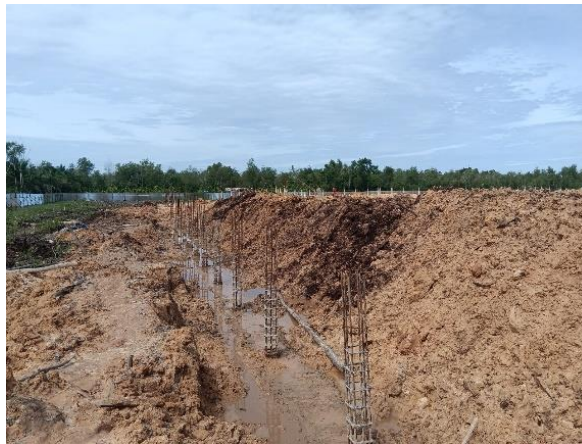
Gambar 3.27 Pondasi dan Tulangan Kolom Pedestal Setelah Dilakukan Pengurukan (Sumber: Dokumentasi Lapangan, 2024)
