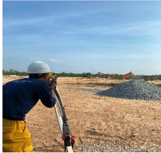
Gambar 3.52 Pengukuran Elevasi Tiang Pancang (Sumber: Dokumentasi Lapangan, 2024)
