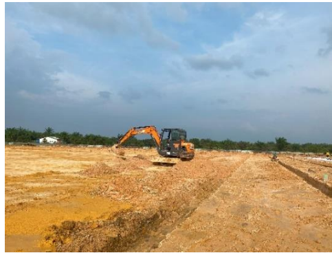
Gambar 3.64 Pekerjaan Galian Pipa HDPE (Sumber: Dokumentasi Lapangan, 2024)
