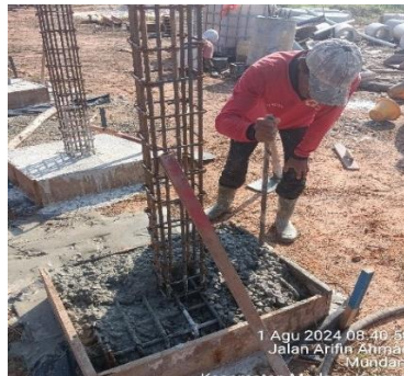
Gambar 3.16 Penggetaran Beton Menggunakan Vibrator (Sumber: Dokumentasi Lapangan, 2024)
