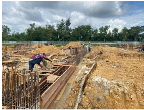
Gambar 3.66 Instal Bekisting Sloof ( Sumber: Dokumentasi Lapangan, 2024)
