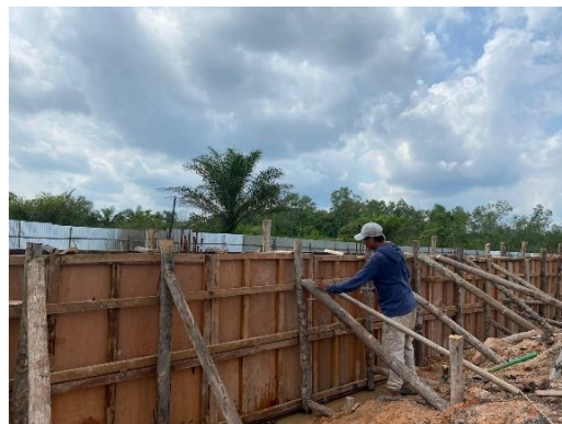
Gambar 3.34 Pemasangan Bekisting (Sumber: Dokumentasi Lapangan, 2024)
