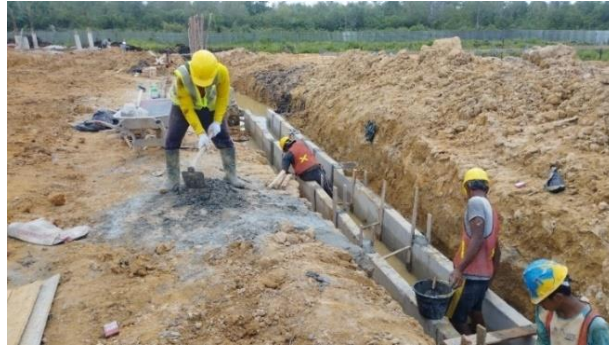
Gambar 3.78 Pekerjaan Pasang U-ditch (Sumber: Dokumentasi Lapangan, 2024)
