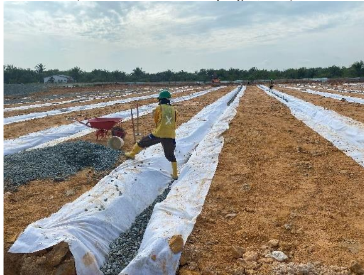
Gambar 3.80 Pekerjaan Pengurugan Batu Split Pada Galian (Sumber: Dokumentasi Lapangan, 2024)
