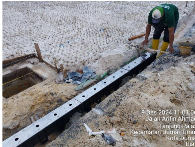
Gambar 3.88 Pemasangan ex. Slotted channel (Sumber: Dokumentasi Lapangan, 2024)
