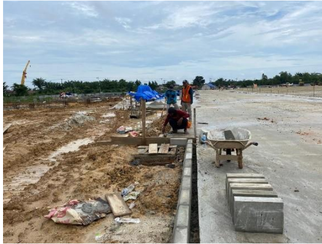
Gambar 3.89 Pemasangan Kanstin (Sumber: Dokumentasi Lapangan, 2024)
