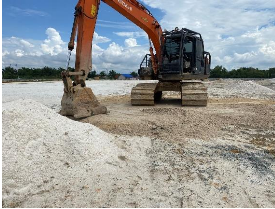
Gambar 2.13 Excavator (Sumber :Dokumentasi Lapangan,2024)
