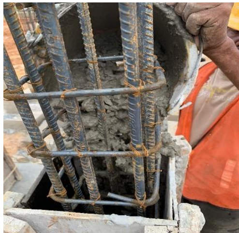
Gambar 3.23 Penuangan Beton Kedalam Bekisting (Sumber: Dokumentasi Lapangan, 2024)
