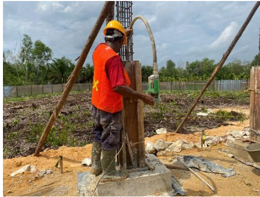
Gambar 3.24 Penggetaran Beton Menggunakan Vibrator Beton (Sumber: Dokumentasi Lapangan, 2024)
