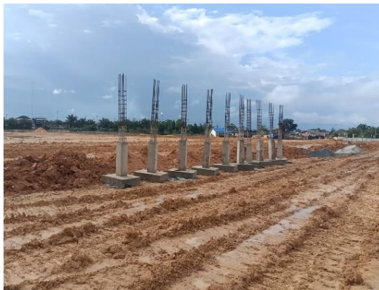
Gambar 3.25 Hasil Kolom Setelah Dibongkar (Sumber: Dokumentasi Lapangan, 2024)
