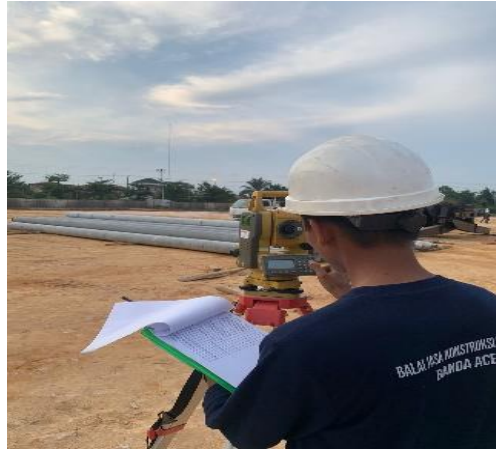
Gambar 3.43 Penentuan Titik Koordinat Tiang Pancang (Sumber: Dokumentasi Lapangan, 2024)
