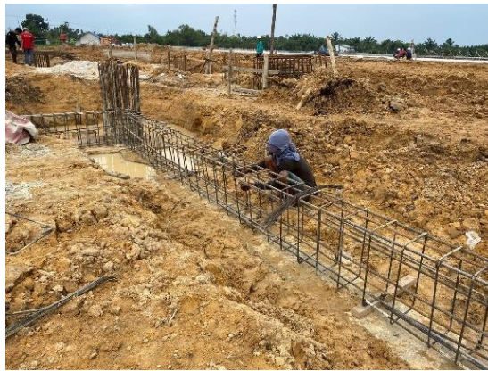
Gambar 3.64 Pemasangan Besi Sloof 30 X 60 cm (Sumber: Dokumentasi Lapangan, 2024)
