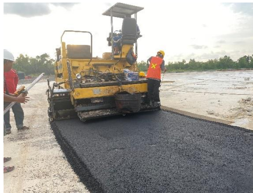
Gambar 3.94 Penggelaran Aspal AC-WC (Sumber: Dokumentasi Lapangan, 2024)
