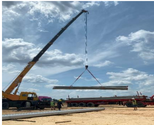
Gambar 3.45 Penurunan Spun Pile (Sumber: Dokumentasi Lapangan, 2024)
