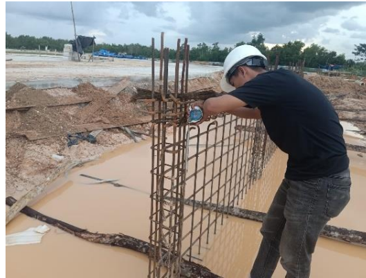
Gambar 3.20 Pengecekan Diameter Kolom (Sumber: Dokumentasi Lapangan, 2024)
