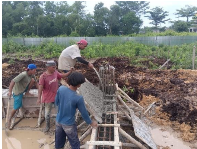
Gambar 3.71 Penggetaran Beton Menggunakan Vibrator ( Sumber: Dokumentasi Lapangan, 2024)
