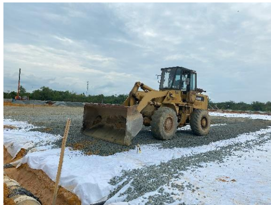
Gambar 3.69 Pengurugan Batu Split ( Sumber: Dokumentasi Lapangan, 2024)
