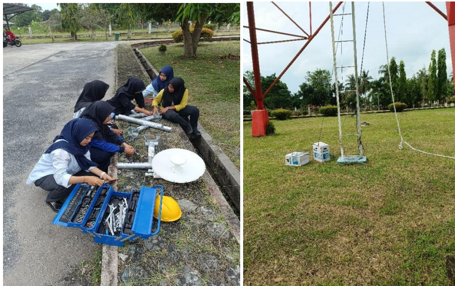
Gambar 3. 2 Melakukan Persiapan Pemasangan Antena Di Tiang Tower Kantor IT
