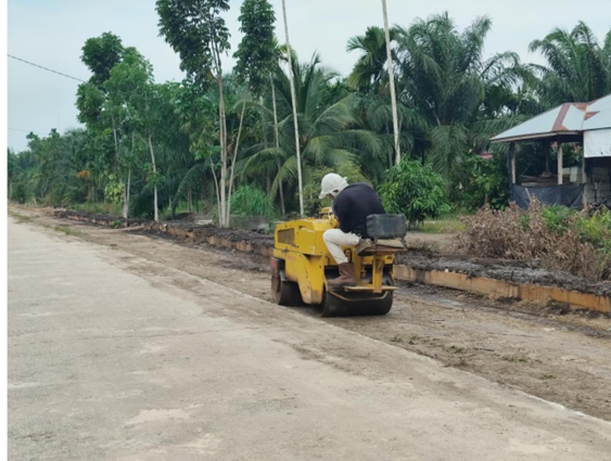
Gambar 3.19 Pekerjaan memadatkan dan meratakan tanah dasar (Sumber : Dokumentasi Lapangan, Kerja Praktek 2024)
