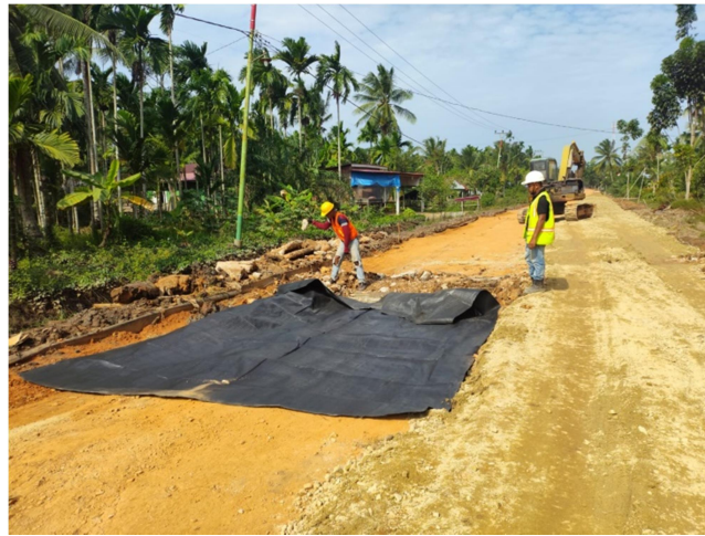
Gambar 3.30 Pemasangan Geotextile (Sumber : Dokumentasi Lapangan, Kerja Praktek 2024)
