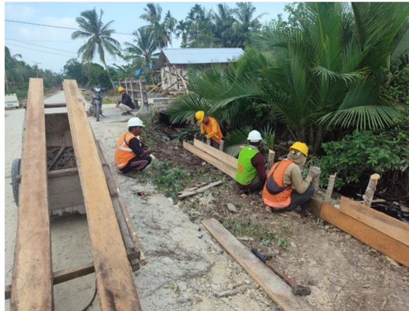
Gambar 3.17 Pekerjaan Dinding Turap Kayu (Sumber : Dokumentasi Lapangan, Kerja Praktek 2024)
