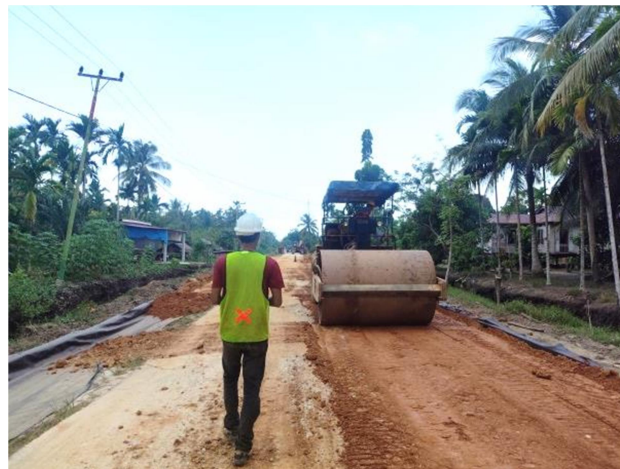
Gambar 3.23 Pemadatan Tanah Timbunan Pilihan (Sumber : Dokumentasi Lapangan, Kerja Praktek 2024)
