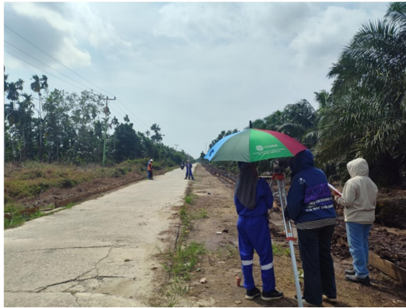
Gambar 3.20 Survey Volume Tanah Timbunan (Sumber : Dokumentasi Lapangan, Kerja Praktek 2024)
