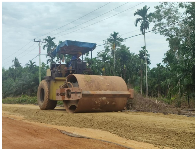
Gambar 3.27 Pemadatan Lapis Pondasi Agregat Kelas B ( Base B ) (Sumber : Dokumentasi Lapangan, Kerja Praktek 2024)
