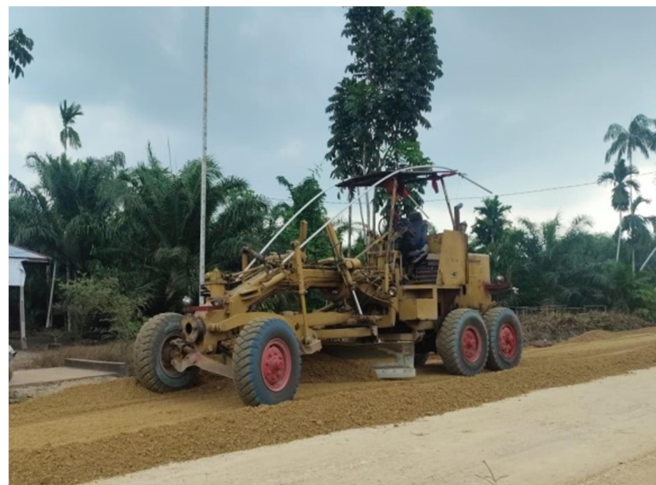
Gambar 4.2 Penghamparan Base B dilokasi proyek (Sumber : Dokumentasi Lapangan, Kerja Praktek 2024)
