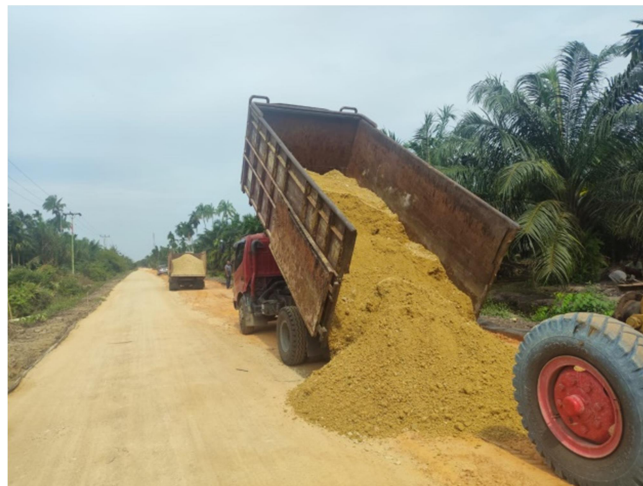
Gambar 4.1 Mobilisasi Base B dari Batching Plant (Sumber : Dokumentasi Lapangan, Kerja Praktek 2024)
