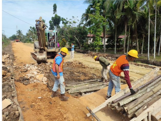
Gambar 3.29 Pekerjaan Gambangan (Sumber : Dokumentasi Lapangan, Kerja Praktek 2024)
