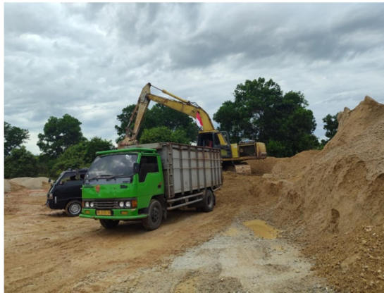
Gambar 3.16 Lapis Pondasi Agregat Kelas B ( Base B ) (Sumber : Dokumentasi Lapangan, Kerja Praktek 2024)
