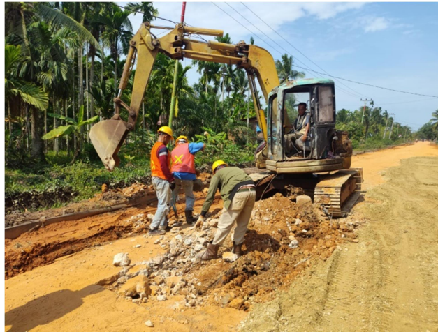
Gambar 3.28 Pekerjaan Patching Pada Jalan (Sumber : Dokumentasi Lapangan, Kerja Praktek 2024)
