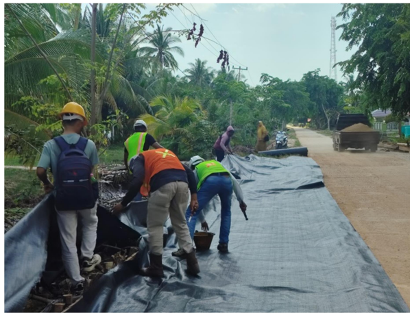
Gambar 3.21 Pekerjaan Pemasangan Geotextile (Sumber : Dokumentasi Lapangan, Kerja Praktek 2024)
