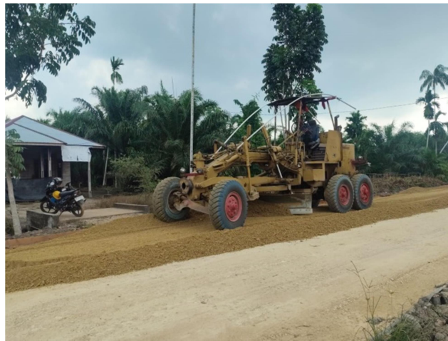
Gambar 3.26 Penghamparan Lapis Pondasi Agregat Kelas B ( Base B ) (Sumber : Dokumentasi Lapangan, Kerja Praktek 2024)
