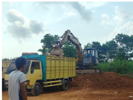
Gambar 3.15 Tanah Timbunan Pilihan (Sumber : Dokumentasi Lapangan, Kerja Praktek 2024)
