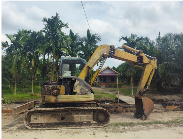
Gambar 3.3 Excavator (Sumber : Dokumentasi Lapangan, Kerja Praktek 2024)
