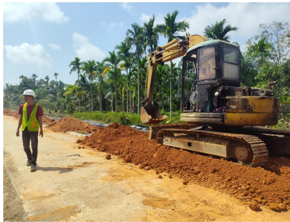
Gambar 3.22 Penghamparan Tanah Timbunan Pilihan (Sumber : Dokumentasi Lapangan, Kerja Praktek 2024)
