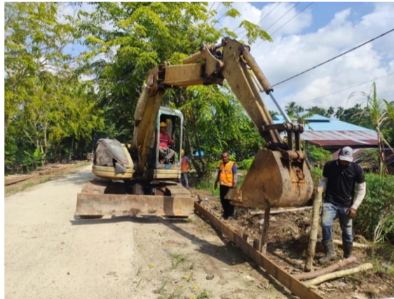
Gambar 3.18 Pekerjaan Pemancangan Kayu (Sumber : Dokumentasi Lapangan, Kerja Praktek 2024)
