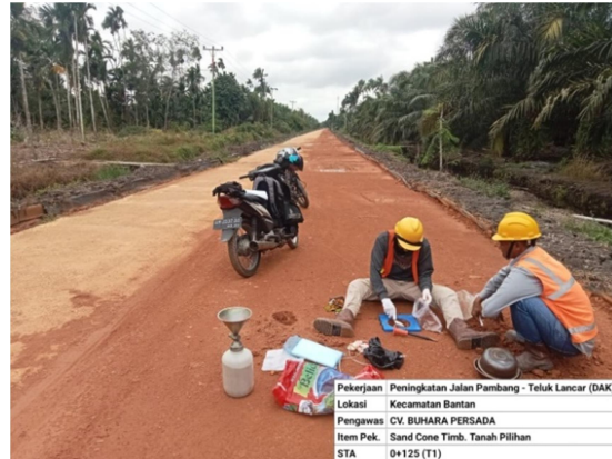
Gambar 3.25 Pengujian Sand Cone (Sumber : Dokumentasi Lapangan, Kerja Praktek 2024)
