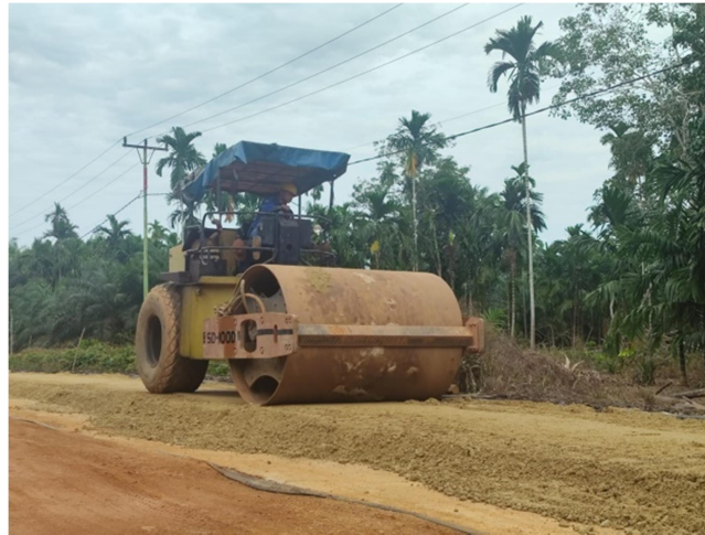
Gambar 4.3 Pemadatan Base B menggunakan Vibratory Roller (Sumber : Dokumentasi Lapangan, Kerja Praktek 2024)
