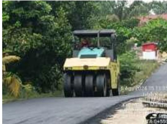
*gambar 4. 13 Pematatan kedua menggunakan tire roller
