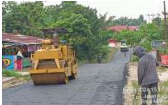
*gambar 4. 14 Pematatan ketiga menggunakan tendem roller
