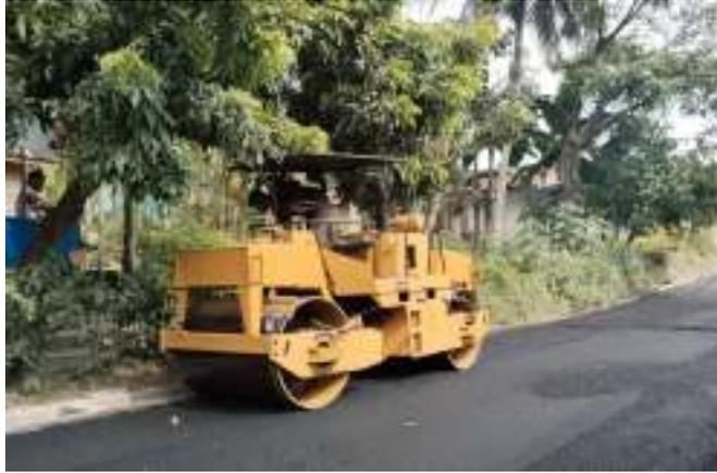
*gambar 3. 20 Pematatan Asphalt
