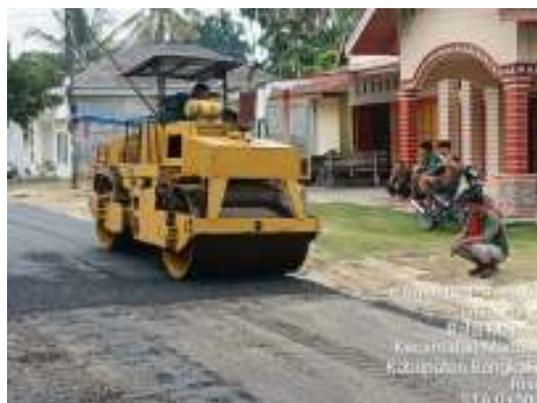
*gambar 4. 12 Pematatan Pertama menggunakan Tendem roller
