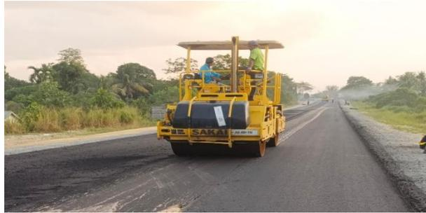
**Gambar 3. 22 Pemadatan dengan alat berat tandem roller**
