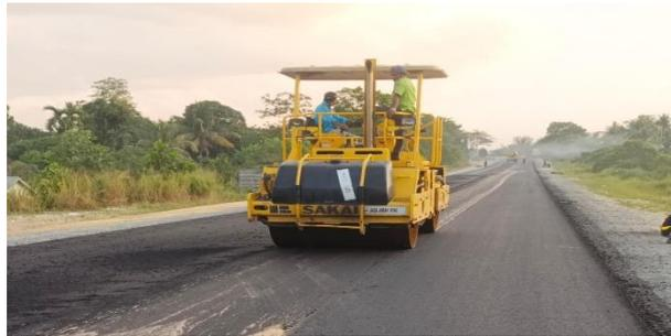
**Gambar 3. 18 Pemadatan dengan alat berat tandem roller**
