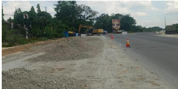
**Gambar 3. 13** Tumpukkan material Base A setelah diturunkan
