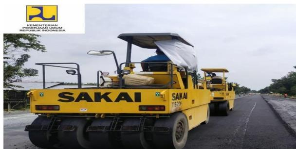
**Gambar 3. 23 pemadatan material AC-BC dengan alat berat Pneumatic Tired Roller (PTR)**
