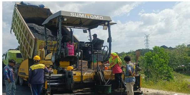
**Gambar 3. 21 Penghamparan Material AC-WC dengan menggunakan alat Asphalt Finisher**
