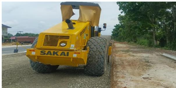
**Gambar 3. 15 pamasatan material base A menggunakan Vibratory Roller**
