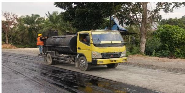
**Gambar 3. 16 Penyemprotan Lapis Perekat (Prime Coat)**
