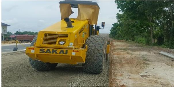
**Gambar 3. 12 pematatan material base B menggunakan Vibratory Roller**
