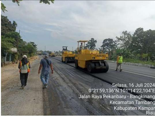
dengan truck bermuatan asphalt nya, Dengan temperature angkut  $160^{\circ}$  suhu saat dihampar kan  $140^{\circ}$  dengan ukuran ketebalan hamparan/gemburan 5 cm dan ketebalan setelah dipadatkan 4 cm
