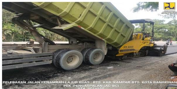
**Gambar 3. 17 Penghamparan Lapis Pondasi AC-BC menggunakan alat asphalt finisher**
