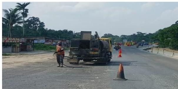
**Gambar 3. 20 penyemprotan Tack Coat**
