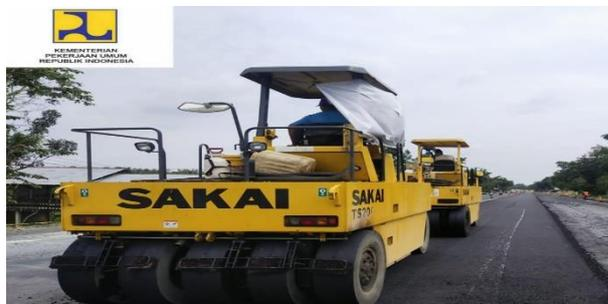
**Gambar 3. 19 pemadatan material AC-BC dengan alat berat Pneumatic Tire Roller (PTR)**
