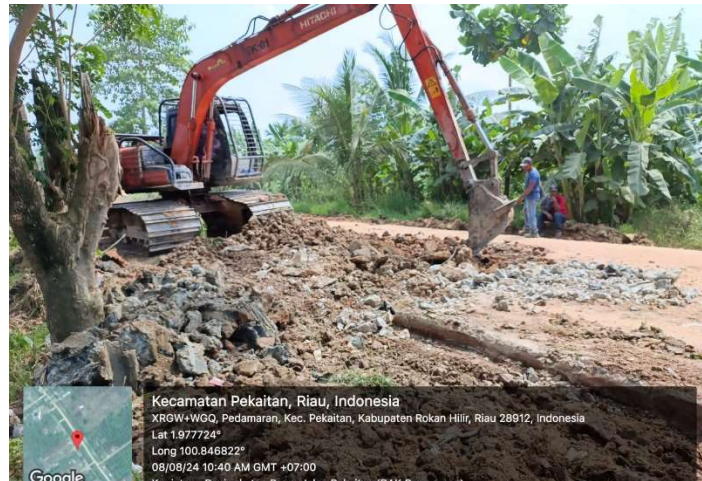
Gambar 4.1 Pemecahan Semenisasi Lama ( Sumber : Dokumentasi Lapangan, 2024)
