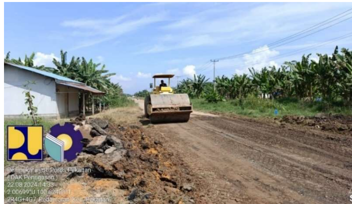
Gambar 4.7 Pemadatan Base Lama ( Sumber : Dokumentasi Lapangan, 2024)
