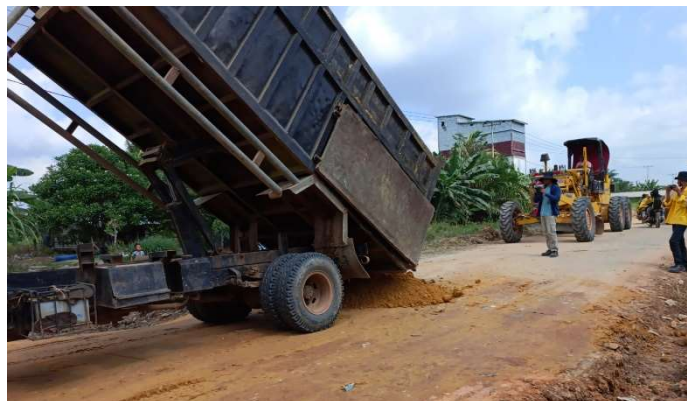
Gambar 4.3 Penghamparan Tanah Timbunan ( Sumber : Dokumentasi Lapangan, 2024)
