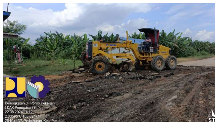
Gambar 4.6 Pelebaran Pada Bahu Jalan ( Sumber : Dokumentasi Lapangan, 2024)
