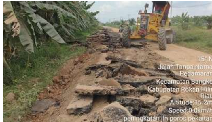
Gambar 4.5 Pengelupasan Aspal Lama ( Sumber : Dokumentasi Lapangan, 2024)
