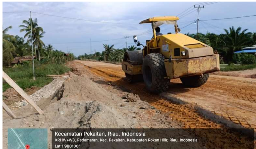
Gambar 4.4 Pemadatan Tanah Timbunan ( Sumber : Dokumentasi Lapangan, 2024)
