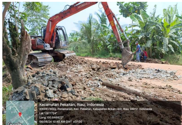
Gambar 3.7 Penanganan Pada Semenisasi Lama ( Sumber : Dokumentasi Lapangan, 2024)
