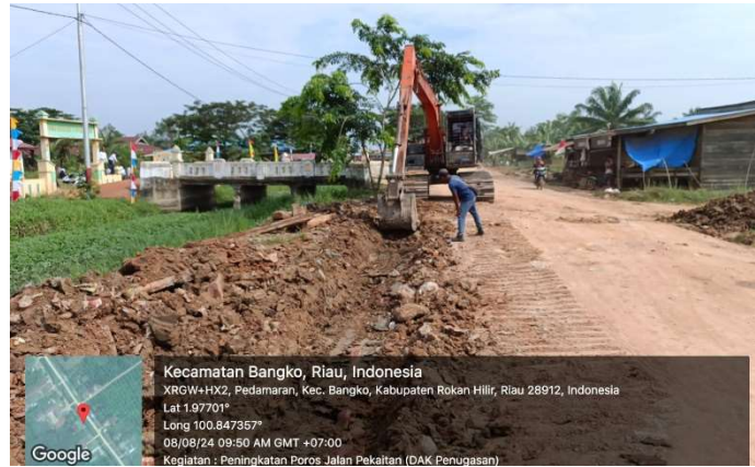
Gambar 4.2 Penggalian pada Bahu Jalan ( Sumber : Dokumentasi Lapangan, 2024)
