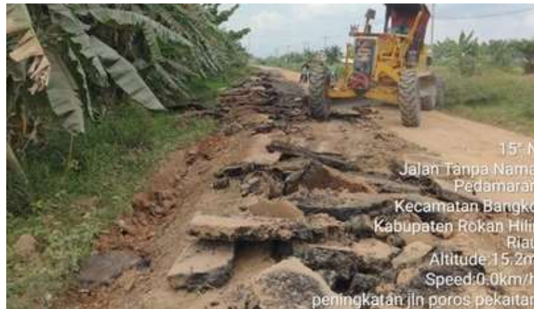
Gambar 3.8 Penanganan Aspal Lama ( Sumber : Dokumentasi Lapangan, 2024)
