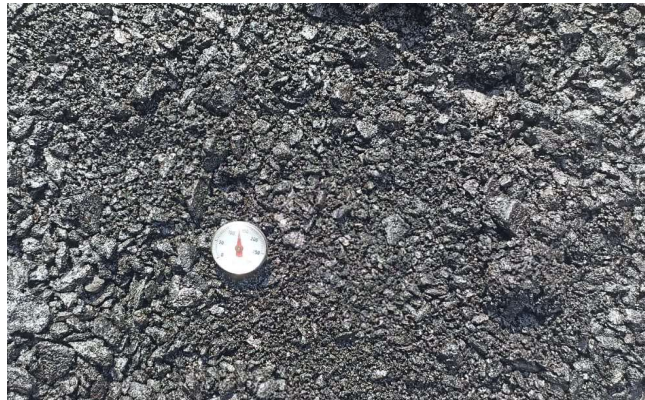
Gambar 3 37 pengecekan suhu pada pemadatan TR& PTR
