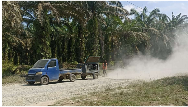
Gambar 4 2 Pekerjaan Kompresor
