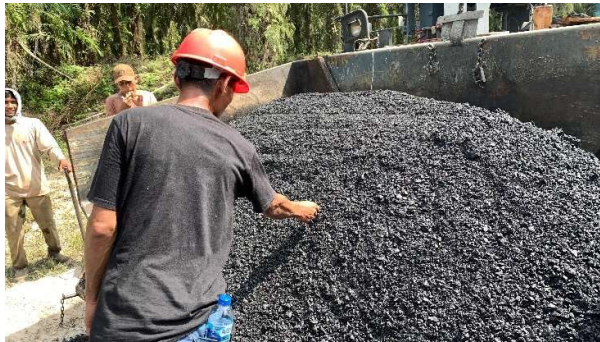
Gambar 3 36 Pengecekan suhu di Finisher
