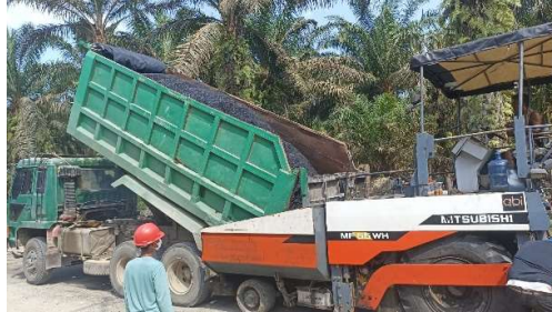
Gambar 3 26 Memasukkan aspal ke finisher
