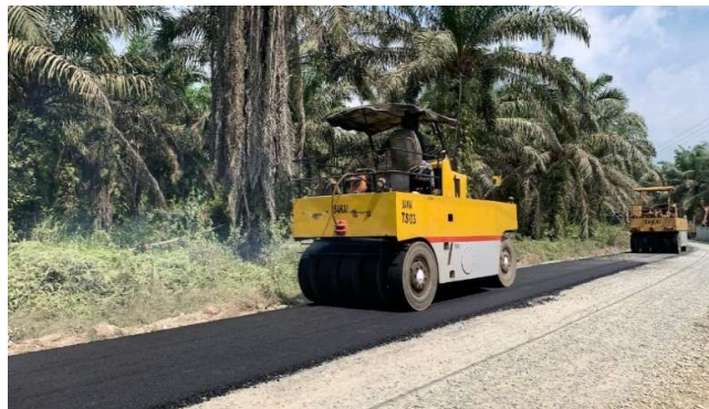
Gambar 4 11 Pemadatan awal Tandem Roller
