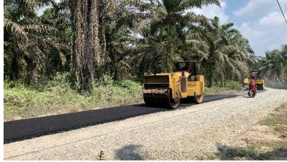
Gambar 3 28 Pemadatan alat Tandem Roller
