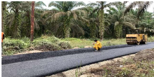
Gambar 3 30 Pengecekan suhu di Finisher
