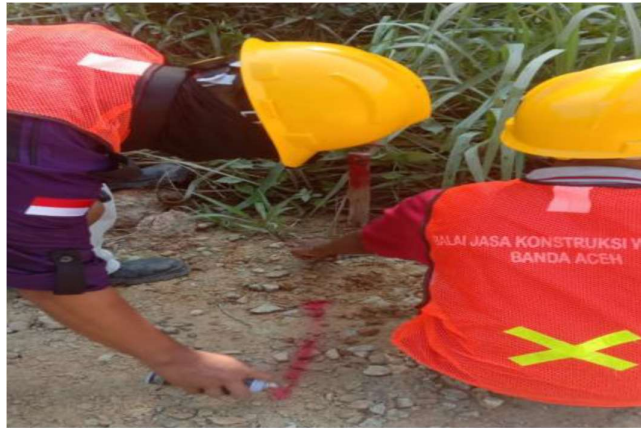
Gambar 3 14 pengukuran dan pematokkan
