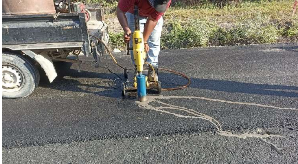
Gambar 3 38 Pekerjaan Core Drill AC WC
