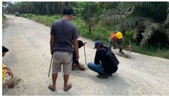
Gambar 3 23 pekerjaan Test Pit
