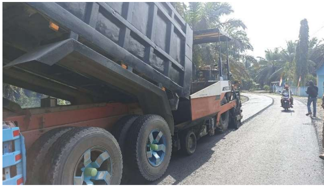
Gambar 3 34 Memasukkan asphalt ke Finisher
