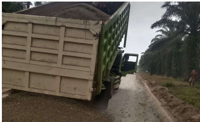
Gambar 3 16 Penumpukkan Base B oleh Dump Truck
