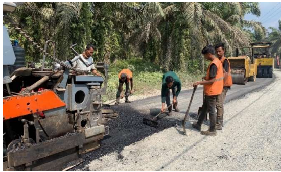
Gambar 4 8 Merapikan menggunakan cheker atau skop
