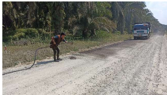
Gambar 3 25 Pekerjaan Asphal Sprayer
