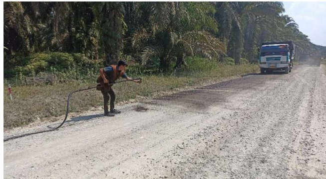
Gambar 4 3 Pekerjaan Aspal Sprayer
