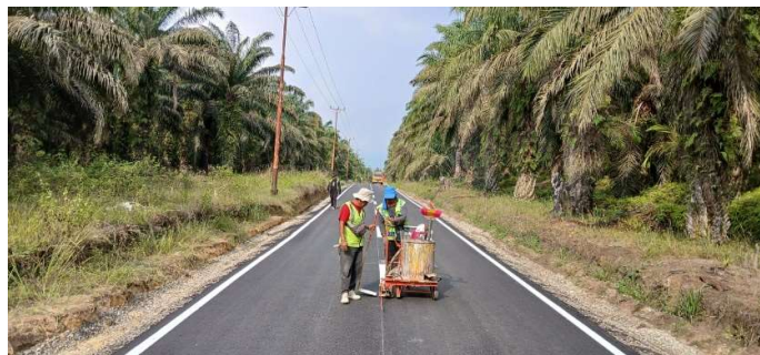
Gambar 3 40 Pekerjaan Marka Jalan
