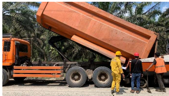
Gambar 4 6 Penuangan lapisan AC-BC ke bak mekanis Asphalt finisher
