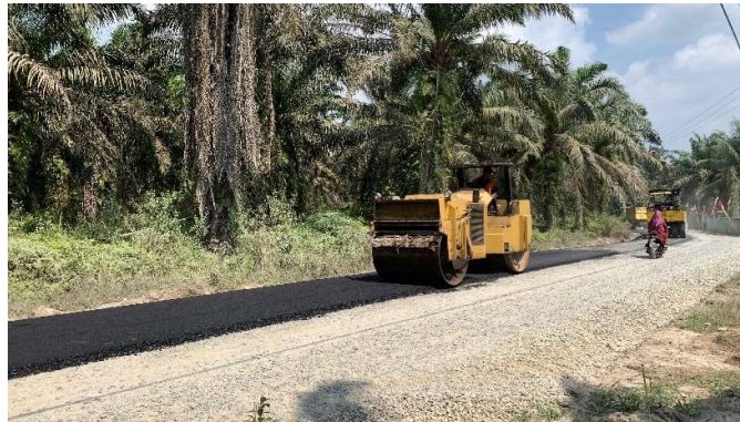
Gambar 4 9 Pemadatan awal Tandem Roller
