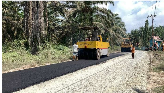
Gambar 3 29 Pemadatan alat Pneumatic Tire Roller
