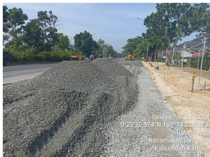
Gambar 9.4 Penghamparan Agregat Kelas A (sumber Dokumentasi lapangan 2024)
