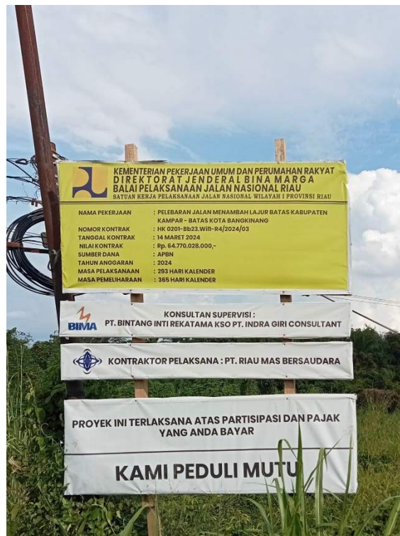
Gambar 4.2 Papan Proyek (Sumber Dokumentasi Lapangan 2024)
