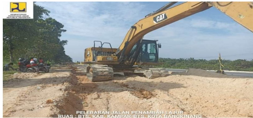
PELEBARAN JALAN PENAMBAH LAJUR RUAS : BTS. KAB. KAMPAR-BTS. KOTA BANGKINANG Gambar 7.2 Pekerjaan Tanah Timbun Pilihan (sumber Dokumentasi lapangan 2024)
