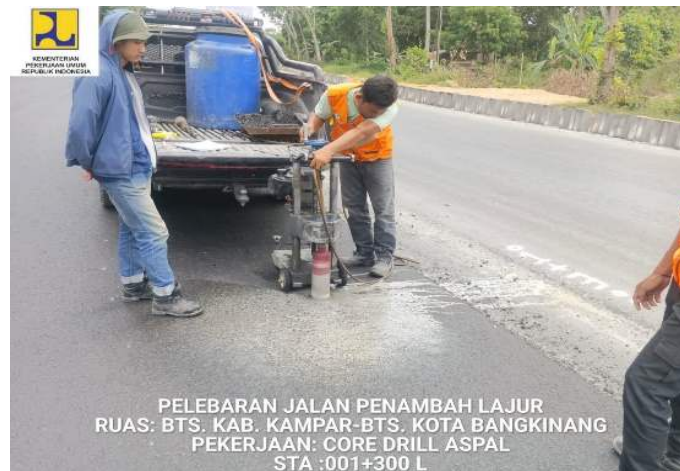
Gambar 14.9 Core Drill Aspal (sumber Dokumentasi lapangan 2024)
