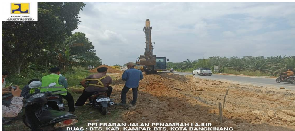
Gambar 6.1 Pekerjaan Galian (sumber Dokumentasi lapangan2024)
