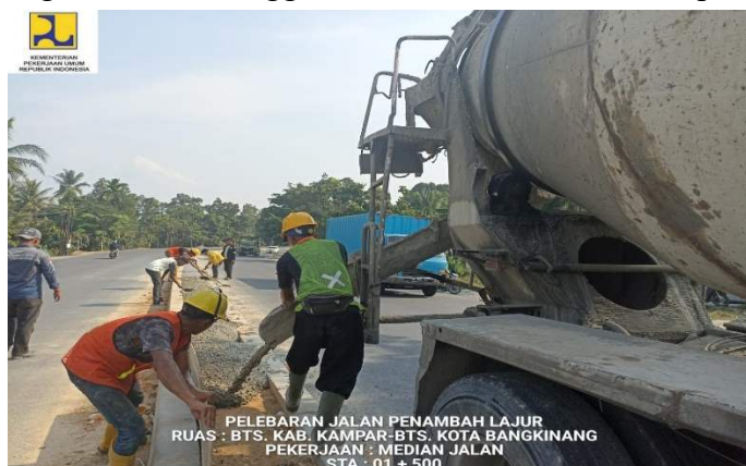
Gambar 16.11 Pengecoran Median Jalan (sumber Dokumentasi lapangan 2024)
