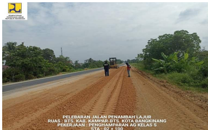
Gambar 15.10 Penghamparan Agregat Kelas S (Sumber Dokumentasi Lapangan)
