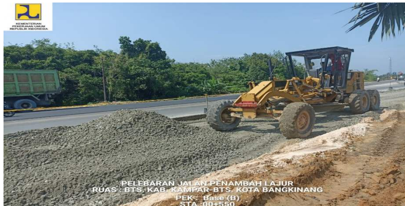
Gambar 8.3 Penghamparan Agregat Kelas B (sumber Dokumentasi lapangan 2024)
