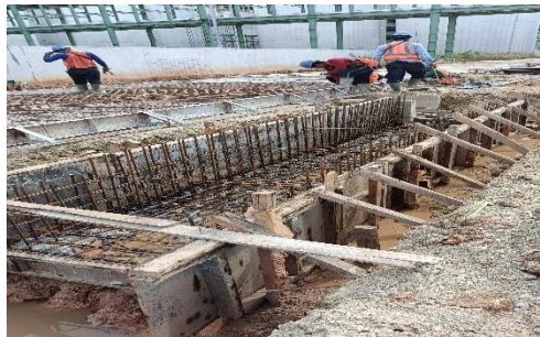
Gambar 3 .8 Pembesian Struktur Bawah (Sumber : Dokumentasi lapangan 2024)
