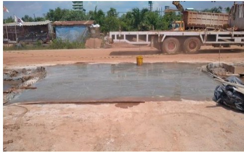
Gambar 3.13 Perawatan Beton (Sumber : Dokumentasi lapangan 2024)
