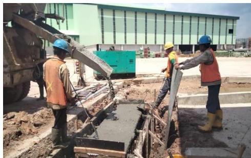
Gambar 3 .12 Pemasangan Plat Atas (Sumber : Dokumentasi lapangan 2024)
