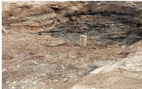
Gambar 3. 6 Peletakan Patok (Sumber : Dokumentasi lapangan 2024)
