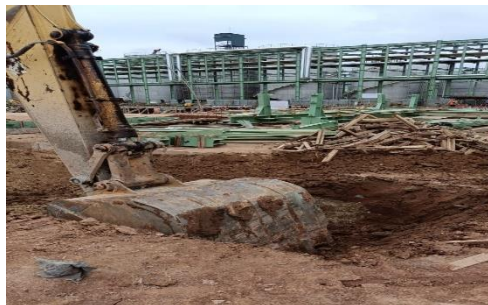
Gambar 3.5 Pekerjaan Galian (Sumber : Dokumentasi lapangan 2024)
