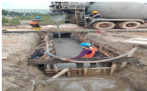
Gambar 3 .10 Pengecoran Plat Bawah (Sumber : Dokumentasi lapangan 2024)
