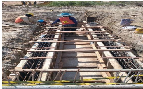
Gambar 3 .11 Pemasangan Dinding Vertikal (Sumber : Dokumentasi lapangan 2024)
