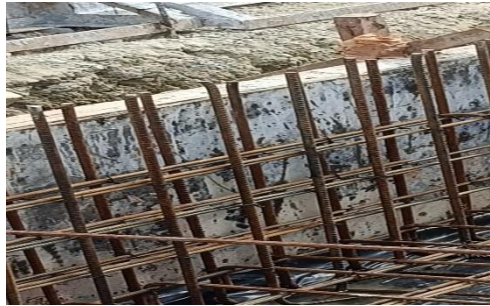
Gambar 3 .9 Besi Tulangan Dinding (Sumber : Dokumentasi lapangan 2024)
