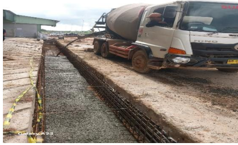
Gambar 3 .7 Pembuatan Lean Concrete (Sumber : Dokumentasi lapangan 2024)
