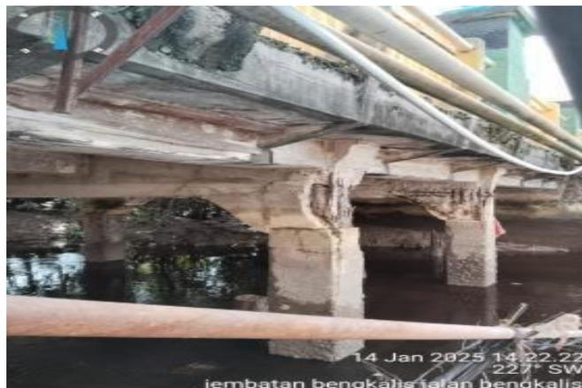
**Gambar 3. 1** *Kondisi Jembatan Sungai Bengkalis jalan bengkalis pada saat ini*
