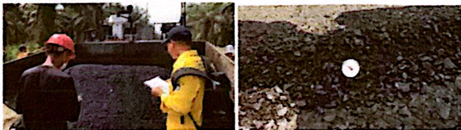
Gambar 3.35 Pekerjaan Pengecekan Suhu Aspal
