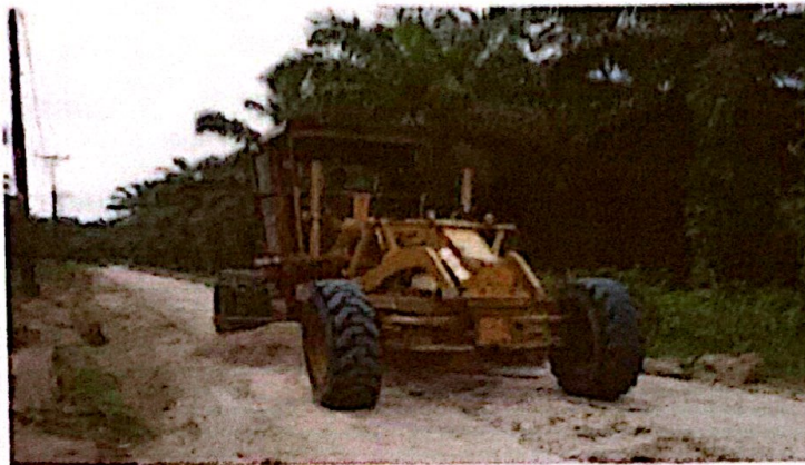
Gambar 3.13 Penyiapan Badan Jalan
