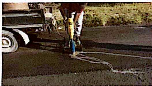
Gambar 3.34 Pekerjaan Core Drill AC-WC
