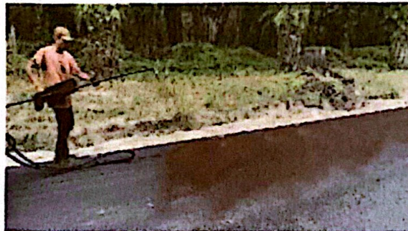
Gambar 3.29 Penyemprotan Lapis Perekat Aspal
