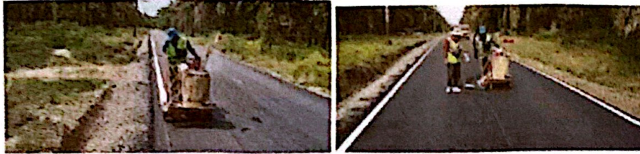
Gambar 3.38 Pekerjaan Marka Jalan
