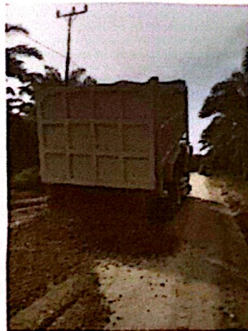
Gambar 3.15 Penuangan Base A
