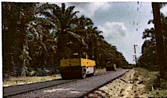
Gambar 3.33 Pemadatan Akhir AC-WC
