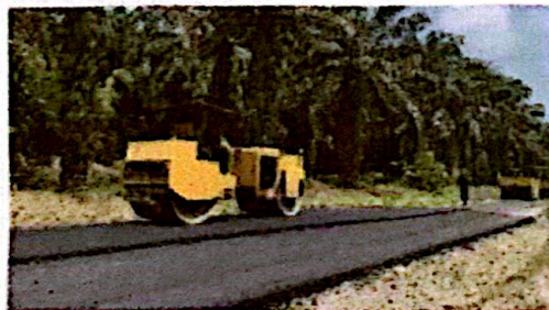
Gambar 3.32 Pemadatan Awal Ac-Wc
