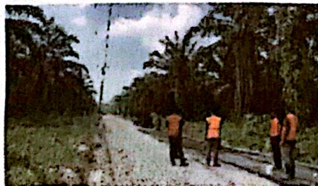
Gambar 3.23 Penyemprotan Aspal Perekat
