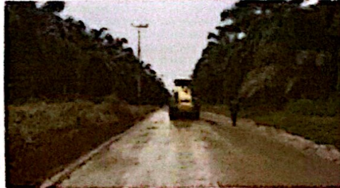
Gambar 3.17 Pemadatan Material Base A
