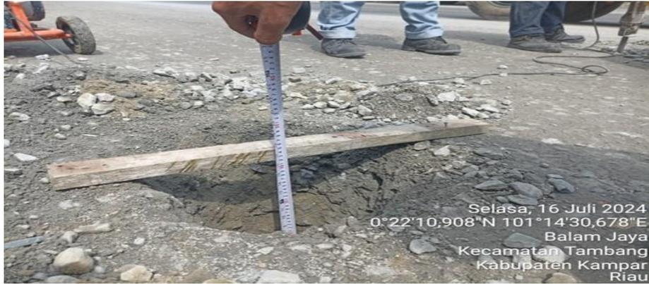
Gambar 2. 2 Tebal perkerasan
