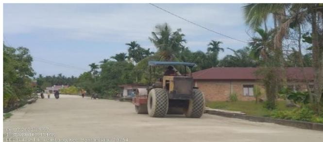
Gambar 3 20 Pekerjaan Agregat Kelas B
