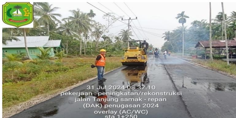
Gambar 3 26 Pekerjaan Pemadatan Awal Asphalt AC-WC Tandem Roller (Sumber) : Dokumentasi lapangan,2024
