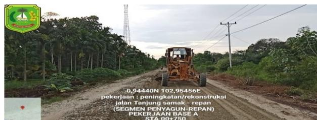
Gambar 3 21 Pekerjaan Agregat Kelas A
