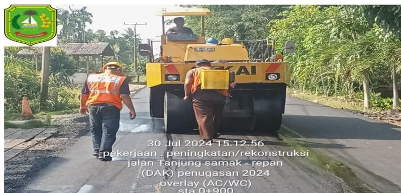
Gambar 3 27 Pekerjaan Pemadatan Akhir Asphalt AC-WC PTR (Sumber): Dokumentasi Lapangan,2024
