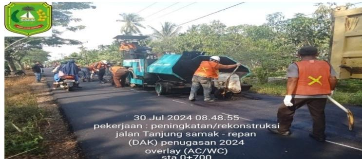
Gambar 3 25 Pekerjaan Penghamparan Asphalt AC-WC
