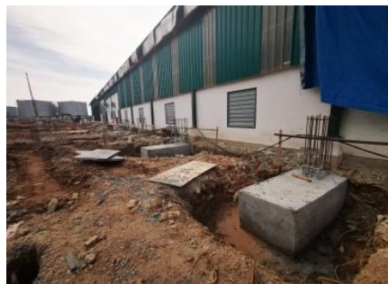
Gambar 3.43 Hasil Setelah Pengecoran (Sumber : Dokumentasi lapangan, 2024)
