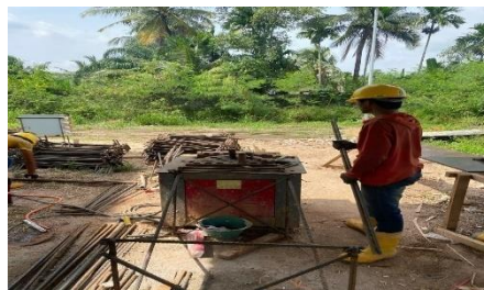
Gambar 3.26 Mesin pembengkokan tulangan (Sumber : Dokumentasi lapangan, 2024)
