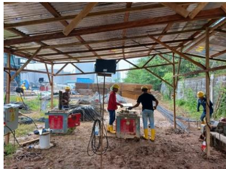
Gambar 3.25 Pekerjaan Pembengkokan Tulangan (Sumber : Dokumentasi lapangan, 2024)
