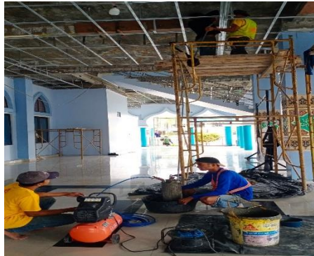
Gambar 3.63 Proses menyalurkan material ke packers (Sumber : Dokumentasi lapangan, 2024)
