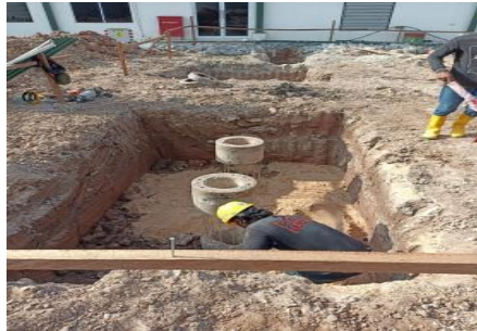
Gambar 3.20 Pekerjaan Urugan (Sumber : Dokumentasi lapangan, 2024)
