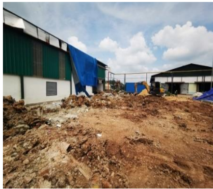
Gambar 3.7 Pembersihan Lokasi Proyek (Sumber : Dokumentasi lapangan, 2024)
