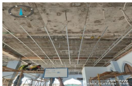
Gambar 3.47 Pekerjaan penandaan (Sumber : Dokumentasi lapangan, 2024)
