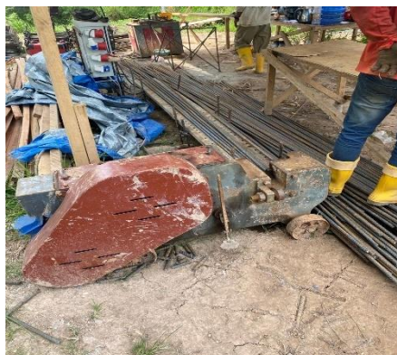
Gambar 3.24 Alat pemotong besi (Sumber : Dokumentasi lapangan, 2024)
