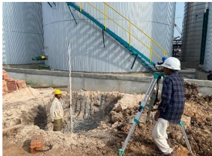
Gambar 3.16 Proses marking pada Bore pile pada pondasi F1 (Sumber : Dokumentasi lapangan, 2024)
