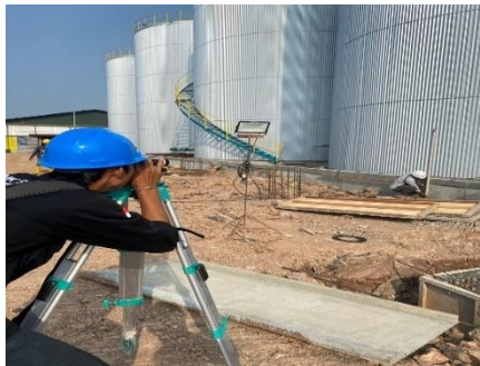
Gambar 3.15 Proses mencari elvasi dari titik \pm 0,00 (Sumber : Dokumentasi lapangan, 2024)
