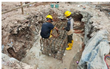
Gambar 3.28 Pekerjaan Perakitan Tulangan F1 (Sumber : Dokumentasi lapangan, 2024)
