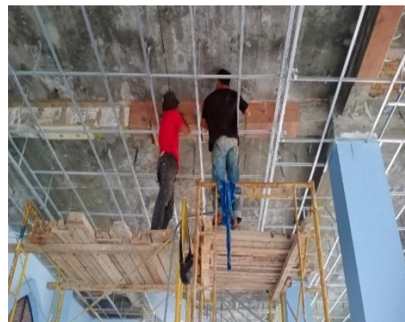
Gambar 3.52 Pekerjaan pengeboran (Sumber : Dokumentasi lapangan, 2024)
