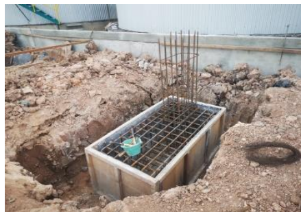
Gambar 3.33 Setelah Bekisting di Pasang (Sumber : Dokumentasi lapangan, 2024)
