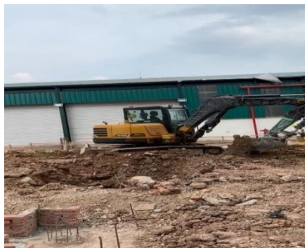
Gambar 3.5 Ekskavator kecil sany SY55C (Sumber : Dokumentasi lapangan, 2024)
