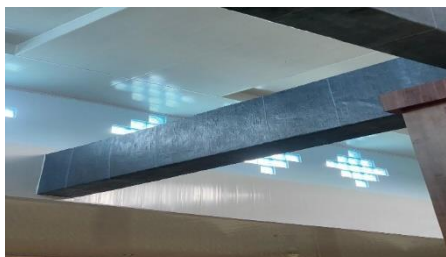
Gambar 3.69 Bentuk balok setelah di pasang (Sumber : Dokumentasi lapangan, 2024)
