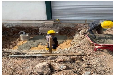
Gambar 3.21 Pekerjaan Lantai Kerja (Sumber : Dokumentasi lapangan, 2024)
