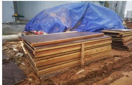
Gambar 3.31 Bekisting (Sumber : Dokumentasi lapangan, 2024)
