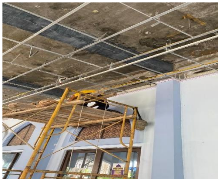
Gambar 3.68 Pekerjaan pemasangan CFRP Sika WRAP 321c (Sumber : Dokumentasi lapangan, 2024)
