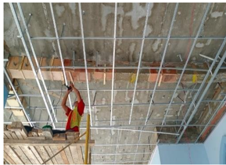
Gambar 3.56 Pemasangan packers (Sumber : Dokumentasi lapangan, 2024)
