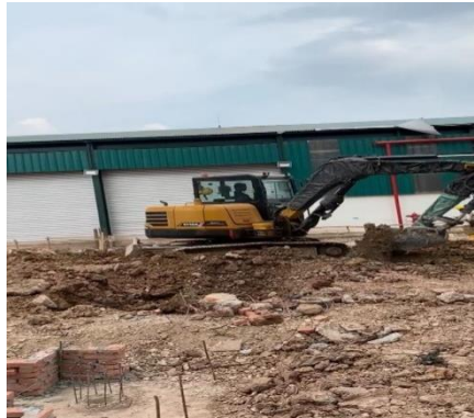
Gambar 3.8 Pekerjaan Galian (Sumber : Dokumentasi lapangan, 2024)
