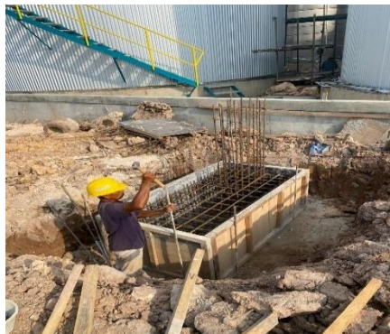
Gambar 3.38 Proses marking Top cor pondasi F1 (Sumber : Dokumentasi lapangan, 2024)
