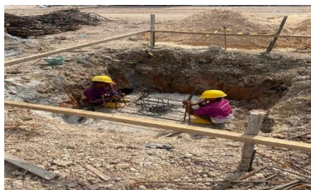
Gambar 3.30 Pekerjaan Perakitan Tulangan F1 (Sumber : Dokumentasi lapangan, 2024)
