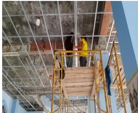
Gambar 3.64 Proses menyalurkan material ke packers (Sumber : Dokumentasi lapangan, 2024)
