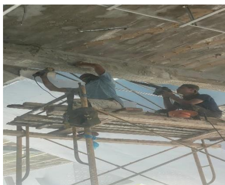
Gambar 3.50 Pembersihan area retak (Sumber : Dokumentasi lapangan, 2024)
