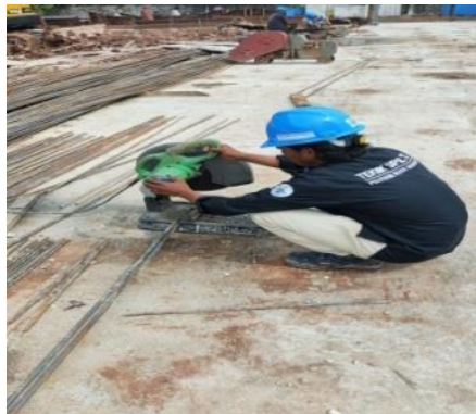
Gambar 3.23 Pekerjaan Pemotongan Besi menggunakan mesin cutting cut off (Sumber : Dokumentasi lapangan, 2024)
