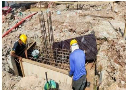
Gambar 3.32 Pekerjaan Pemasangan Bekisting F1 (Sumber : Dokumentasi lapangan, 2024)
