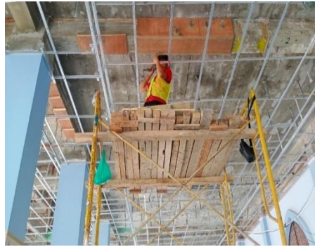
Gambar 3.55 Pemasangan packers (Sumber : Dokumentasi lapangan, 2024)
