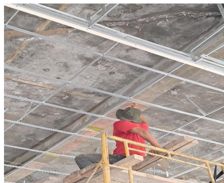
Gambar 3.65 Proses pelepasan Packers (Sumber : Dokumentasi lapangan, 2024)
