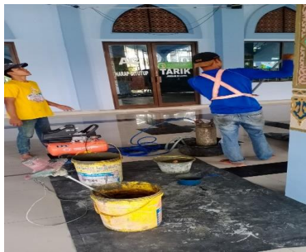
Gambar 3.58 Pencampuran Sikadur 752 (Sumber : Dokumentasi lapangan, 2024)
