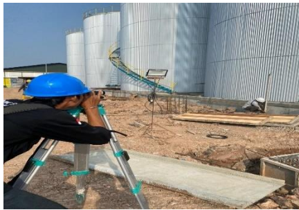
Gambar 3.37 Menembak di elvasi \pm 0,00 (Sumber : Dokumentasi lapangan, 2024)
