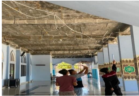
Gambar 3.44 Pemeriksaan truktur (Sumber : Dokumentasi lapangan, 2024)
