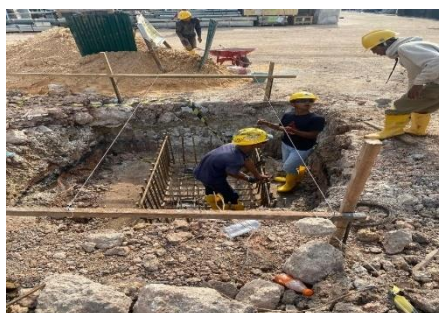
Gambar 3.29 Pekerjaan Perakitan Tulangan F1 (Sumber : Dokumentasi lapangan, 2024)
