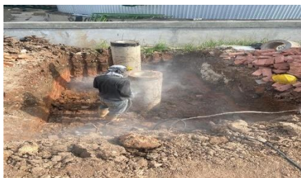
Gambar 3.17 Proses pemotongan bore pile yang sudah di marking (Sumber : Dokumentasi lapangan, 2024)
