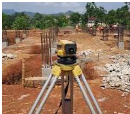
Gambar 3.9 Waterpass (Sumber : Dokumentasi lapangan, 2024)
