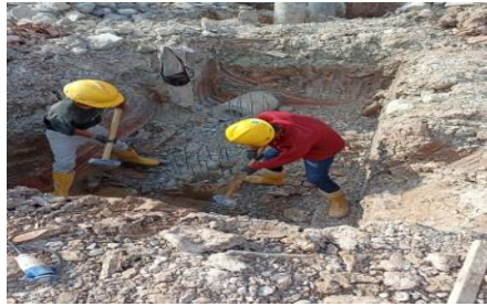
Gambar 3.18 Proses pembobokan bore pile setelah di potong (Sumber : Dokumentasi lapangan, 2024)
