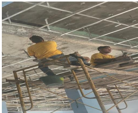
Gambar 3.67 Pekerjaan Pemasangan CFRP Sika WRAP 321c (Sumber : Dokumentasi lapangan, 2024)
