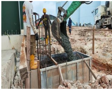
Gambar 3.42 Pekerjaan Pengecoran (Sumber : Dokumentasi lapangan, 2024)
