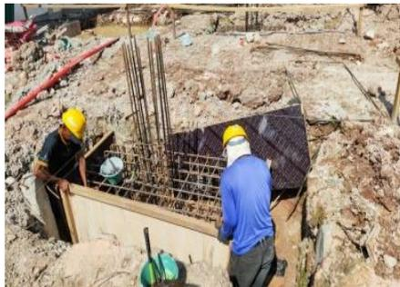
Gambar 3.32 Pekerjaan Pemasangan *Bekisting F1*
