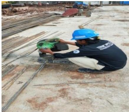
Gambar 3.23 Pekerjaan Pemotongan Besi menggunakan mesin *cutting cut off*
