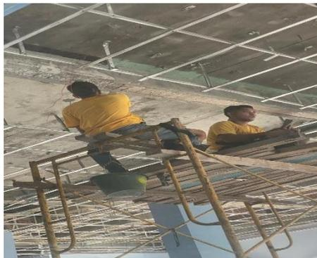
Gambar 3.67 Pekerjaan Pemasangan CFRP Sika WRAP 321c
