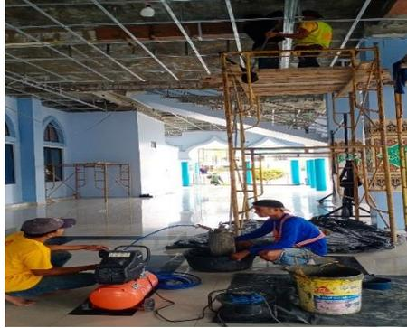
Gambar 3.63 Proses menyalurkan material ke *packers*
