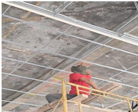
Gambar 3.65 Proses pelepasan *Packers*
