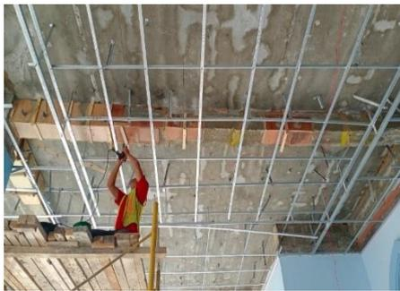
Gambar 3.56 Pemasangan *packers*
