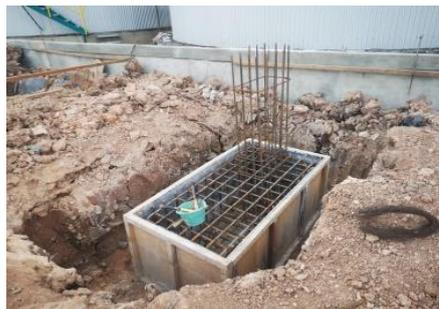
Gambar 3.33 Setelah *Bekisting* di Pasang
