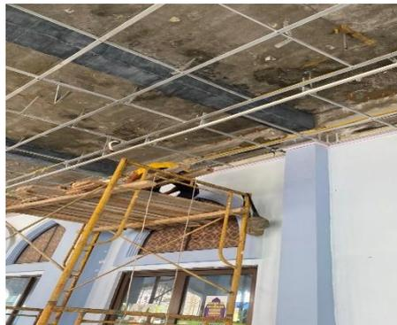
Gambar 3.68 Pekerjaan pemasangan CFRP Sika WRAP 321c
