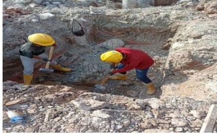
Gambar 3.18 Proses pembobokan *bore pile* setelah di potong
