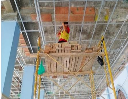
Gambar 3.55 Pemasangan *packers*
