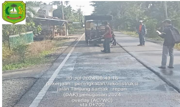
*Gambar 1. 32 Pekerjaan Prime Coat*
