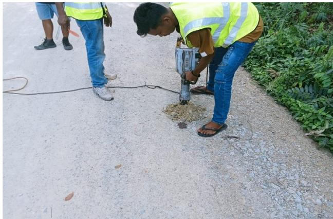
*Gambar 1. 25 Pekerjaan Core Drill Base A*
