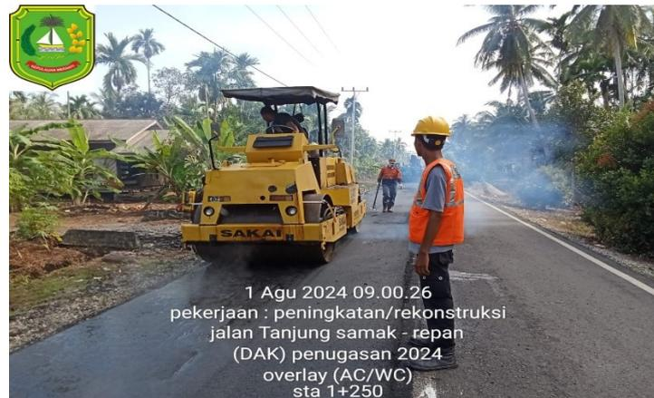
Gambar 1. 29 Pekerjaan Pemadatan Awal AC-WC Tandem Roller
