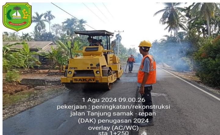
Gambar 1. 34 Pekerjaan Pematatan Awal AC-WC Tandem Roller
