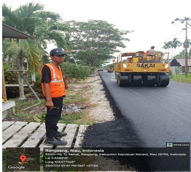
*Gambar 1. 35 Pekerjaan Pemasatan Akhir Aspal AC-WC PTR*
