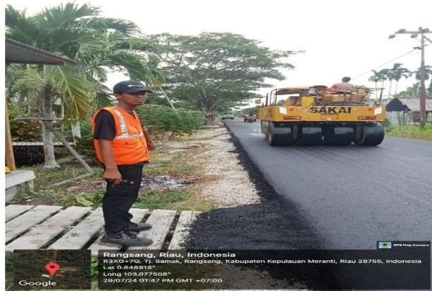
Gambar 1. 30 Pekerjaan Pemasangan Akhir Aspal AC-WC PTR
