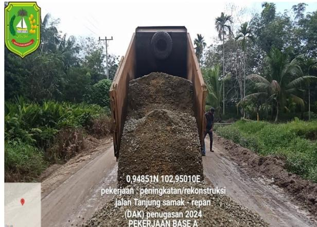
*Gambar 1. 23 Pekerjaan Agregat Kelas B*
