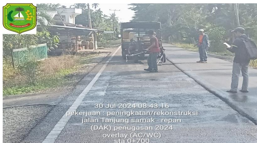
*Gambar 1. 27 Pekerjaan Prime Coat*
