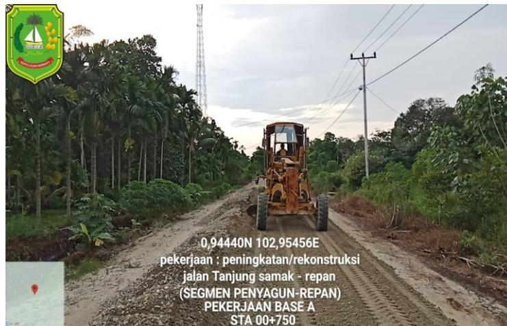
*Gambar 1. 24 Pekerjaan Agregat Kelas A*
