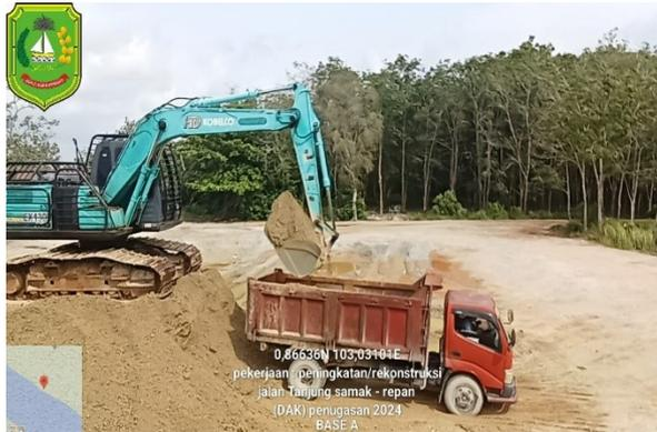
*Gambar 1. 20 Lapis Pondasi Agregat Kelas A*
