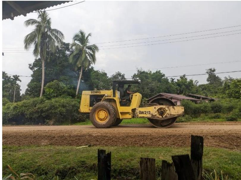
Gambar 3.5 Proses pemadatan Base A menggunakan vibrating roller
