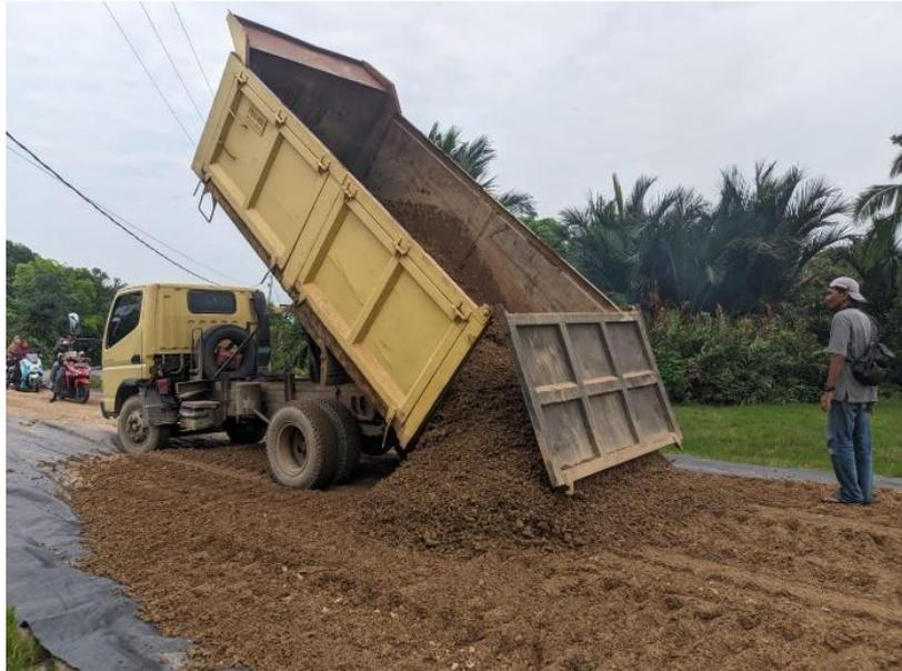
Gambar 3.3 Proses pengeluaran material dari dump truck
