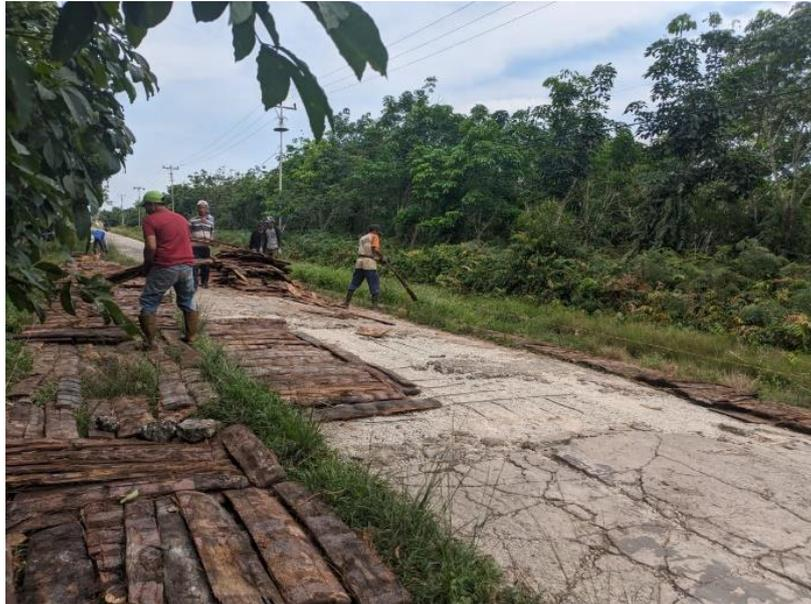
Gambar 3.1 Penyusunan gambangan (uyung sagu)
