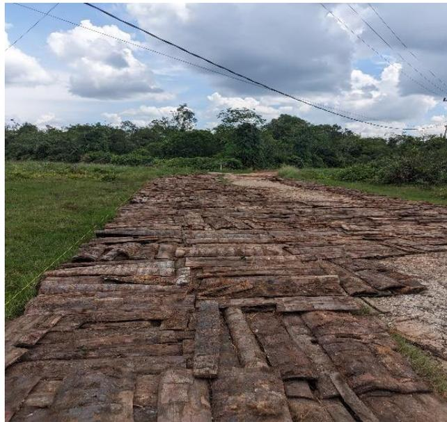
Gambar 4.1 Penyusunan uyung sagu diatas eksisting jalan lama
