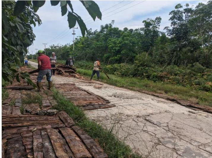
Gambar 4.3 Penyusunan gambangan (uyung sagu)
