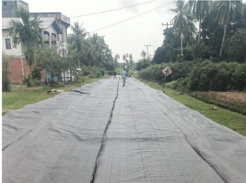
Gambar 3.2 Proses pemasangan geotextile
