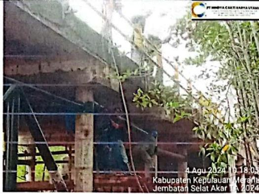
yang baru karna bracing eksisting telah mengalami korosi akibat karat/kerusakan degradasi logam akibat reaksi dengan lingkungan yang korosi/serangan yang merusak logam.
