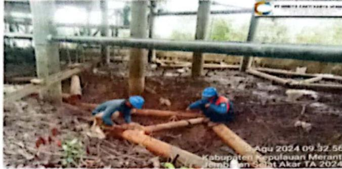
Melakukan pergantian bracing existing di ruas jalan teluk Belitung dengan yang baru, karna bracing existing telah mengalami kerusakan/korosi yang harus di perbaiki/di ganti dengan yang baru.
