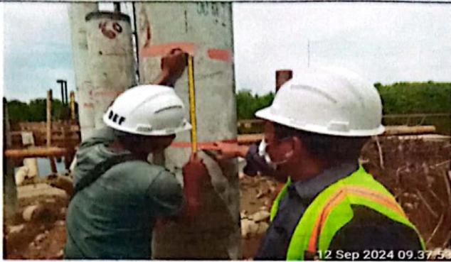
Melakukan pengukuran untuk cutting of pile sesuai denan levasi yang telah di tentukan.
