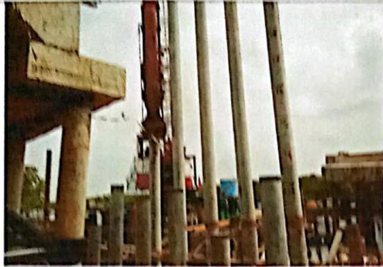
Kelanjutan proses pemancangan tiang pancang beton pratekan pracetak (Spun pile) menggunakan hammer diesel 3.3 ton.
