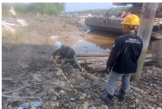
**Gambar 3. 2** Pekerjaan Pengukuran Elevasi Tiang Pancang
