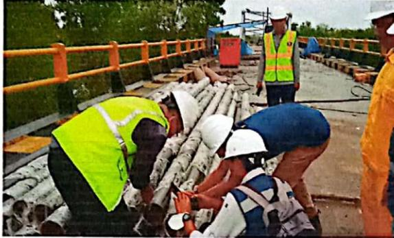
Pengukuran diameter spun pile adalah untuk mengetahui apakah ukuran spun pilenya itu sesuai dengan perencanaan.
