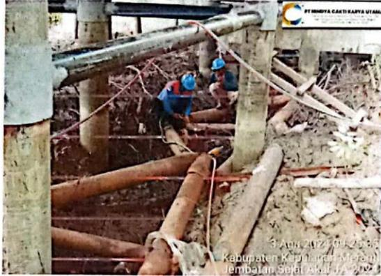
Kelanjutan pemasangan bracing di ruas jalan Delitung, karna akan di gantikan dengan yang baru sehingga bracing lebih kuat dan tahan lama.
