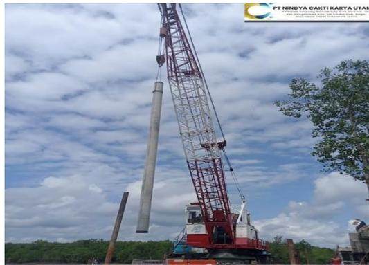
**Gambar 4. 8** Proses Pengangkatan Tiang Pancang
