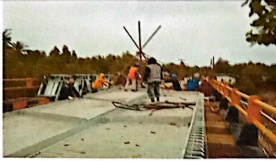
Melakukan proses penyambungan rangka girder B30 untuk di gunakan sebagai lantai beton.
