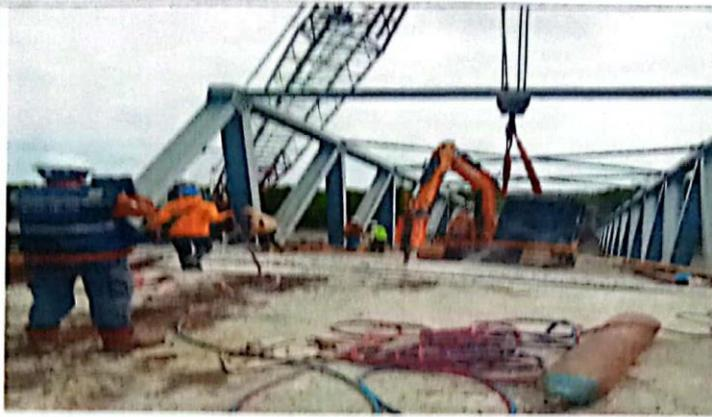
menggunakan alat berat berupa crane, karna lantai beton ini akan di pasang Kembali setelah di lakukan pembongkaran.
