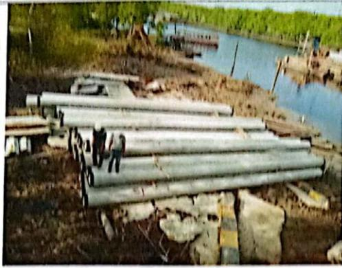
Melakukan marking permeter pada tiang pancang guna untuk memudahkan pengontrolan pada saat pemancangan tiang pancang berlangsung.
