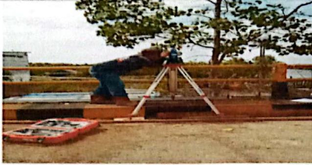
Melakukan pengukuran untuk menentukan titik koordinat untuk pancang baja.
