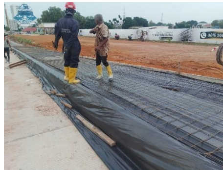
Gambar 4.1 Pemasangan Wiremesh
