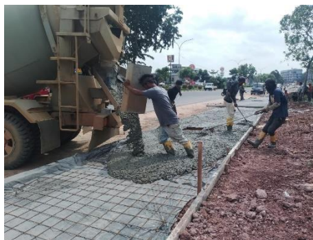
Gambar 3.12 Proses Pengecoran
