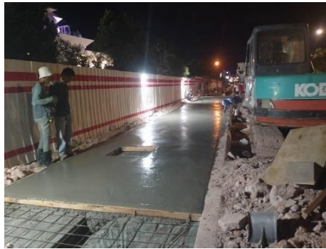
Gambar 3.13 Perataan Beton
