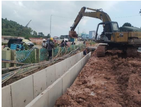
Gambar 3.1 Pemasangan Saluran
