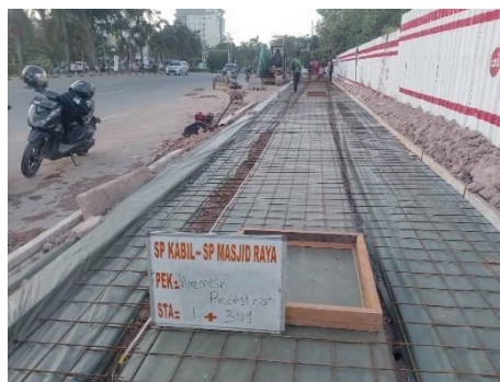
Gambar 3.10 Pemasangan Wiremesh dan Geotextile
