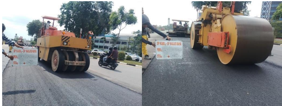
Gambar 3.6 Pemadatan Aspal
