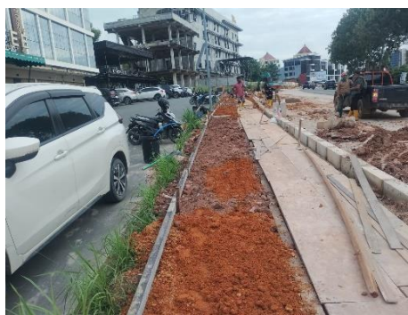
Gambar 3.9 Pemasangan Bekisting dan Mal
