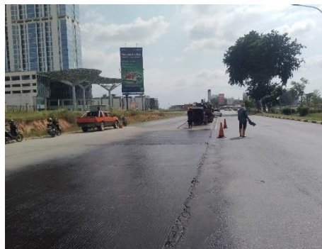
Gambar 3.3 Penyemprotan Lapis Perekat
