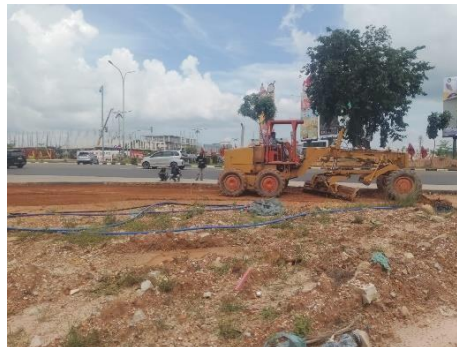
Gambar 3.17 Perataan Tanah
