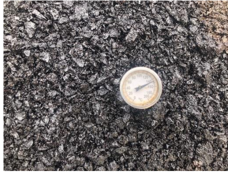
Gambar 3.4 Pengecekan Suhu Penghamparan Aspal
