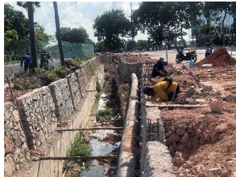
Gambar 3.15 Pemasangan Batu
